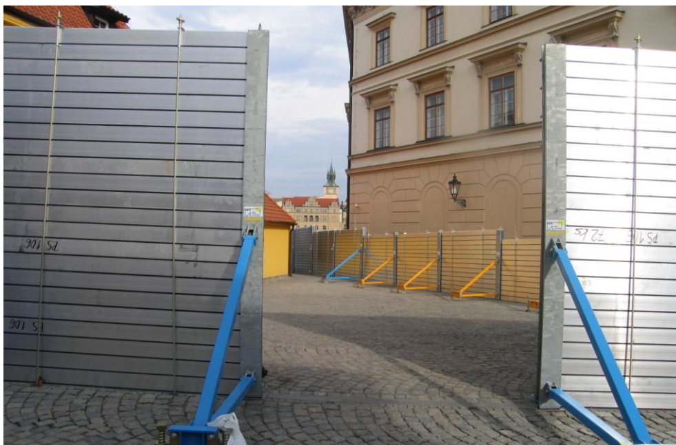
Obr. 4/2 Mobilní hrazení pro různé povodňové průtoky
