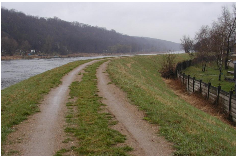
Obr. 1/1 Ochranná hráz Roztoky na Vltavě pod Prahou
