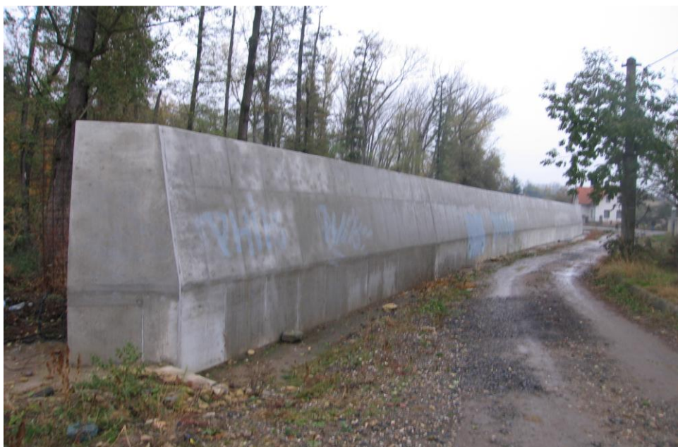
Obr. 2/2 Výstavba železobetonových zdí v obci Hořín
