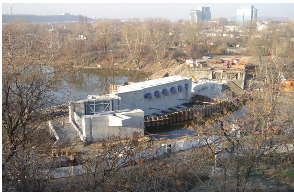
Obr. 8/1 Povodňová čerpací stanice v Libeňských přístavech, na soutoku Rokytky s Vltavou
