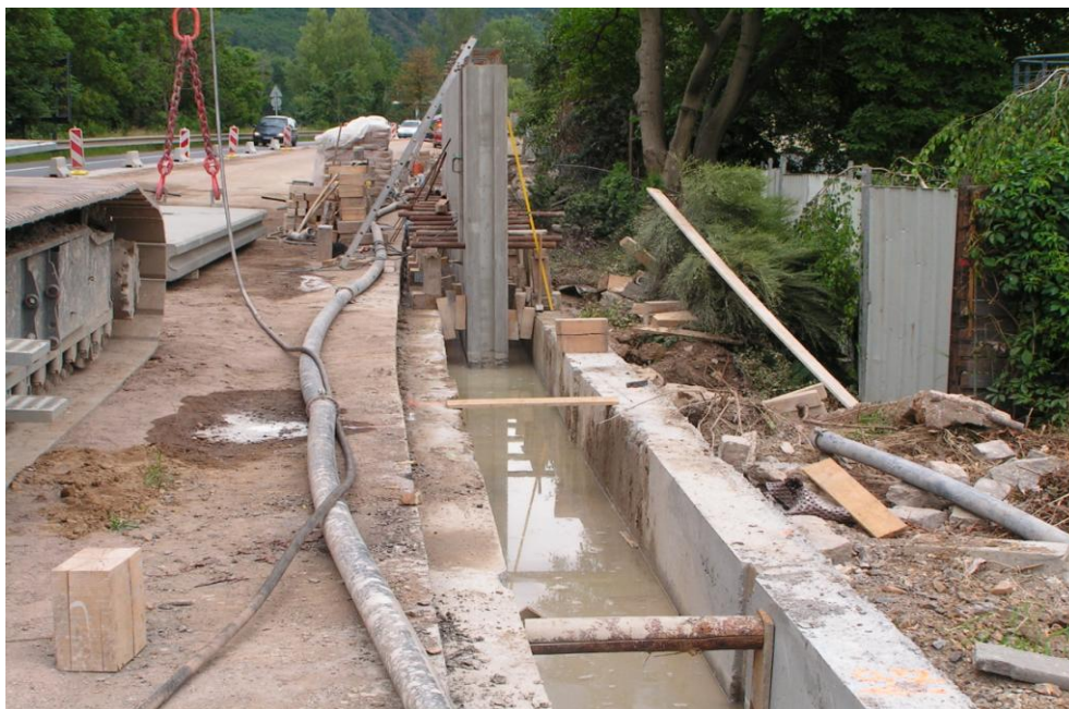
Obr. 3/1 Výstavba železobetonových prefabrikovaných stěn v Praze - Zbraslavi
