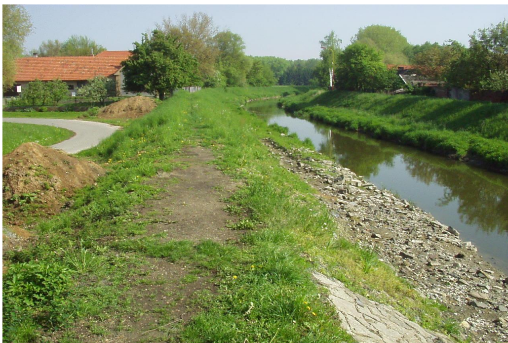
Obr. 1/2 Ochranná hráz na Mrlině v obci Vestec u Nymburka
