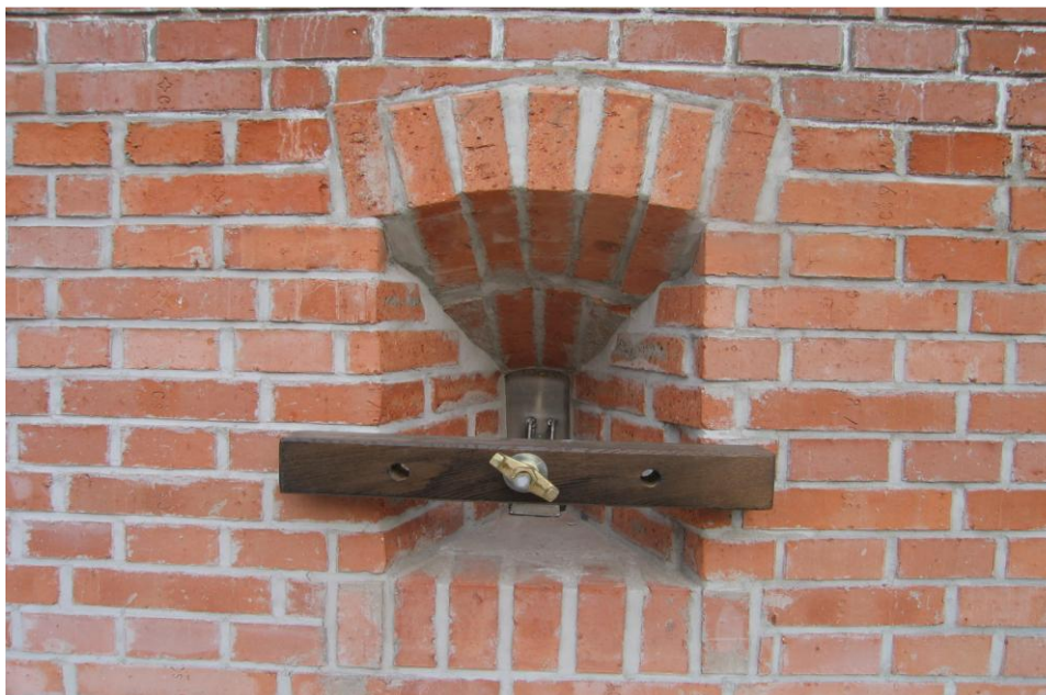
Obr. 7/2 Uzavření otvorů v ohradní zdi na Kapě. Jednoduché zakrytí otvorů je přitaženo na zeď maticí na závitové tyči
