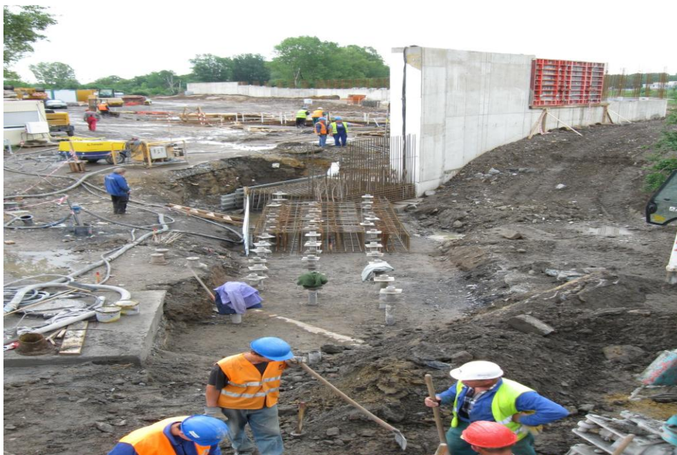
Obr. 2/1 Výstavba železobetonových zdí v Praze - Tróji
