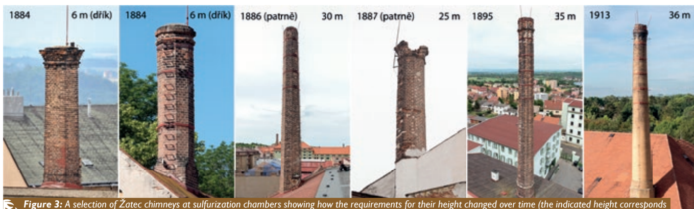
Obrázek 3: Výběr žateckých komínů sírných komor prezentující, jakým způsobem se s dobou měnily nároky na jejich výšku (uvedená výška udává hodnotu z doby výstavby komína). Foto: Martin Vonka, 2022.
