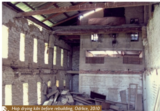
Hop drying kiln before rebuilding, Odrlice, 2010 Sušárna chmele před rekonstrukcí, Odrlice, 2010
