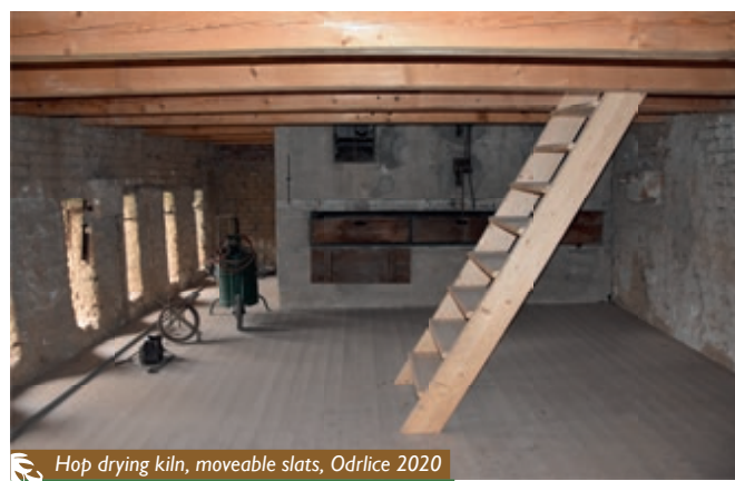
Hop drying kiln, gaps for access of drying air, Odrlice, 2020 Sušárna chmele, šterbiny pro přívod vzduchu k sušení, Odrlice, 2020
