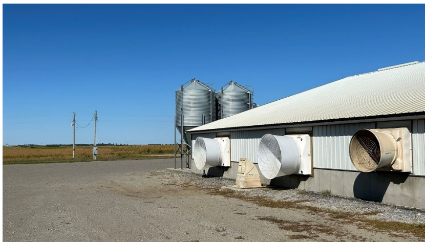
Obrázek 2.112: Stěnové ventilátory pro odvod vzdušiny z prostoru stáje s kombinací ventilátorů pro odsávání vzdušiny z podroštových prostorů
