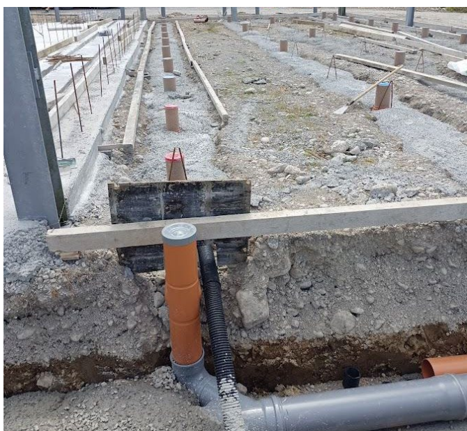
Obrázek 2.47: Konstrukce kejdového kanálu s řadou dílčích odtoků
