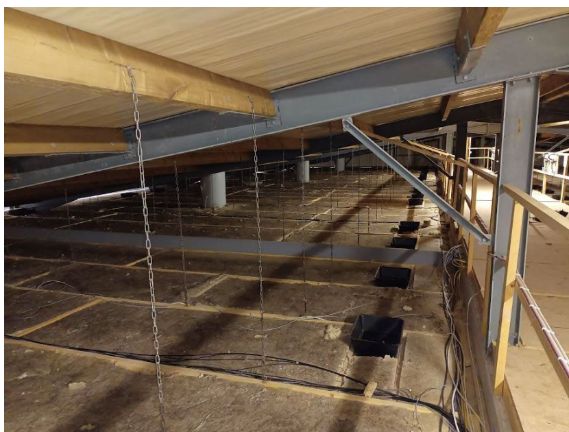
Obrázek 2.15: Pohled na izolovaný perforovaný strop s přísávacími klapkami
