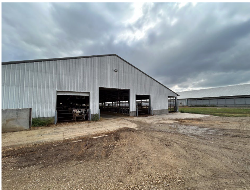
Obrázek 2.95: Hala pro ustájení dojnic
