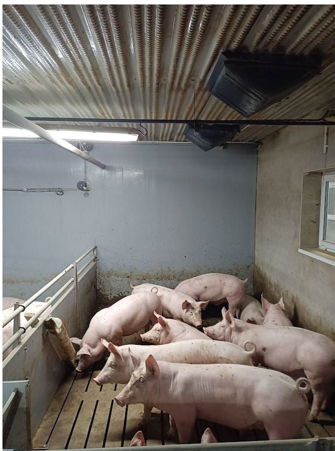
Obrázek 2.13: Pohled na perforovaný strop a otvory kryté přisávacími klapkami
