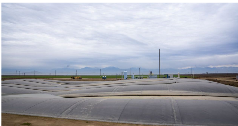
Obrázek 2.84: Zakrytí lagun pomocí neprodyšného materiálu (Mitloehner, 2022)
