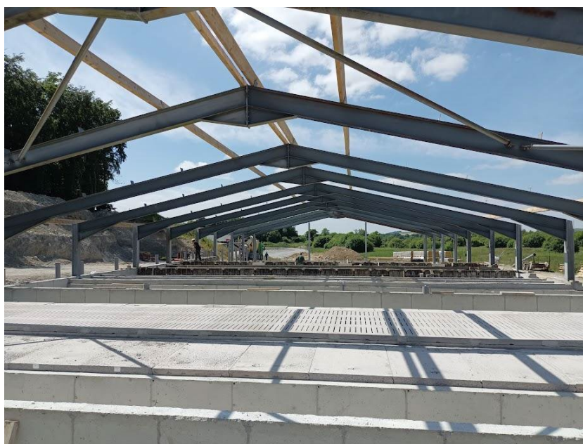
Obrázek 2.48: Pohled na konstrukci haly pro výkrm prasat
