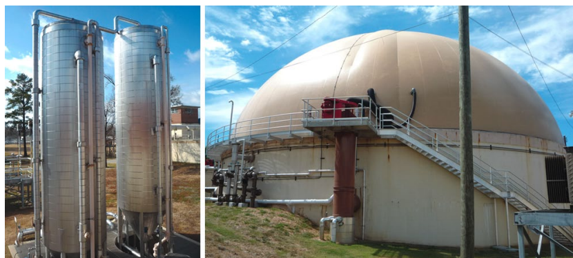
Obrázek 2.85: Nadzemní kontinuální reaktor s technologií promíchávání kejdy (BioCycle, 2012)
