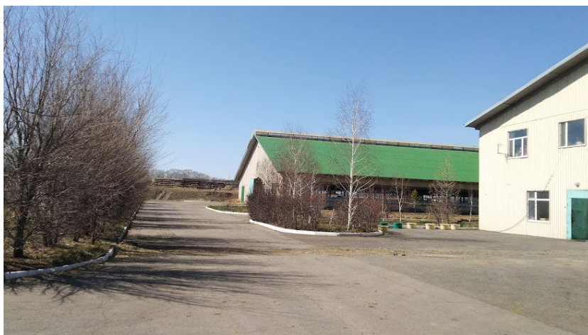
Obrázek 2.26: Vlevo je chovná hala, vpravo administrativní budova s dojírnou
