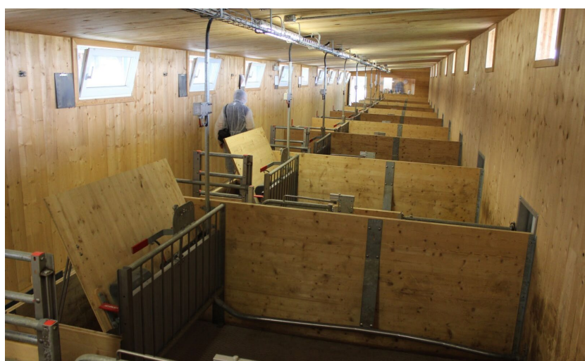
Obrázek 2.58: Boční kovová zábrana zabraňující zalehnutí selat u boku kotce (Fuka, 2022)
