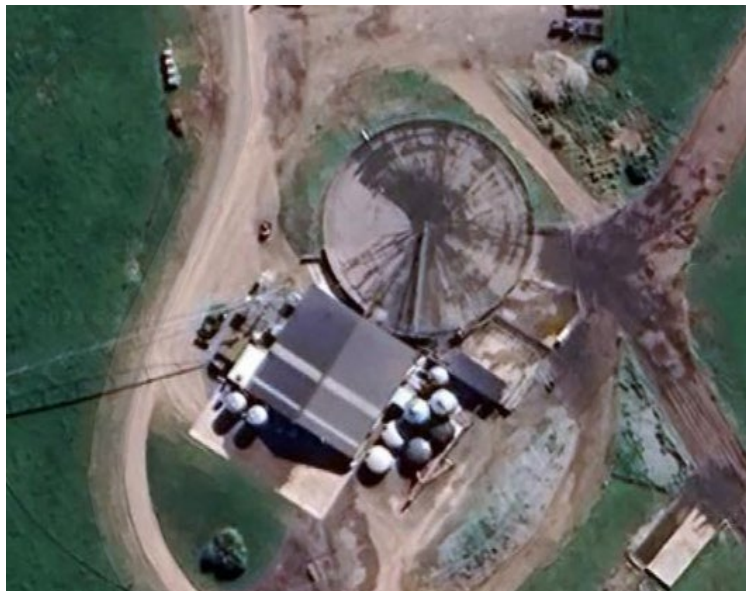
Obrázek 2.50: Pohled na dojírnu včetně čekárny s přiháněčem (Google Maps, b.r.a)
