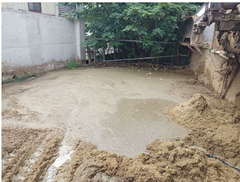
Obrázek 2.66: Betonová jímka na kejdu
