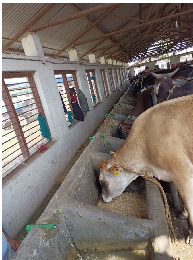
Obrázek 2.31: Betonová koryta pro podávání krmné dávky
