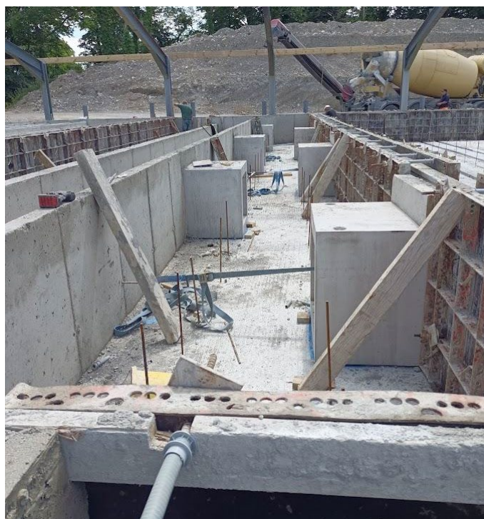
Obrázek 2.43: Prostup pro příchozí vzdušinu mezi dvěma chovnými kotci
