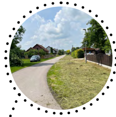
Kněžice, Středočeský kraj 2013, Oprava silnic
