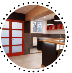
Třeštice, Kraj Vysočina 2019, Rekonstrukce budovy kulturního domu
