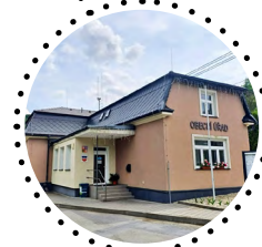
Rajnochovice, Zlínský kraj 2015, Modernizace obecního úřadu
