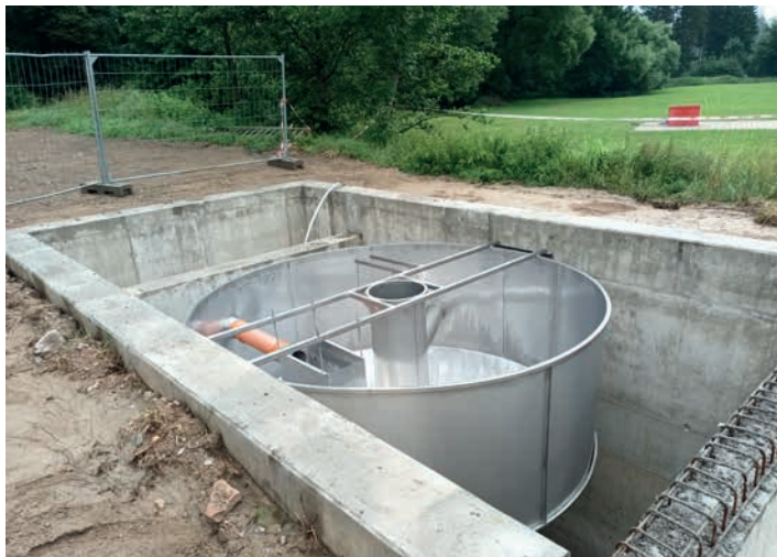
Želeč – dostavba kanalizace a čištění odpadních vod v místní části Bezděčín – spolufinancováno z dotačních prostředků MZe ve výši 5,6 mil. Kč
