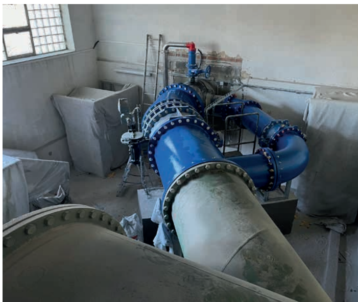
Obnova řadu surové vody Římov – Plav, II. etapa – spolufinancováno z dotačních prostředků MZe ve výši 132,0 mil. Kč
