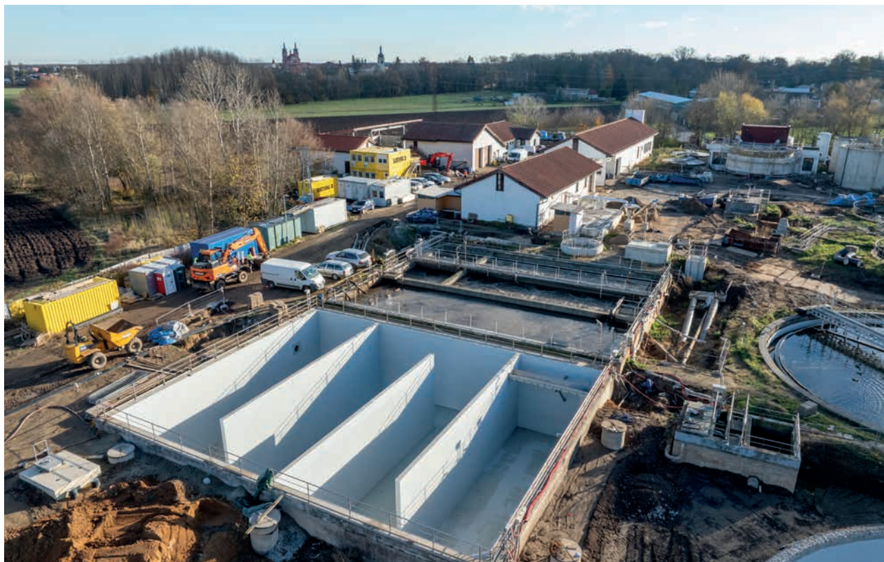
Intenzifikace a zkapacitnění ČOV Brandýs nad Labem – I. etapa – spolufinancováno z dotačních prostředků MZe ve výši 100,0 mil. Kč
