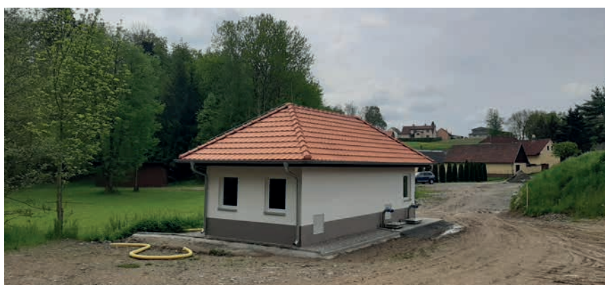
Želeč – dostavba kanalizace a čištění odpadních vod z místní části Bezděčín – spolufinancováno z dotačních prostředků MZe ve výši 5,6 mil. Kč
