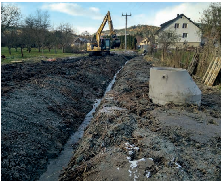
Kanalizace a ČOV Chlumany – spolufinancováno z dotačních prostředků MZe ve výši 22,1 mil. Kč
