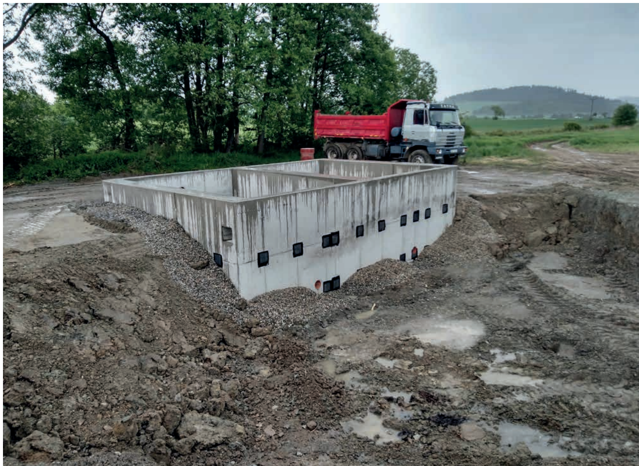
Kanalizace a ČOV Chlumany – spolufinancováno z dotačních prostředků MZe ve výši 22,1 mil. Kč
