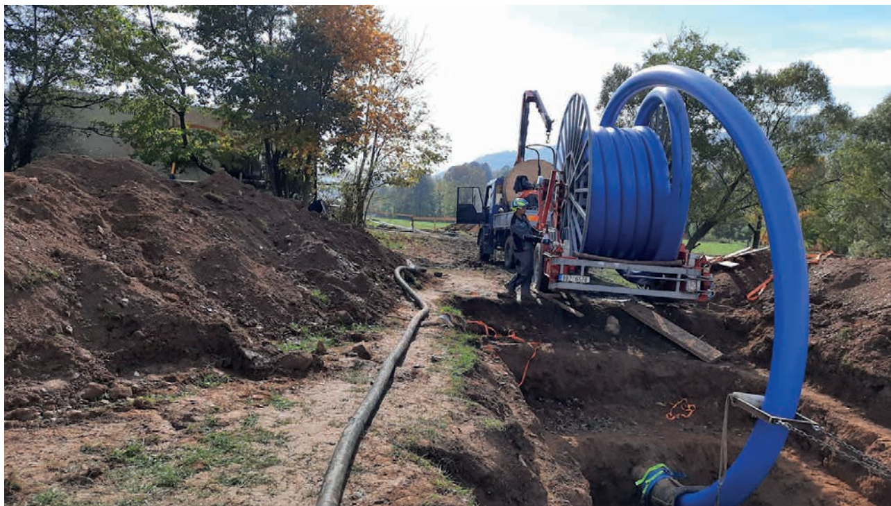
Obnova příváděcích vodovodních řadů Kouty n. D. – Šumperk ETAPA I. SO 01 a SO 02 – spolufinancováno z dotačních prostředků MZe ve výši 48,1 mil. Kč
