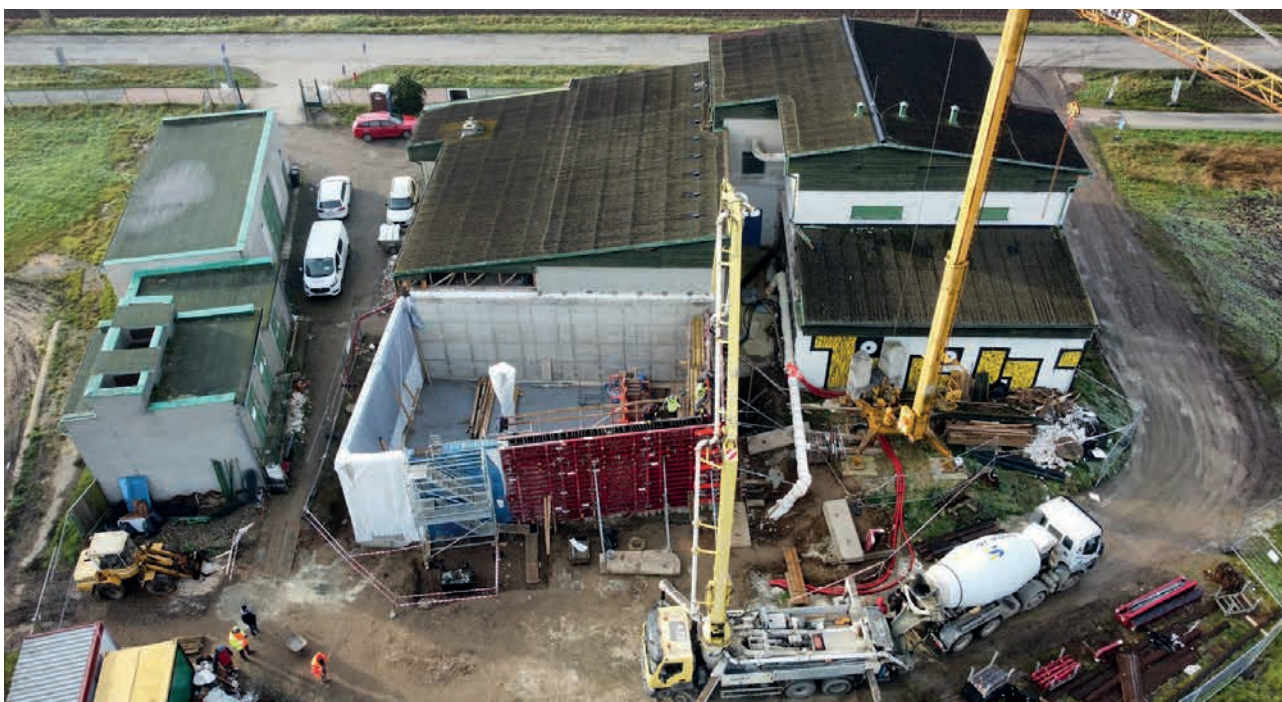
ÚJV Moravichany – dostavba akumulační nádrže – spolufinancováno z dotačních prostředků MZe ve výši 15,3 mil. Kč
