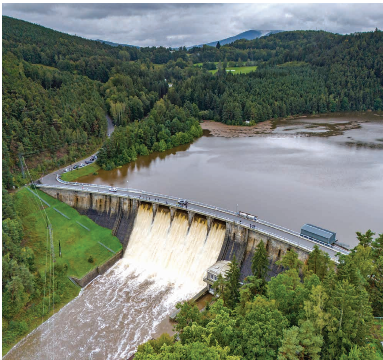
VD Husinec, povodně 15. 9. 2024 (zdroj: Povodí Vltavy)
