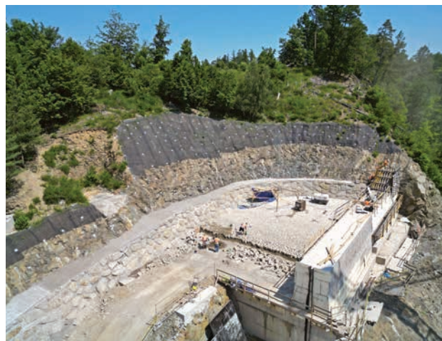
Kutřín – výstavba bezpečnostního přelivu (zdroj: Povodí Labe)
