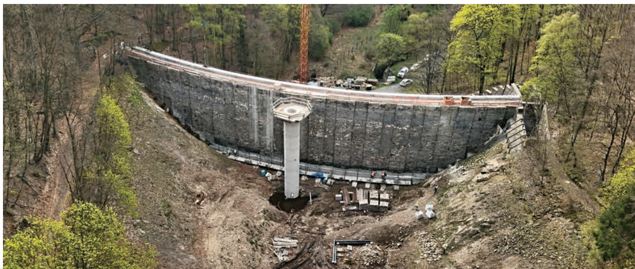
VD Jezeří, rekonstrukce (zdroj: Povodí Ohře)
