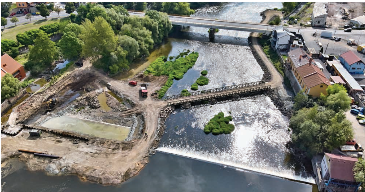
Kadaň, rekonstrukce jezu (zdroj: Povodí Ohře)
