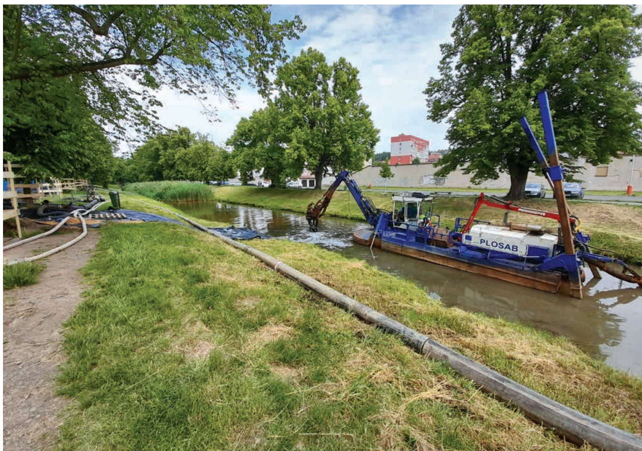
Rakovnický potok, Rakovník, odstranění nánosů z koryta (zdroj: Povodí Vltavy)
