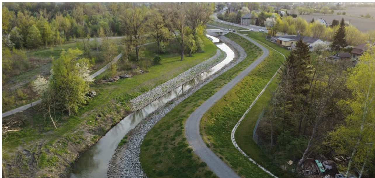
Odra, dokončená část Pudlovské hráz v Bohumíně (zdroj: Povodí Odry)
