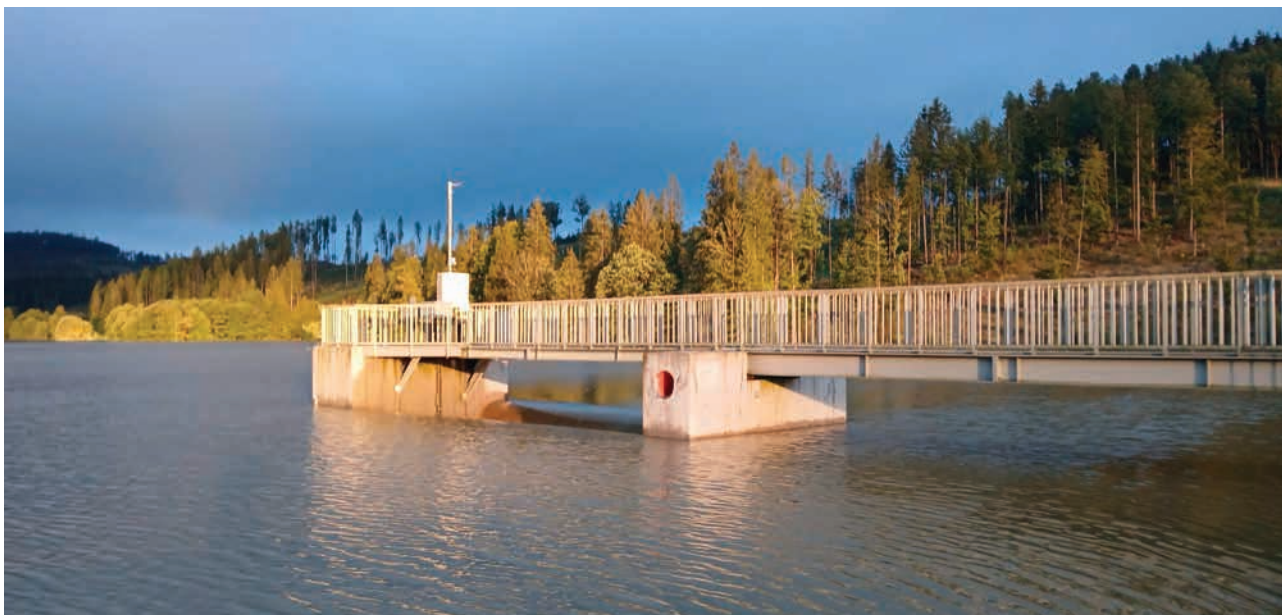
Povodeň SN Jelení na Kobylym potoce v Karlovicích ve funkci (zdroj: Povodí Odry)
