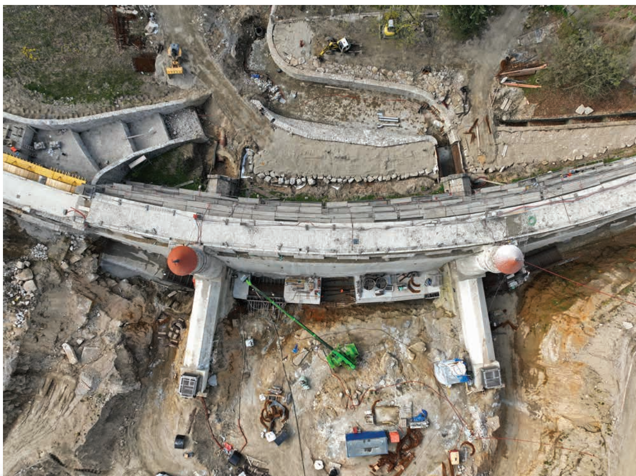
Harcov, injektáž (zdroj: Povodí Labe)
