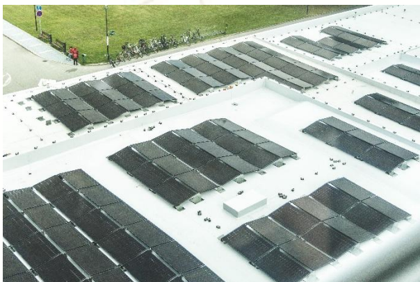
Instalace fotovoltaiky v Lázních Třeboň
