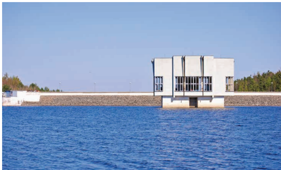
Vodárenská nádrž Římov
