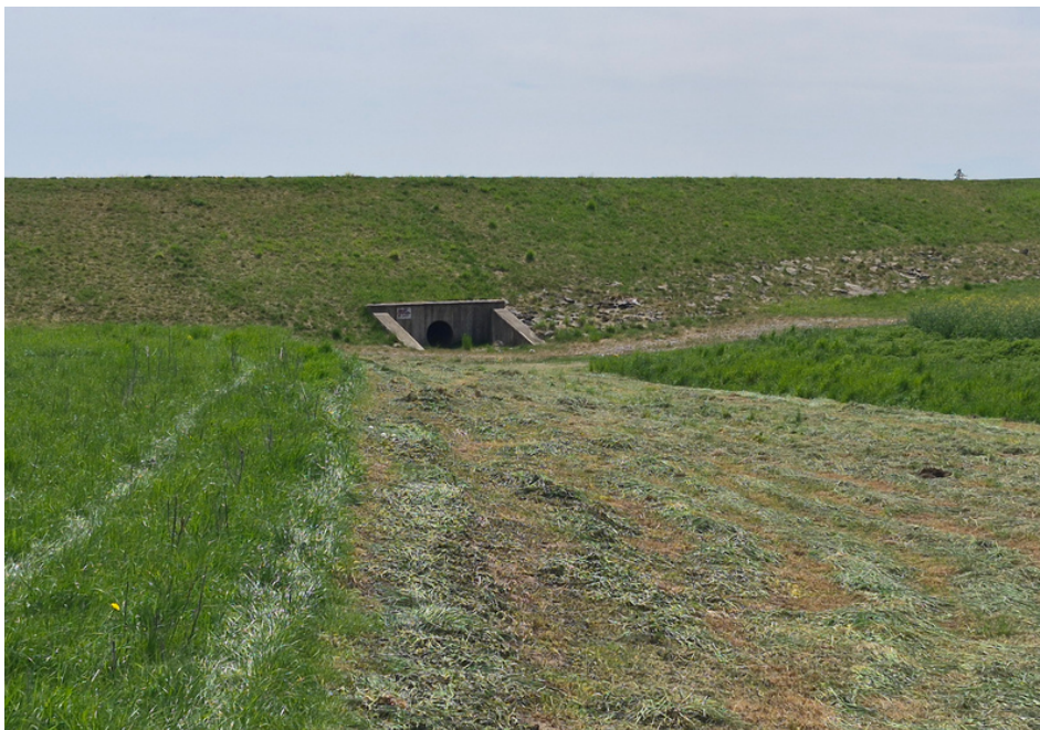
Ochrana obce před povodní - suchý polder ve Vraclavi. Foto: Archiv CSV
