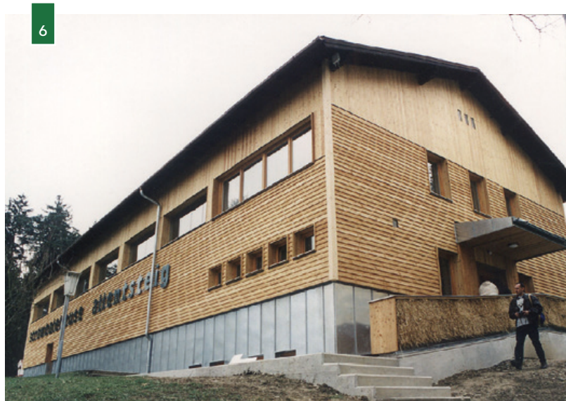
Obr. 6, 7 Rekonstrukce školy a přístavby tělocvičny, Allentsteig, Rakousko, 2003. Budova byla realizována jako pilotní projekt a první veřejná stavba s použitím slámy v zemích EU. Při realizaci byl kladen důraz na to, aby všechny použité materiály (dřevo, sláma) pocházely z místních zdrojů (foto: A. Brotánek).
