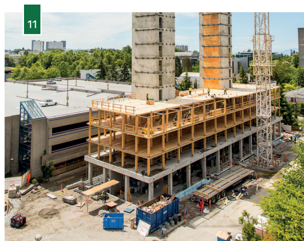
Obr. 10 Lehká sloupková konstrukce na bázi „2x4“ (zdroj: www.kubus.cz ). Obr. 11 Těžký dřevěný skelet (zdroj: www.archdaily.com ).
