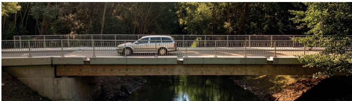
Obr. 29 Drobné stavby ve veřejném prostoru, nouzový přístřešek Bukovec (Lesní správa Jablunkov), rozhledna Velký Javorník (Lesní správa Frýdek-Místek), dřevobetonový silniční most v Třebíči, osazen automatickým vážením a autodiagnostikou technického stavu (zdroj: www.lesycr.cz )
