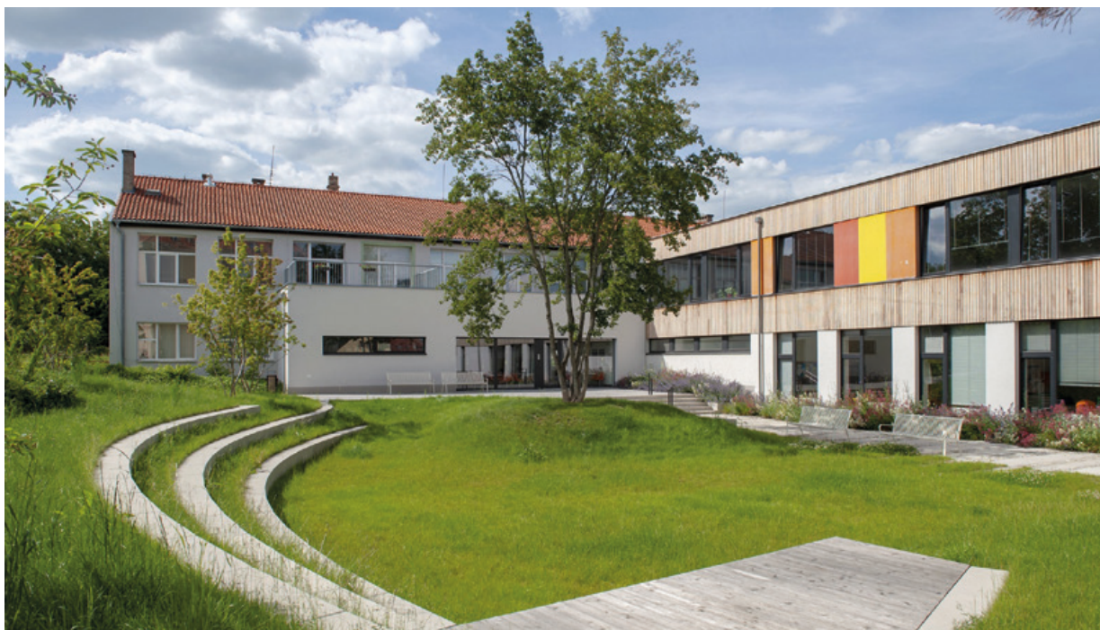
Obr. 34 ZŠ a MŠ Oty Pavla v Buštěhradě – upravené venkovní plochy před nástavbami a jídelnou (zdroj: facebook ZŠ a MŠ Oty Pavla, Buštěhrad)
