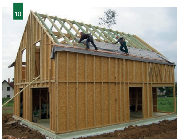
Obr. 10 Lehká sloupková konstrukce na bázi „2x4“ (zdroj: www.kubus.cz ). Obr. 11 Těžký dřevěný skelet (zdroj: www.archdaily.com ).
