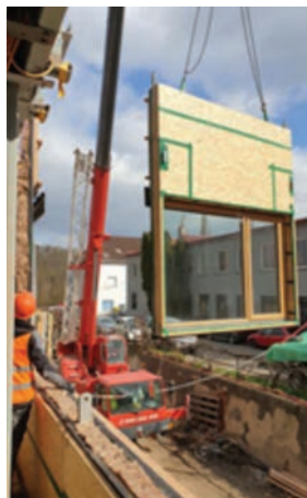
Obr. 32 Přestavba střední školy COPTH Českobrodská v Praze – celkový pohled na budovu, pohled na východní fasádu, osazování LOP na bázi dřeva systému ENVILOP (zdroj: www.ecoten.cz )
