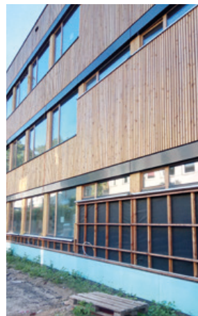
Obr. 32 Přestavba střední školy COPTH Českobrodská v Praze – celkový pohled na budovu, pohled na východní fasádu, osazování LOP na bázi dřeva systému ENVILOP (zdroj: www.ecoten.cz )
