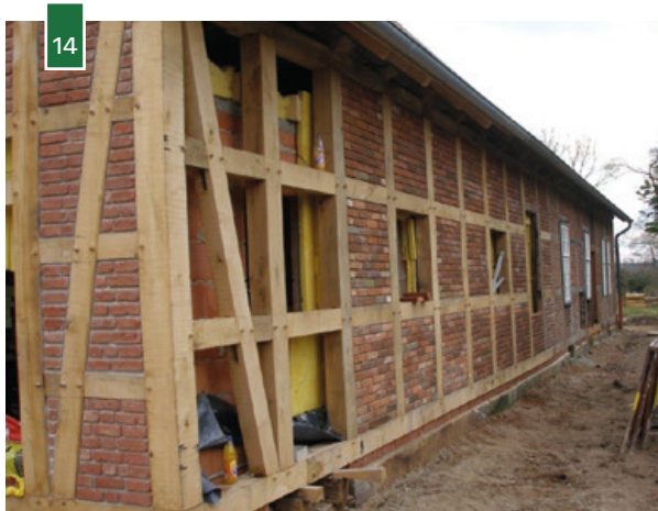
Obr. 12 Panelový stěnový systém CLT ( www.novatop.cz ). Obr. 13 Konstruktivní hybrid inspirovaný halovou konstrukcí s tuhými rámy (zdroj: www.kubus.cz ). Obr. 14 Hrázděná stavba (zdroj: www.pinterest.com ). Obr. 15 Roubenka (zdroj: www.archiv.hn.cz ).
