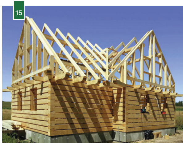
Obr. 12 Panelový stěnový systém CLT ( www.novatop.cz ). Obr. 13 Konstruktivní hybrid inspirovaný halovou konstrukcí s tuhými rámy (zdroj: www.kubus.cz ). Obr. 14 Hrázděná stavba (zdroj: www.pinterest.com ). Obr. 15 Roubenka (zdroj: www.archiv.hn.cz ).
