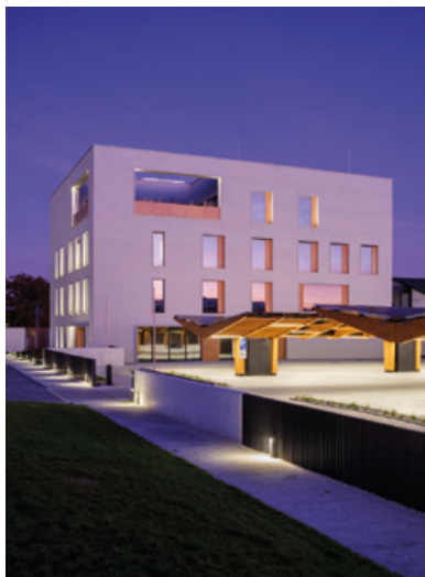
Obr. 31 Administrativní budova BUDEX HUB (zdroj: www.archiweb.cz )
