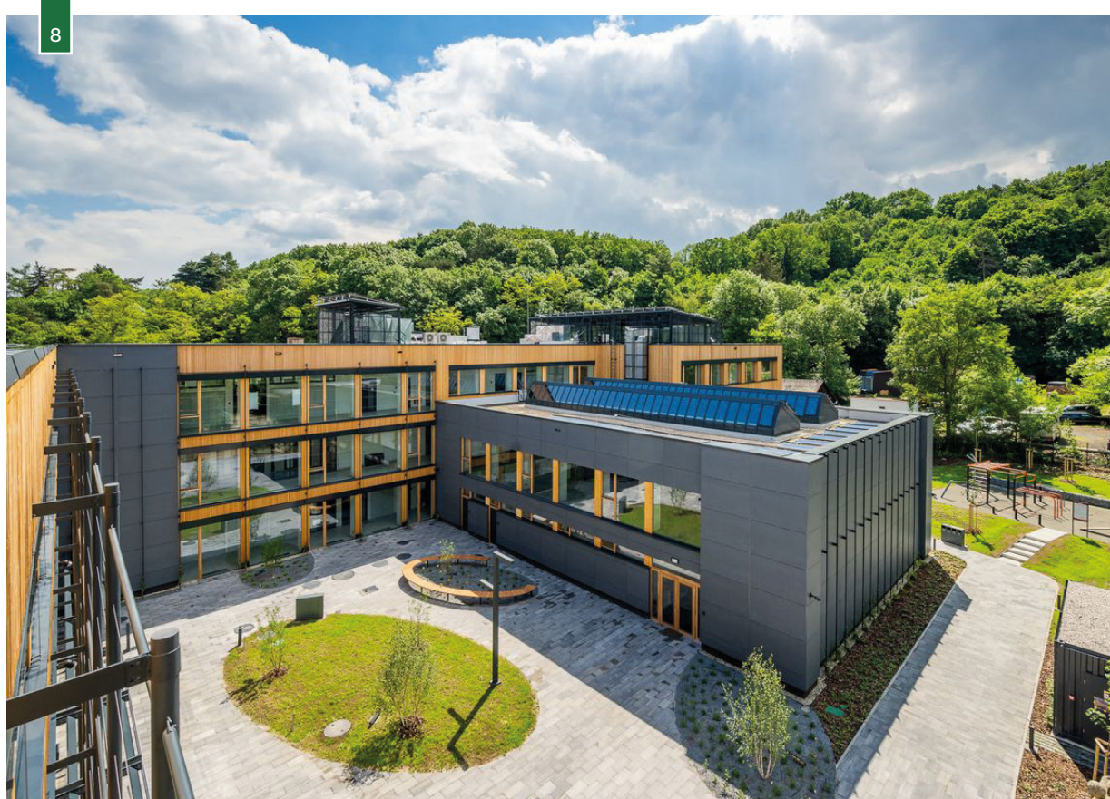
Obr. 8 Rekonstrukce Centra odborné přípravy technickohospodářské COPT, Českobrodská, Praha – komplexní rekonstrukce školy s využitím obvodového pláště z prefabrikovaných dřevěných panelů ENVILOP, vyvinutých na UCEEB ČVUT. Metodika SBToolCZ byla použita jako optimalizační nástroj pro dosažení komplexní kvality stavby. Při vlastní certifikaci budova obdržela nejvyšší ocenění Zlatý certifikát SBToolCZ. Stavba dostala za technickou a komplexní kvalitu řadu dalších ocenění (zdroj: www.ecoten.cz ).
