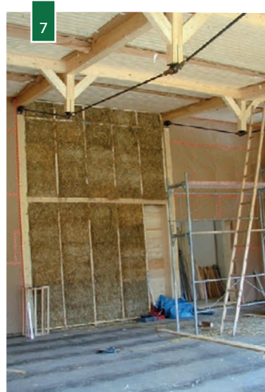
Obr. 6, 7 Rekonstrukce školy a přístavby tělocvičny, Allentsteig, Rakousko, 2003. Budova byla realizována jako pilotní projekt a první veřejná stavba s použitím slámy v zemích EU. Při realizaci byl kladen důraz na to, aby všechny použité materiály (dřevo, sláma) pocházely z místních zdrojů (foto: A. Brotánek).
