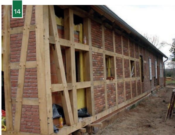
Obr. 12 Panelový stěnový systém CLT ( www.novatop.cz ). Obr. 13 Konstrukční hybrid inspirovaný halovou konstrukcí s tuhými rámy (zdroj: www.kubus.cz ). Obr. 14 Hrázděná stavba (zdroj: www.pinterest.com ). Obr. 15 Roubenka (zdroj: www.archiv.hn.cz ).
