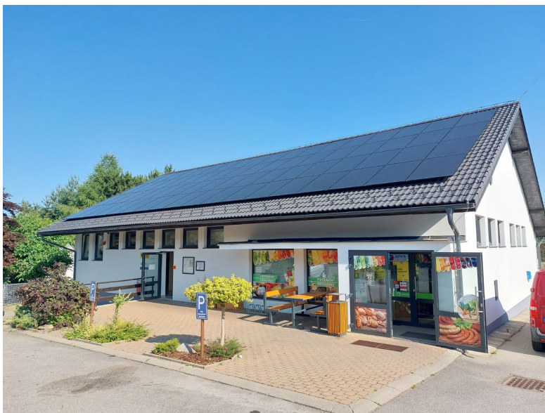
Fotografie č. 1: Budova místní prodejny s fotovoltaickými panely na střeše.
