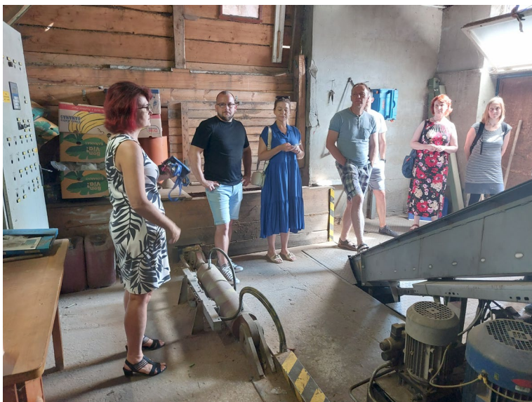
Fotografie č. 12: Výklad k zařízení pro dopravu a dávkování dřevní štěpky do kotle.
