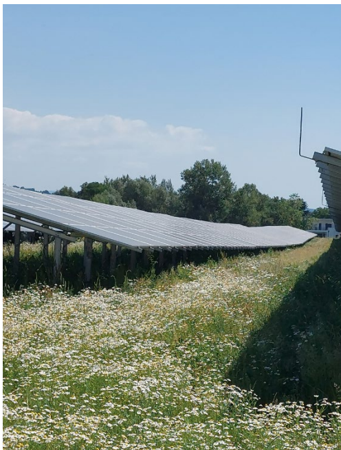
Fotografie č. 34: Agrivoltaická elektrárna kombinující výrobu elektřiny se zemědělským využitím pozemku.
