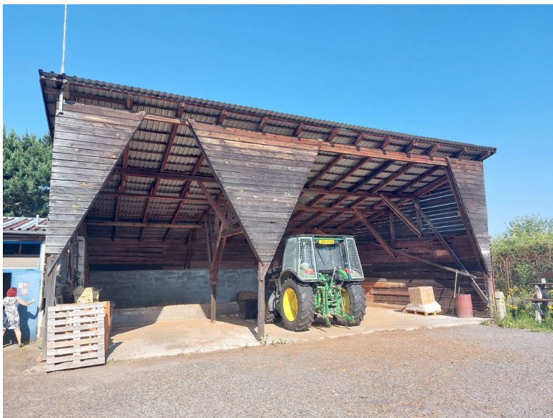
Fotografie č. 7: Vnější pohled na zastřešený sklad dřevní štěpky u kotelny.
