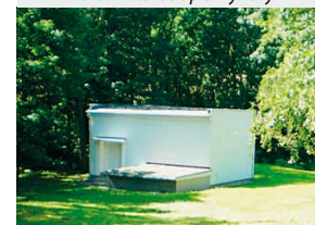
Nově opravená stavba úpravy vody
