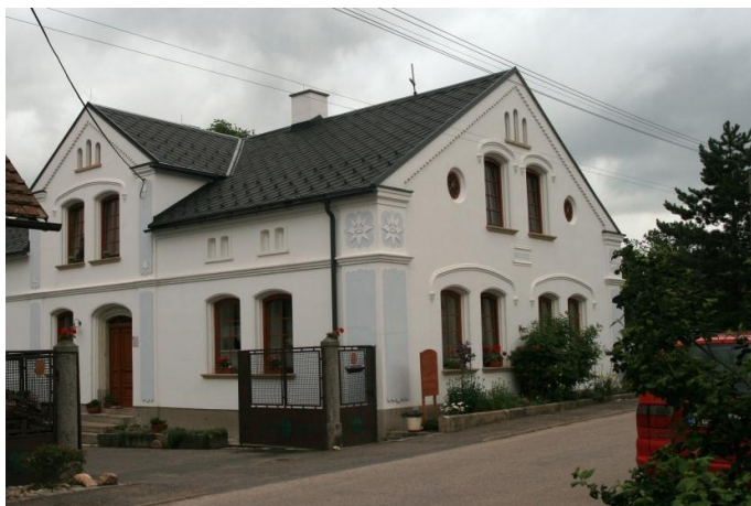
Daškovi dotáhli rekonstrukci původní budovy statku k dokonalosti.
