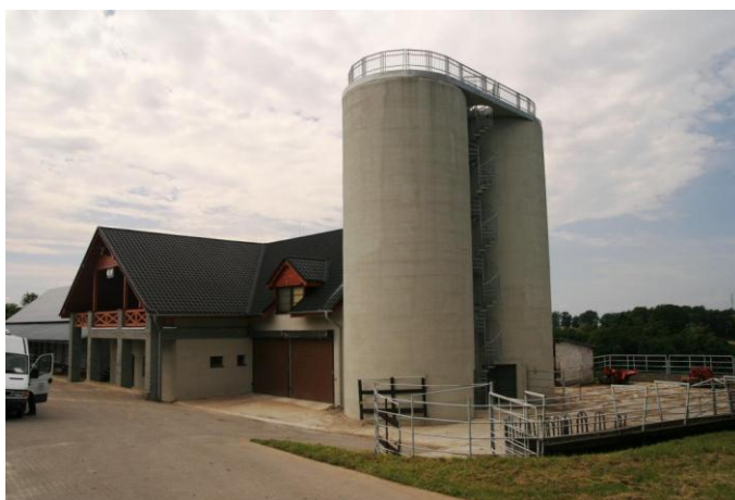
PRV bylo využito například na obnovu sila.
