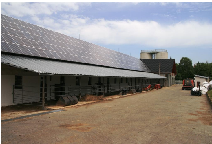
Na střeše stáje je umístěna solární elektrárna o výkonu 2 x 30 kW.
