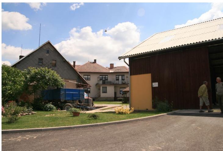
Z projektu PRV byla postavena hala na stroje.
