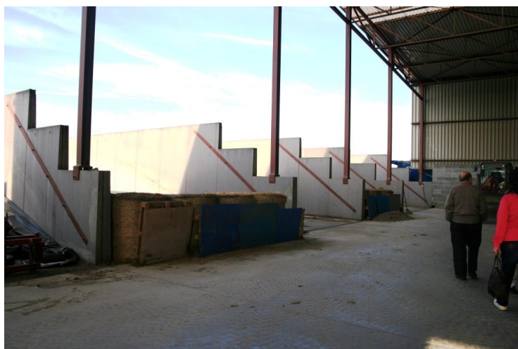
Sklad senáže byl postaven s dotací ve výši 1,4 mil. korun.
