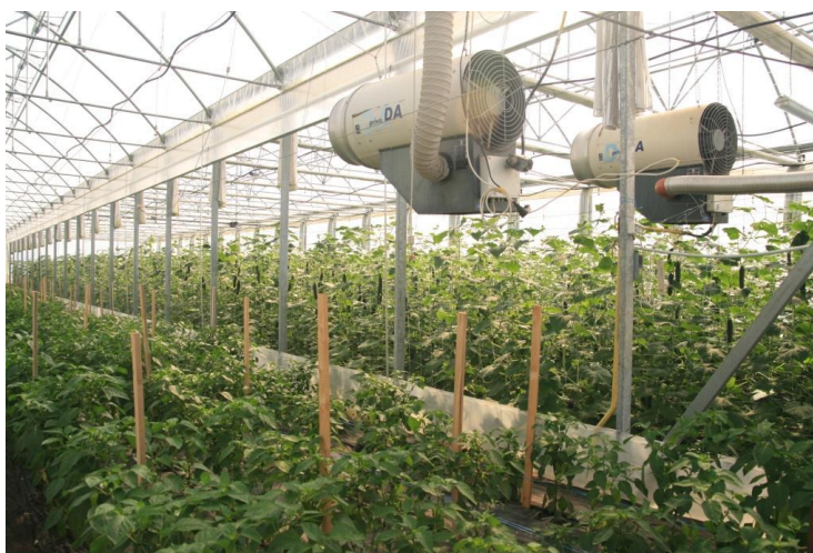
Vlhkost a teplota ve fóliovníku je automaticky hlídána a řízena.
