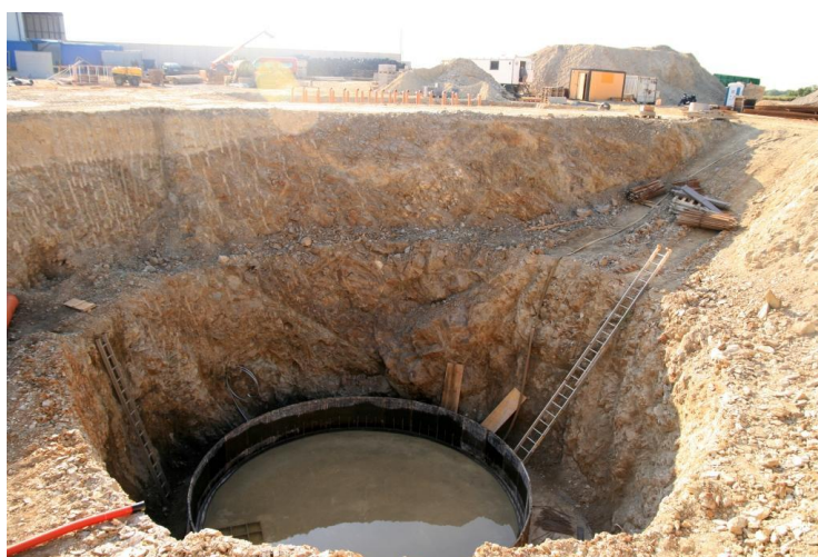
Na farmě v Holi v současnosti probíhá stavba stáje s kejdovým hospodářstvím
