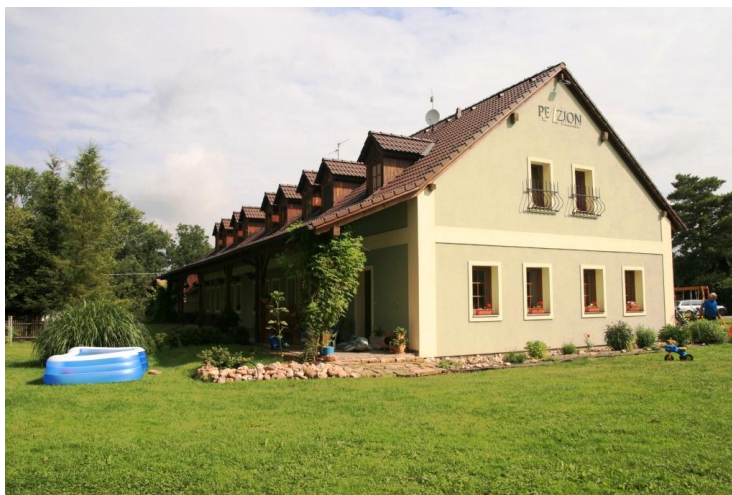
Penzion ve Slavětíně vznikl bez podpory z dotačních fondů.
