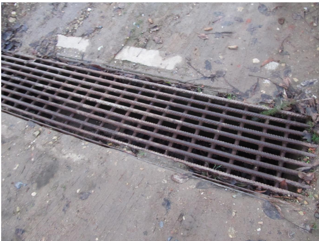
Obrázek 7.5: Horská dešťová vpust před napojením údolnicové polní cesty procházející řešeným územím na místní komunikaci
