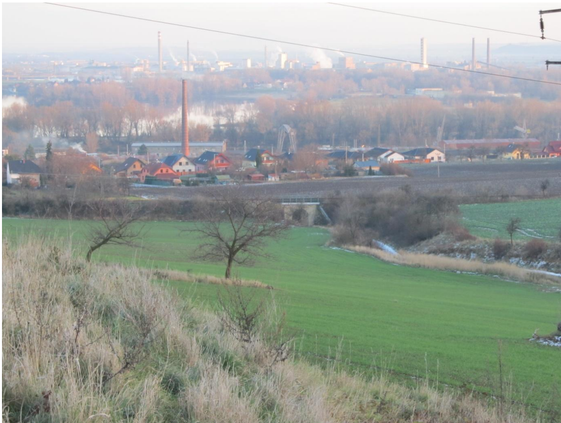
Obrázek 7.22: Pohled na křižení železniční trati a cesty v řešeném povodí
