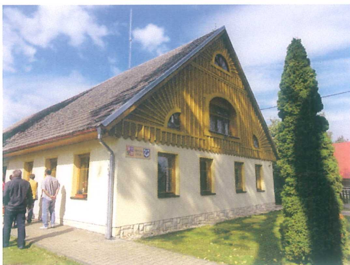
Velké Petrovice – obecní úřad, obnova návsi
