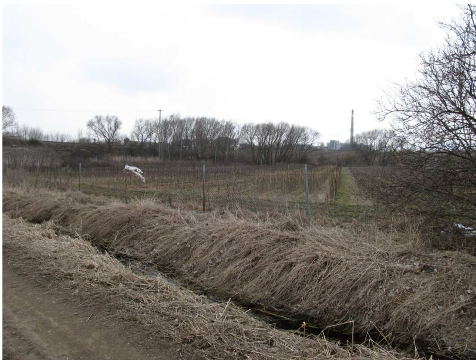
Foto 9.2: Vodní tok Močidla nad křížením s železniční tratí (27. 3. 2013)
