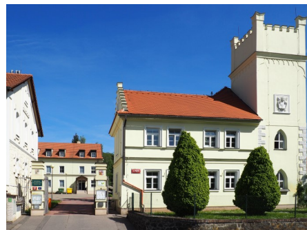
Sídlo Odboru osiv a sadby Praha Motol
