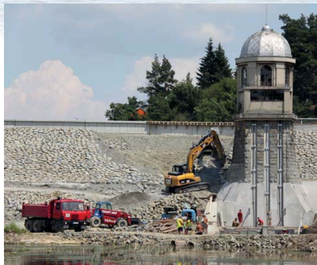
Rekonstrukce VD Plumlov
