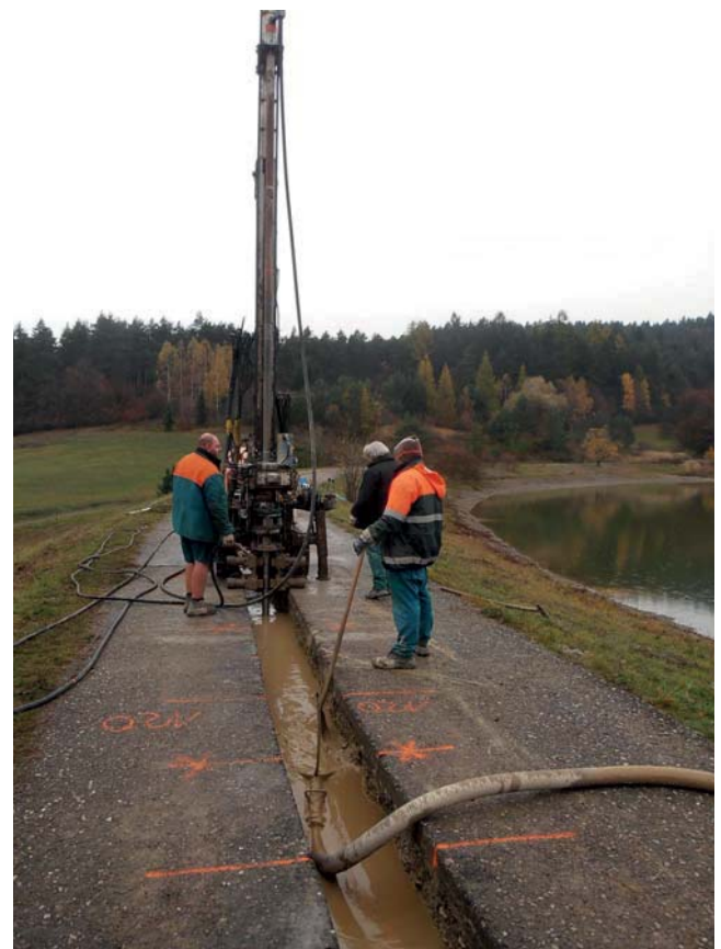
Oprava hráze, VN Všemina
