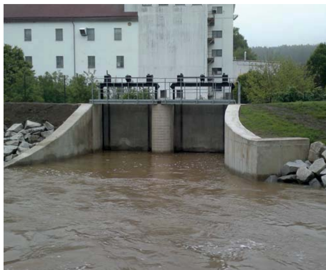
Klabava, ochranná hráz Dýšina-Nová Huť - stavidlový uzávěr
