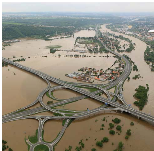
Vltava - soutok s Berouňkou, povodeň červen 2013, Lahovice - Radotín - Velká Chuchle
