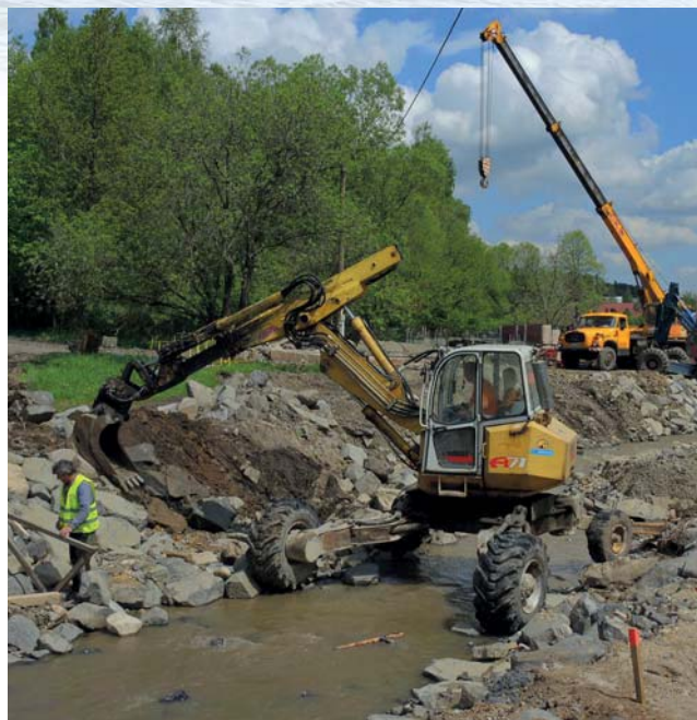
Oleška - úprava koryta, Heřmanice
