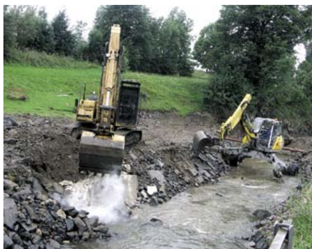
Oleška - obnova koryta, Heřmanice
