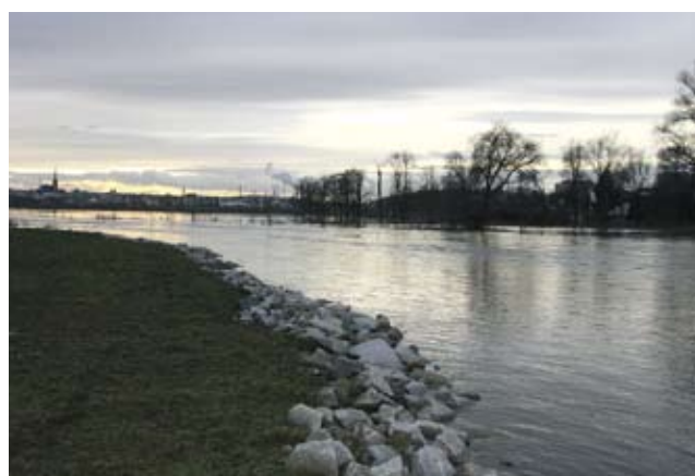
Berounka - protipovodňová opatření, Plzeň - Roudná
