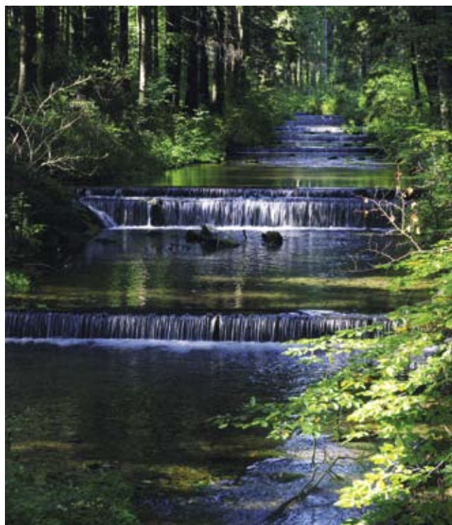
Olešnice - úprava bystřiny, Ondřejovice
