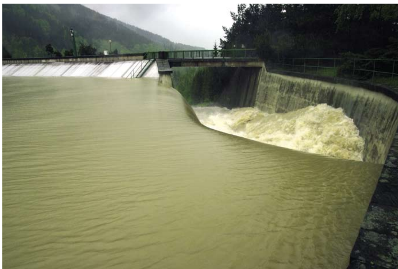
Bezpečnostní přeliv za kulminace povodně - květen 2010, VD Morávka
