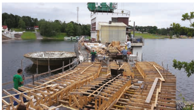
VD Hracholusky, před rekonstrukcí přemostění z hráze ke sdruženému objektu (autor: Ondřej Hrazdira)
