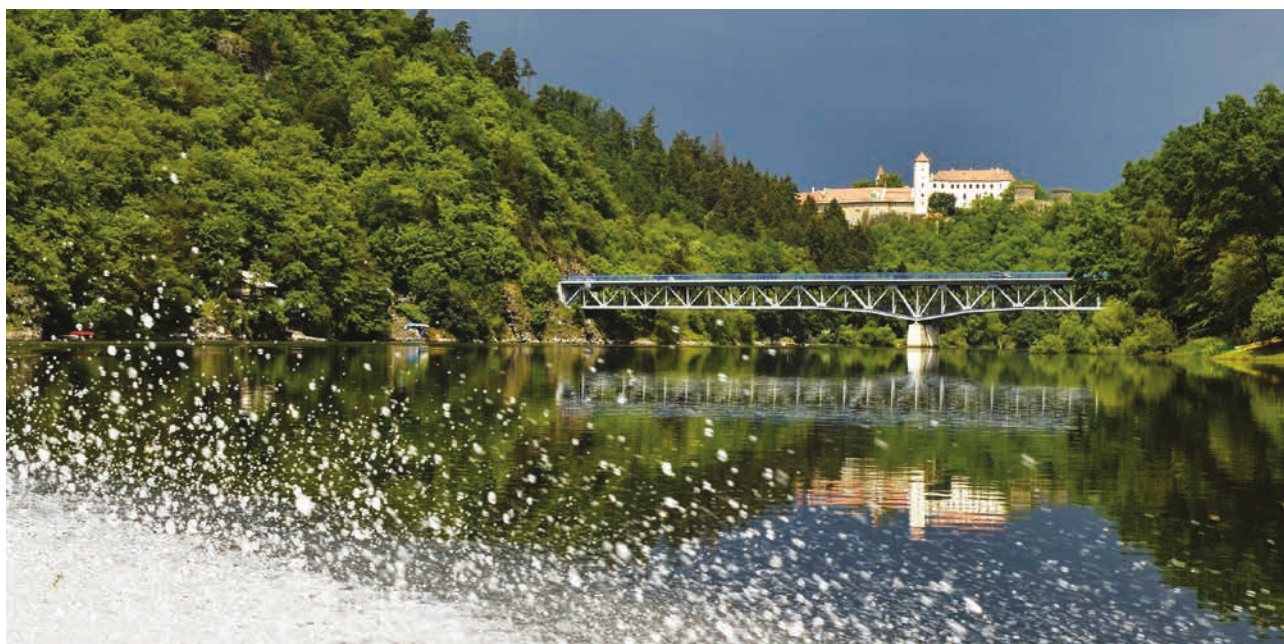
Vodní nádrž Vranov (zdroj: Povodí Moravy, s. p.)
