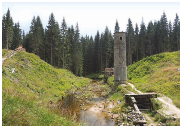
Bílá Desná, protřezaná přehrada (zdroj: Povodí Labe, s. p.)
