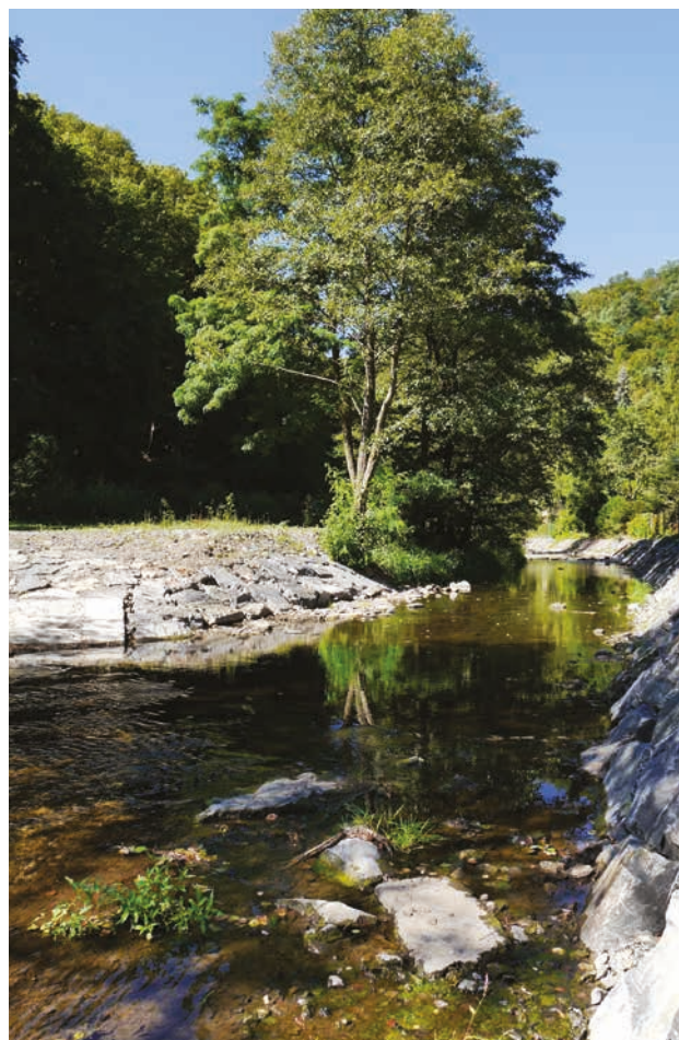
Kocába, Masečín, oprava opevnění koryta (autor: Šárka Hermanová)
