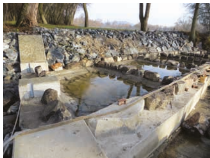
Úhlava, rekonstrukce jezu Poborovice 3 (autor: Miloslav Křen)
