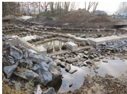
Úhlava, rekonstrukce jezu Poborovice 2 (autor: Miloslav Křen)
