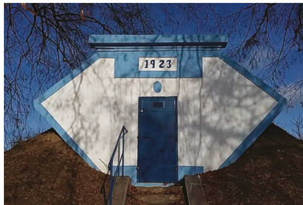
Mšeno Sedlec, zemní vodojem, Mšenský skupinový vodovod, realizováno 1922–1923 (autor: Radek Hospodka)
