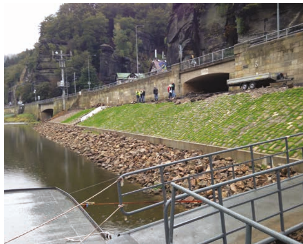
Labe, Hřensko-oprava břehového opevnění (zdroj: Povodí Labe, s. p.)
