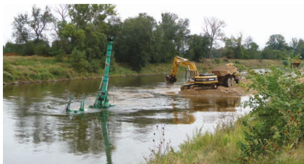
Vltava Vraňany, odtěžení nánosů a oprava opevnění (autor: Richard Pawinger)
