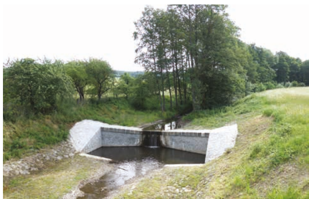
DVT Vlčí potok, Jíno, oprava stupně (autor: Jan Bušek)
