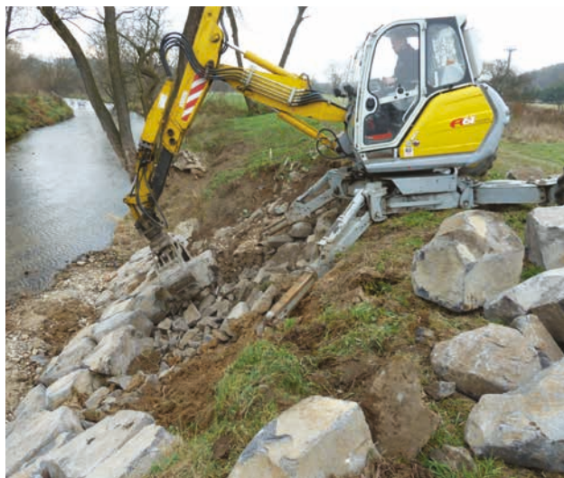
Smědá, Poustka, oprava břehové nádrže (zdroj: Povodí Labe, s. p.)
