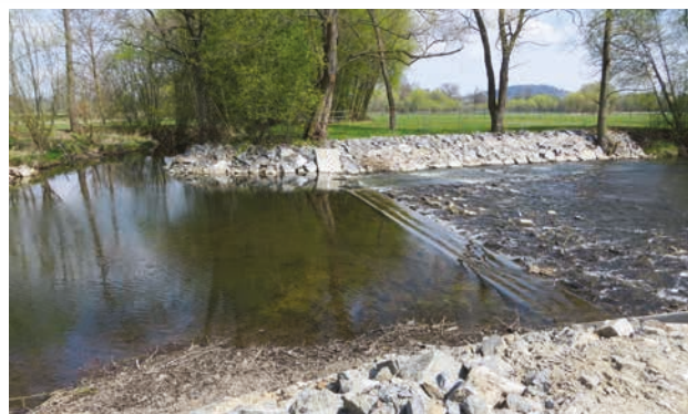
Úhlava, rekonstrukce jezu Poborovice 1 (autor: Miloslav Křen)
