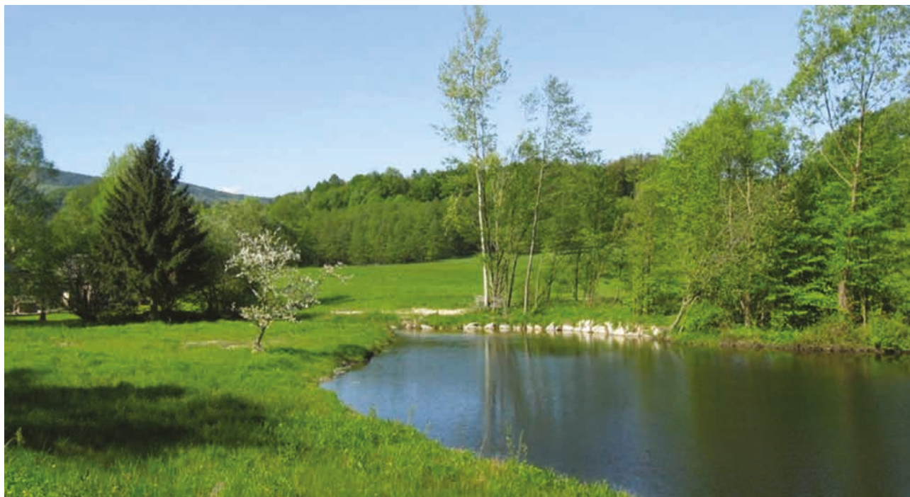
Červený potok, retenční objekt (zdroj: Lesy ČR, s. p.)
