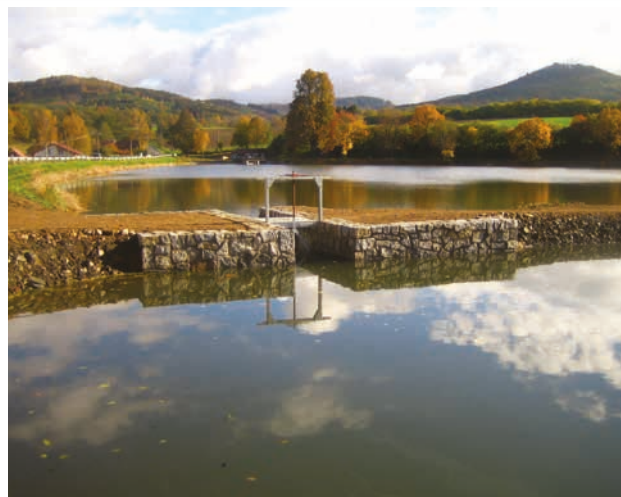
MVN Bílka, objekt po opravě (autor: Josef Vitek)
