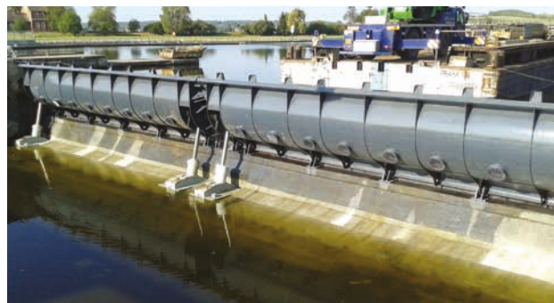
VD Vraňany, oprava technologie levého jezového pole (autor: Jan Polouček)
