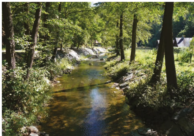
Kocába, Masečín, oprava opevnění koryta (autor: Šárka Hermanová)
