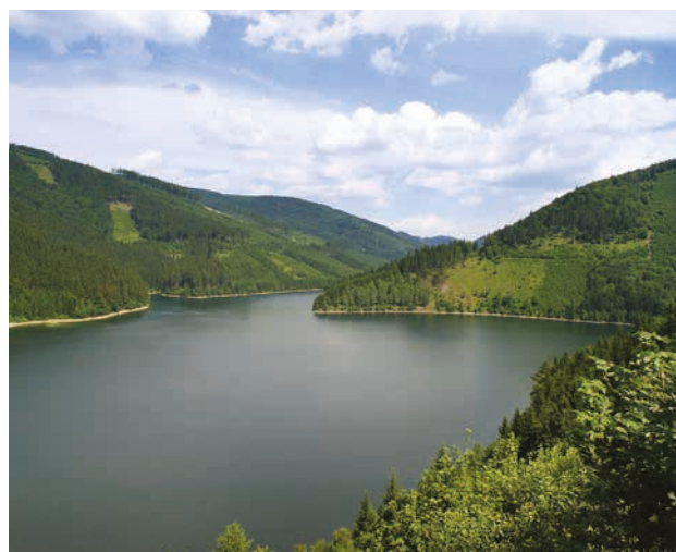
Vodní nádrž Šance (zdroj: Povodí Odry, s. p.)
