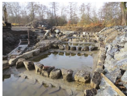
Úhlava, rekonstrukce jezu Poborovice 4 (autor: Miloslav Křen)
