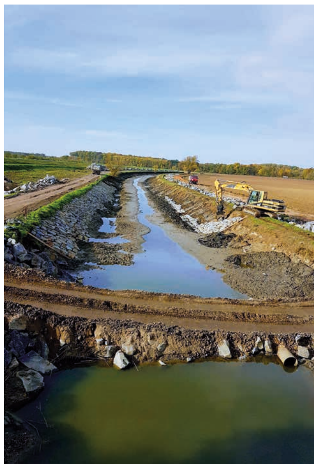
Oprava opevnění a břehů Baťova kanálu ve Vnorovech, říjen 2017 (zdroj: Povodí Moravy)
