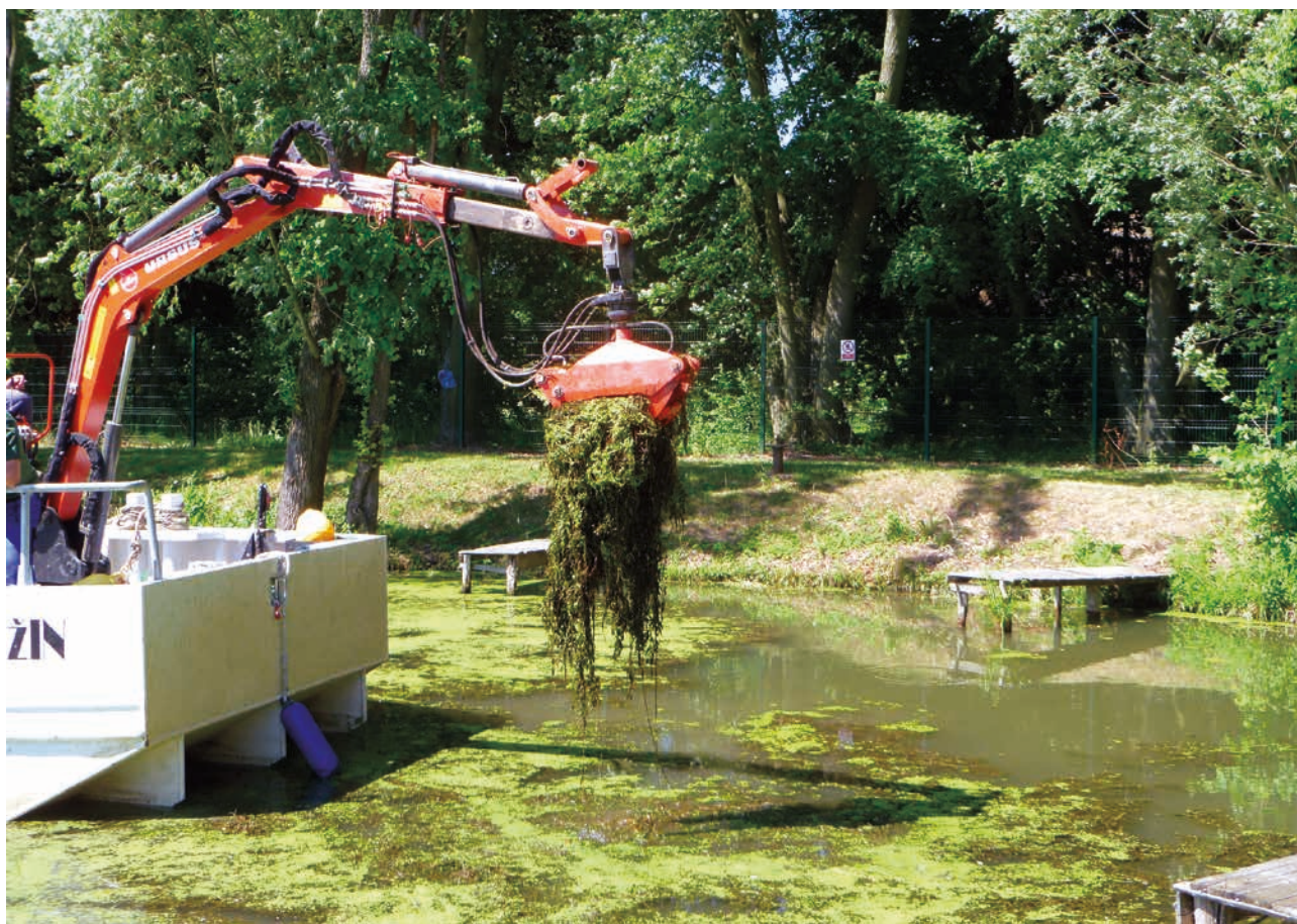
Čištění Bat'ova kanálu od biomasy pomocí pracovního plavidla Jožin (zdroj: Povodí Moravy)
