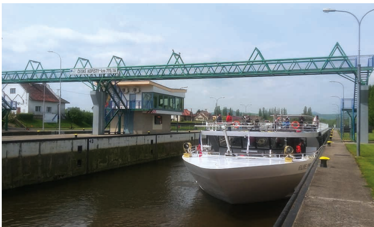
Velká plavební komora VD České Kopisty (zdroj: Povodí Labe)
