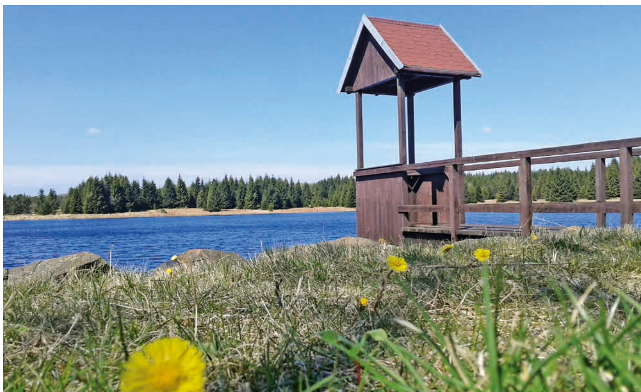
Novodomská zastávka (zdroj: Povodí Ohře)
