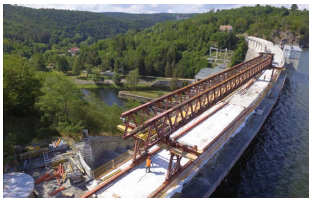
Průběh prací na VD Vranov, červen 2017 (zdroj: Povodí Moravy)
