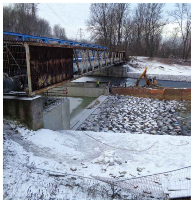
Ostravice – jez Vitkovice km 8,76 – opevnění podjezí, zazimování stavby, prosinec 2017 (zdroj: Povodí Odry)
