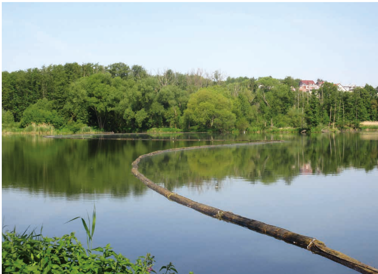
Podhradský rybník – nově instalovaná norná stěna, květen 2017 (zdroj: Povodí Moravy)
