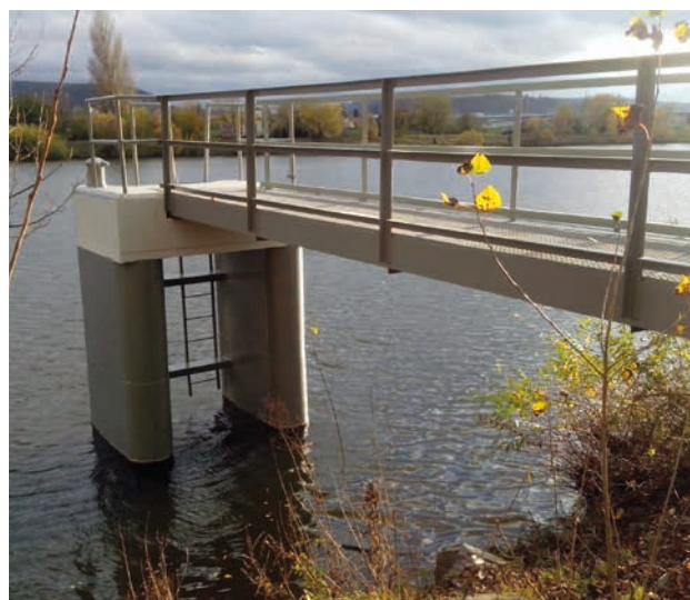
Berounka – oprava daleb (zdroj: Povodí Vltavy)
