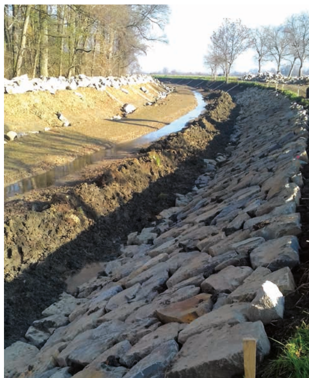
Batův kanál – Vnorovy, oprava opevnění, podzim 2017 (zdroj: Povodí Moravy)
