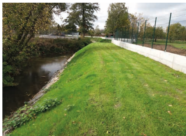
Levobřežní úprava toku Porubka – kamenné opevnění a protipovodňová zídka (zdroj: Povodí Odry)
