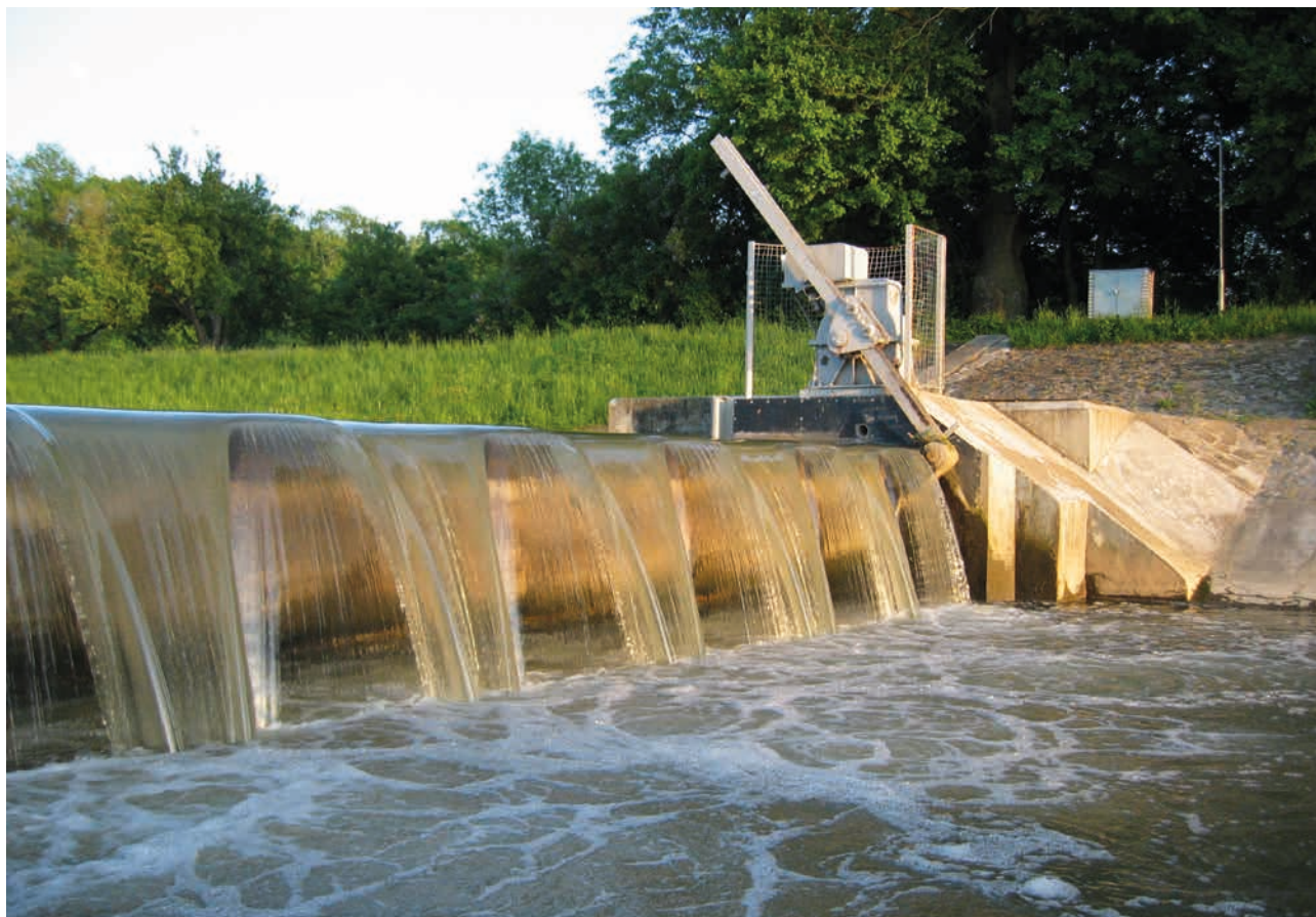
Batův kanál – jez na řece Veličce ve Strážnici (autor: Luboš Vřešťál)
