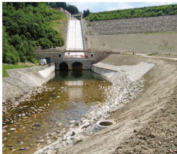
Provedené nové konstrukce skluzy a vývaru (zdroj: Povodí Odry)
