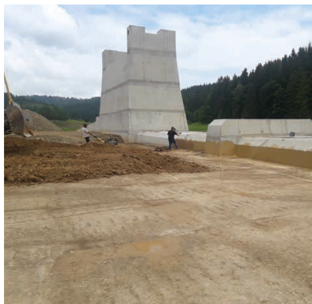
Suchá nádrž Jelení – sypání hráze okolo sdruženého objektu (zdroj: Povodí Odry)
