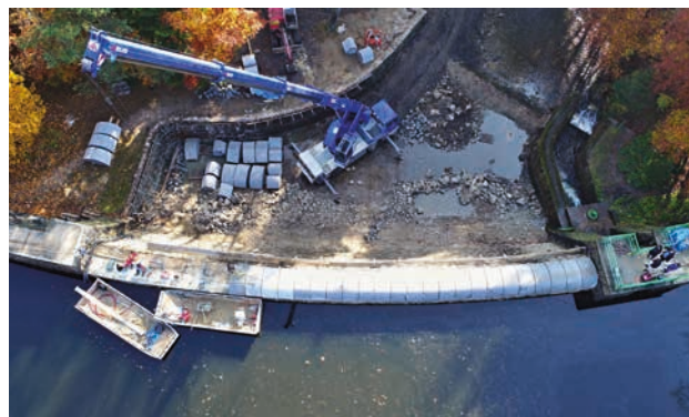
VD Naděje – oprava koruny bezpečnostního přelivu (zdroj: Povodí Ohře)
