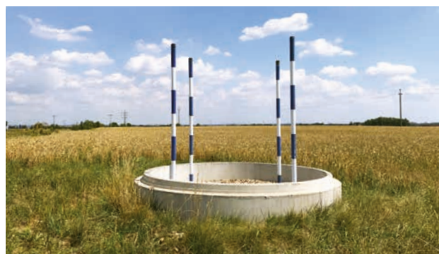
Orientační označení vodovodního potrubí v terénu mimo zastavěné území (autor: Radek Hospodka)
