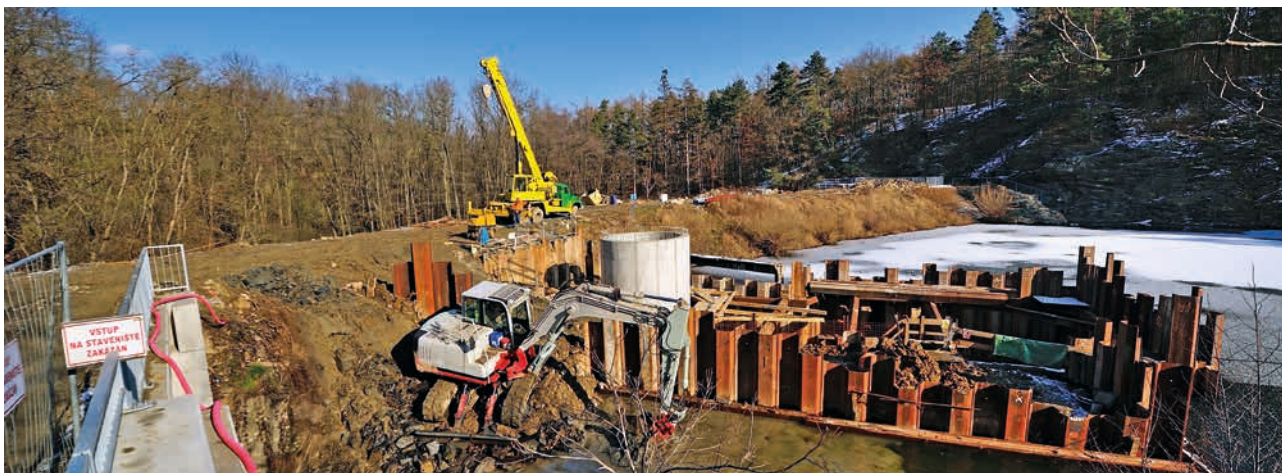
Velký rybník – obnova spodních výpustí (zdroj: Povodí Labe)
