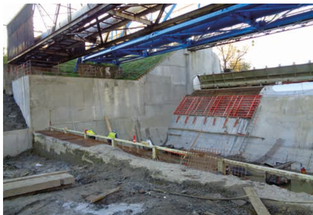
Ostravice – jez Vítkovice, km 8,76 – betonáž povrchů přelivu pravého jezového pole, říjen 2017 (zdroj: Povodí Odry)
