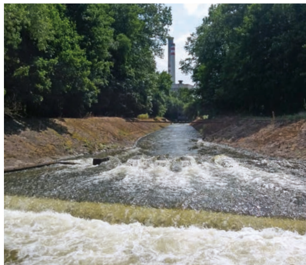
Tepelná elektrárna Mělník, Horní Počaply (autor: Petra Hubalová)
