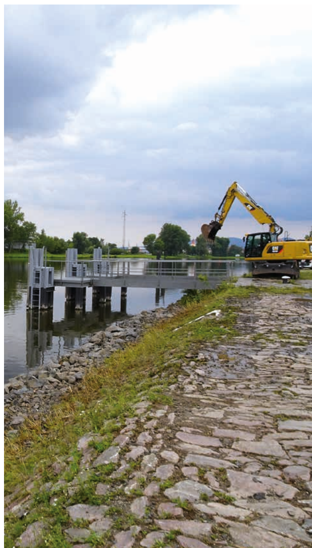
Úprava záhozu v Litoměřicích (zdroj: Povodí Labe)
