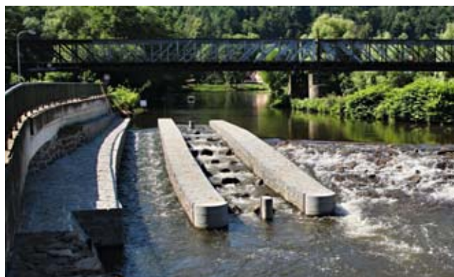
Rybí přechod Locket – po realizaci (zdroj: Povodí Ohře, s. p.)
