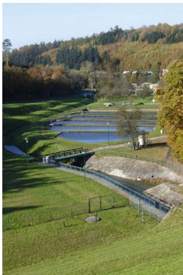
Vodní dílo Koryčany – rybářské sádky (zdroj: Povodí Morava, s. p.)
