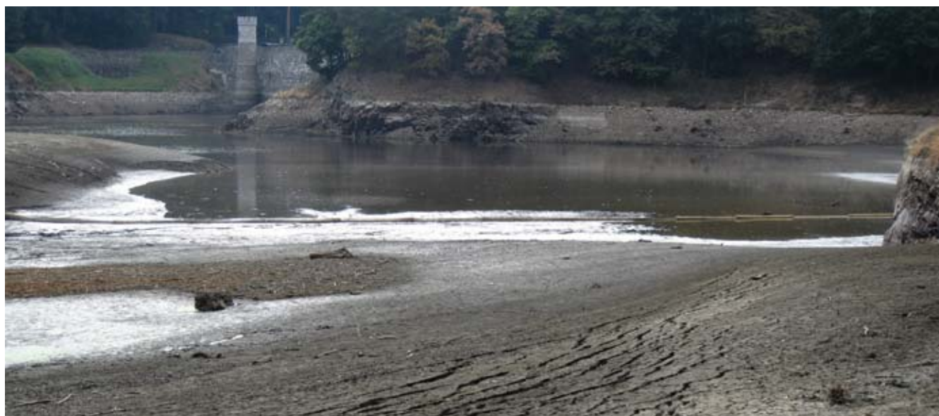
Vodní nádrž Pařížov, sucho (zdroj: Povodí Labe, s. p.)
