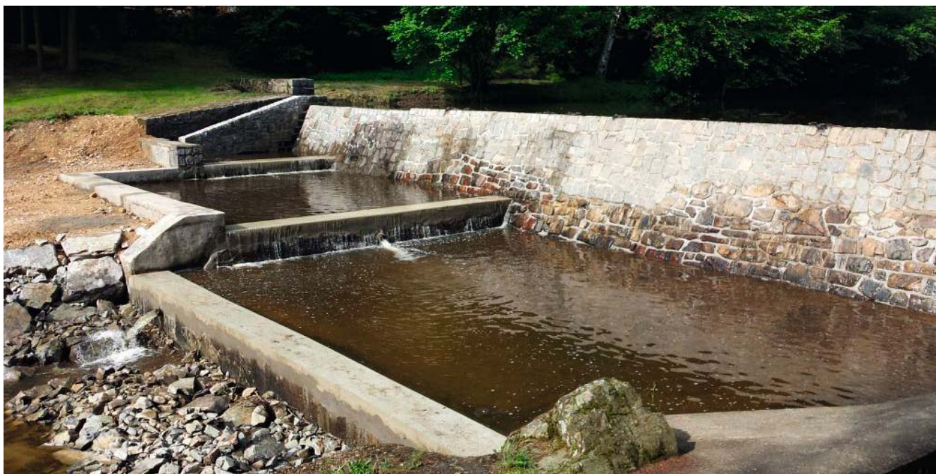
Jez Dívčí Kámen – odstranění povodňových škod (autor: Ing. Hana Žáčková)
