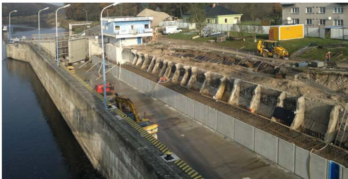
Oprava plavební komory Velký Osek (zdroj: Povodí Labe, s. p.)
