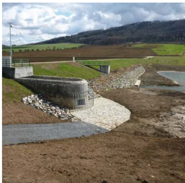
Vodní nádrž Starý Jičín (zdroj: Povodí Odry, s. p.)
