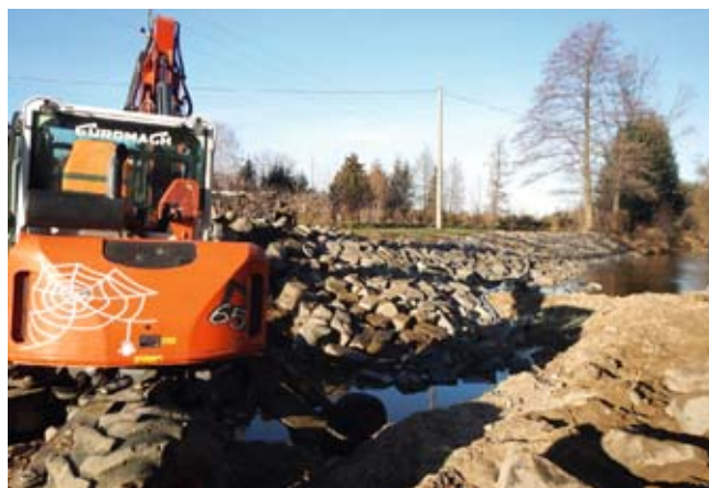
Oprava Smedé v Minkovicích (zdroj: Povodí Labe, s. p.)
