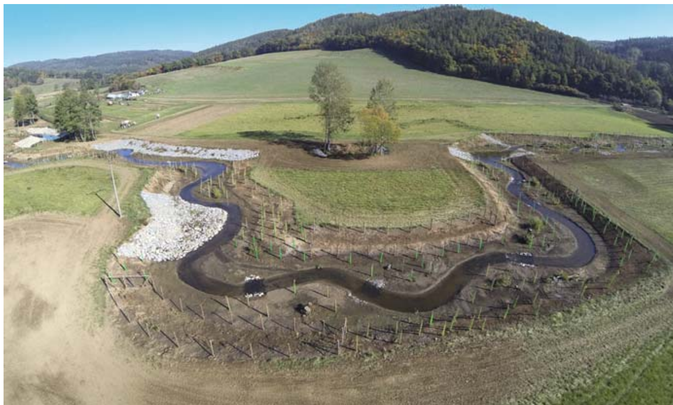
Revitalizace toku Loděnice, Nenačovice (autor: Aerodata, s.r.o.)
