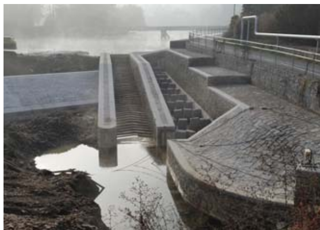
Rekonstrukce jezu Černošice, Berounka – část díla Rybí přechod (autor: Jan Šimůnek)
