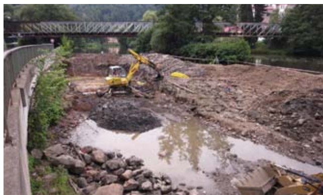
Rybí přechod Locket – stavba (zdroj: Povodí Ohře, s. p.)
