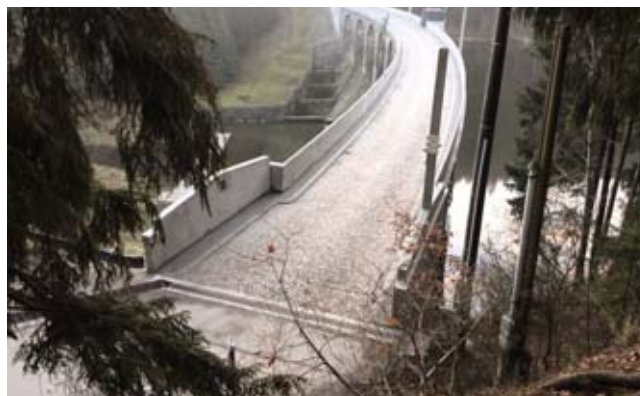
Vodní dílo Sedlice – rekonstrukce koruny a návodního lince hráze (autor: Jiří Kahánek)
