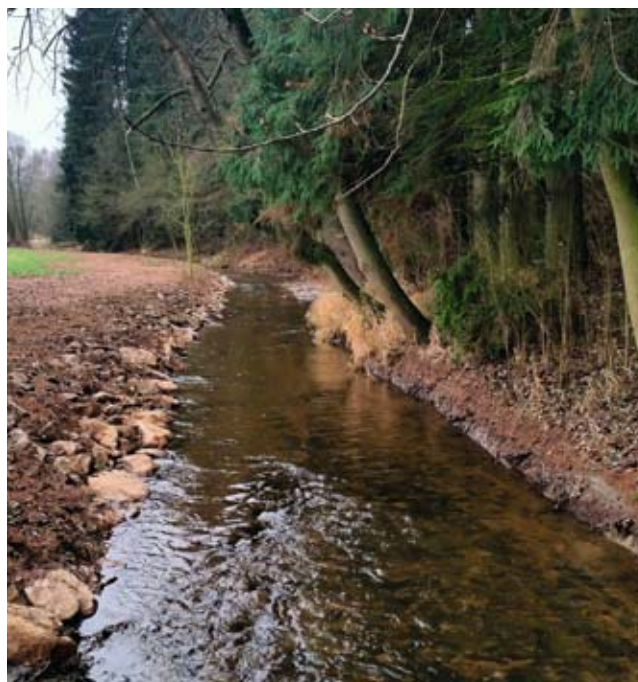
Úsobský potok – stabilizace břehu (autor: Ing. Hana Žáčková)
