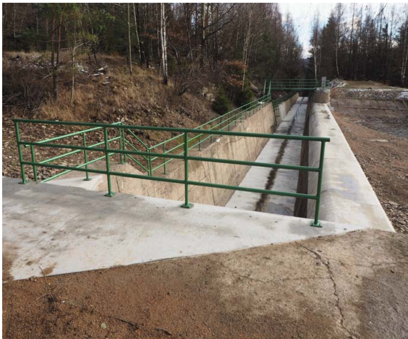
Vodní dílo Obecnice – oprava bezpečnostního přelivu a skluzu (autor: Ing. Hana Žáčková)
