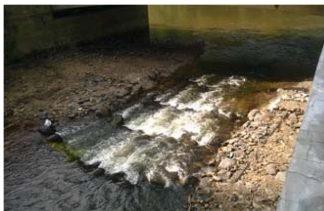
Rybí přechod Hřensko – po realizaci (zdroj: Povodí Ohře, s. p.)
