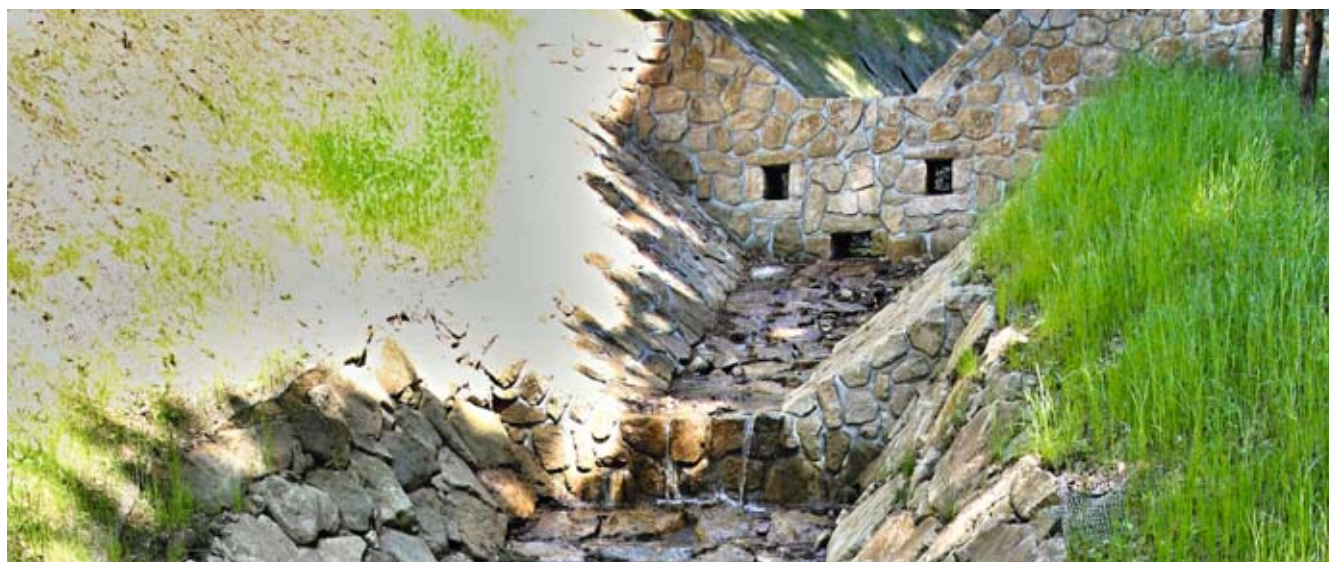
Bouřlivý potok, Mikulov – rekonstrukce koryta toku (zdroj: Povodí Ohře, s. p.)
