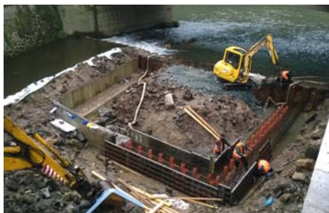
Rybí přechod Hřensko – stavba (zdroj: Povodí Ohře, s. p.)
