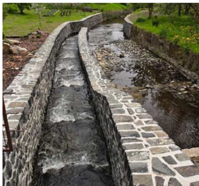
Rybní přechod Svitávka (zdroj: Povodí Ohře, s. p.)
