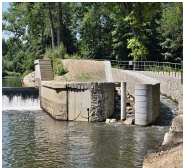
Rybí přechod Černý Mlýn (zdroj: Povodí Ohře, s. p.)
