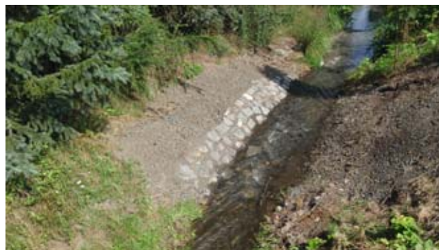
Srpina, Malé Březno – oprava koryta toku (zdroj: Povodí Ohře, s. p.)
