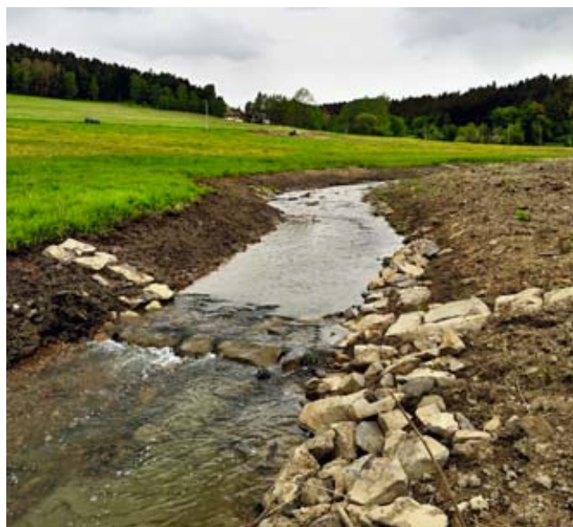
Revitalizace Ašského potoka (zdroj: Povodí Ohře, s. p.)
