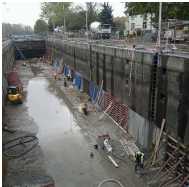
Oprava plavební komory Brandýs nad Labem (zdroj: Povodí Labe, s. p.)
