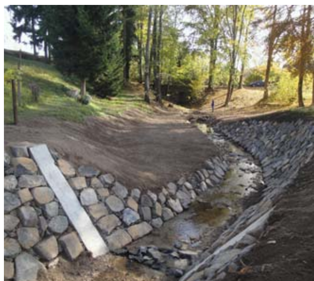
Protipovodňová opatření – Brusnický potok (zdroj: Povodí Labe, s. p.)
