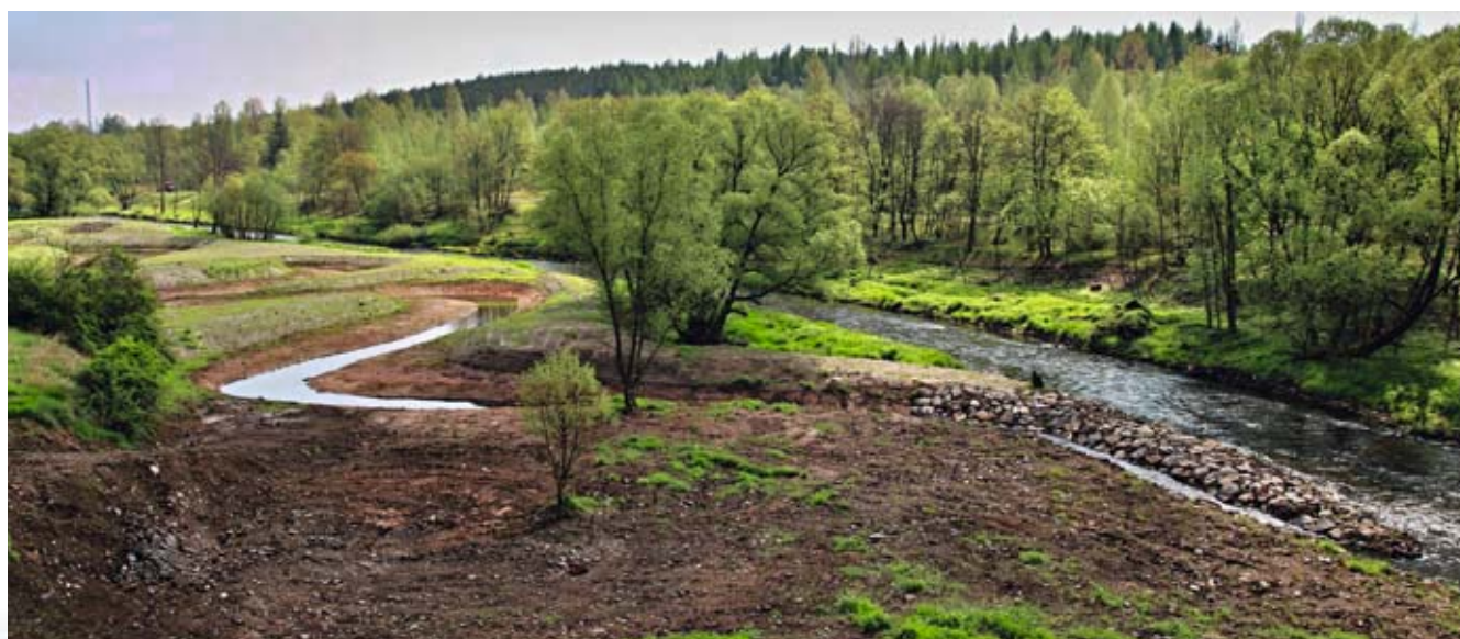
Revitalizace toku Ohře, Sokolov
