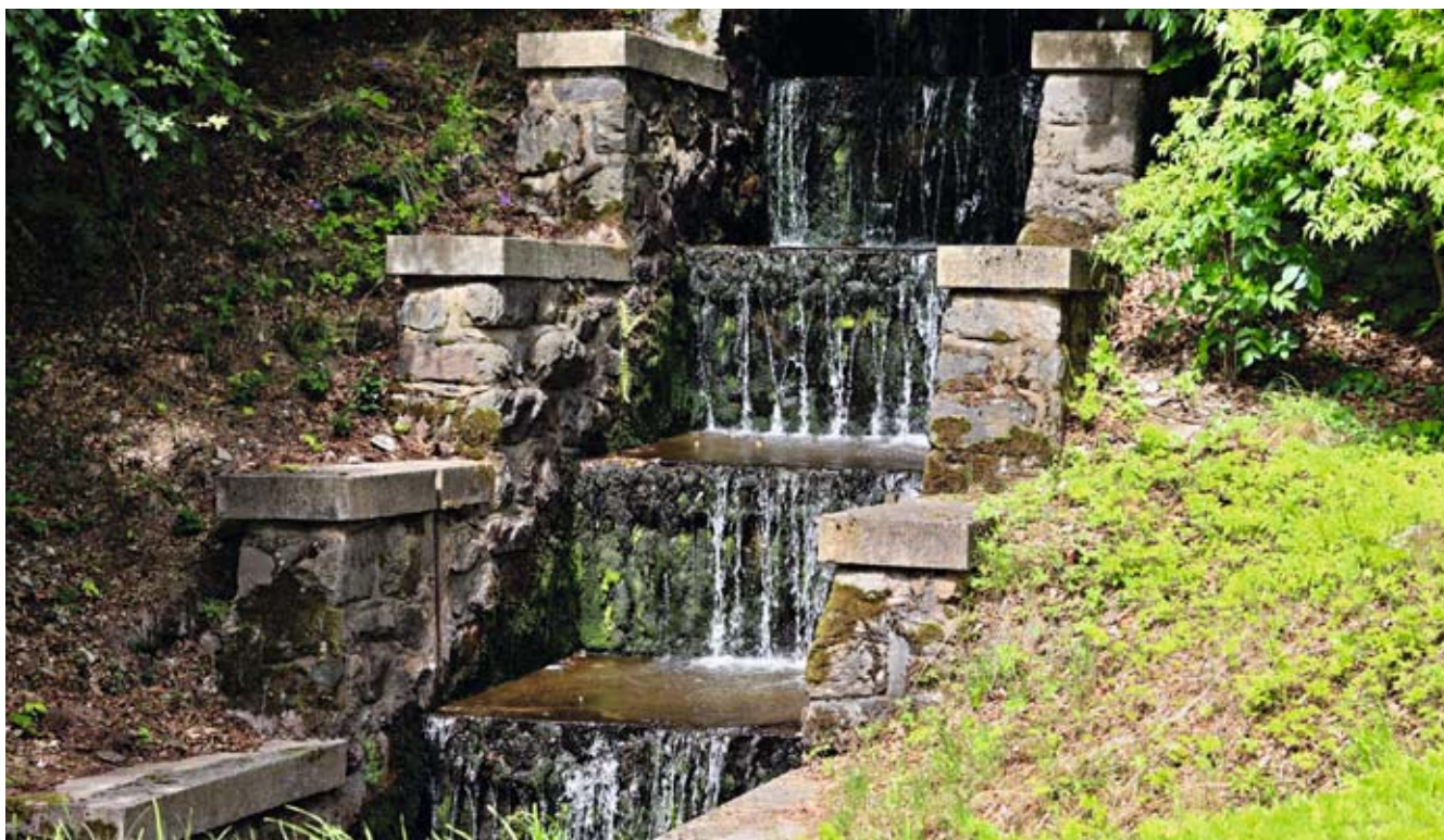
VD Jezeří – kaskáda na odtoku z nádrže
