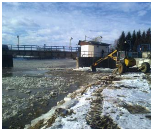
Jez Osek – odstraňování ledů u vtokového stavidla
