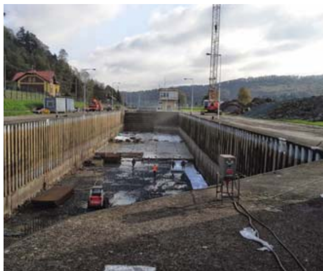
VD Dolánky, rekonstrukce plavební komory
