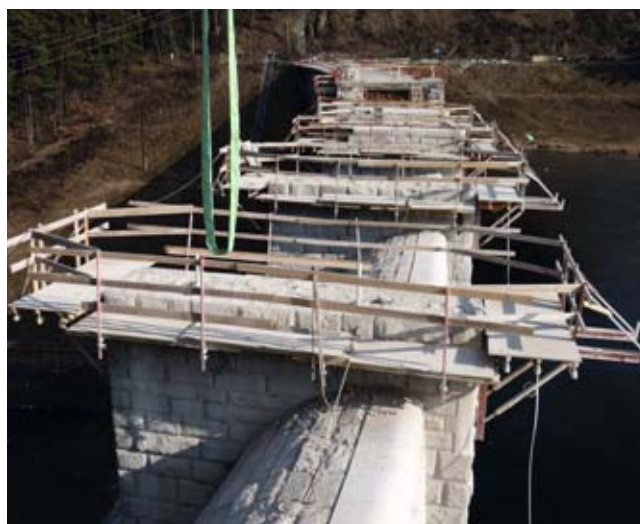
Přehrada Husinec – oprava hráze
