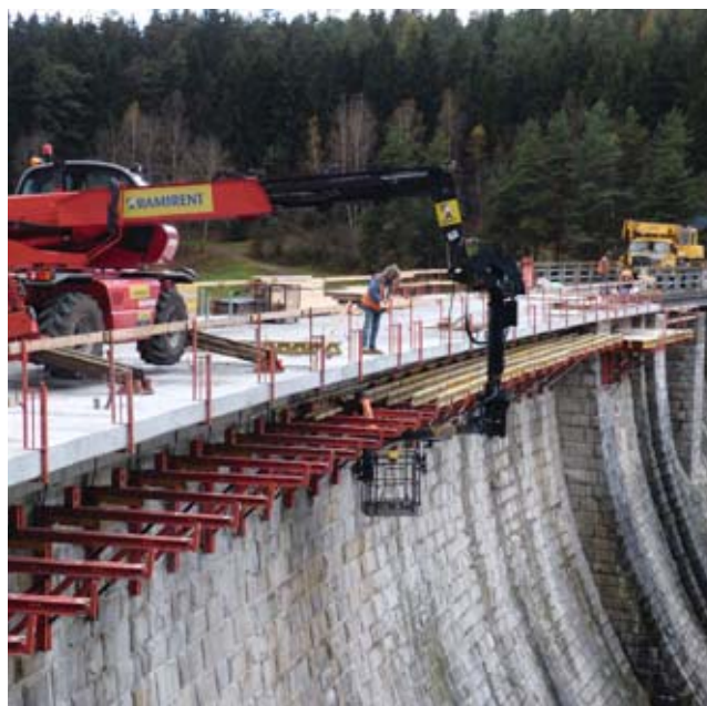
Přehrada Husinec – oprava hráze
