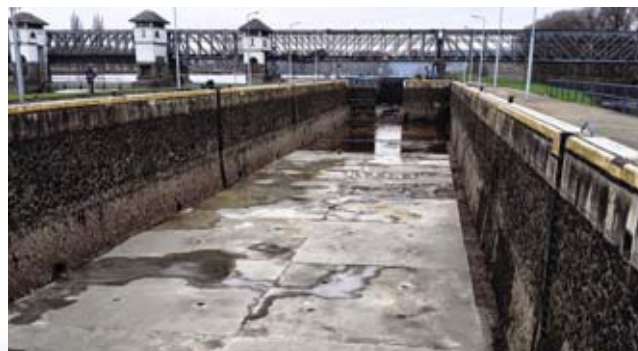
VD Mířevě, rekonstrukce dna vodní plavební komory
