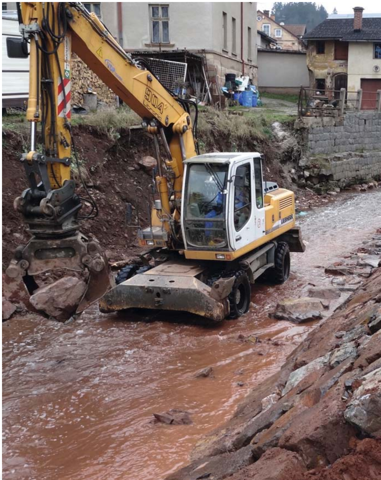
Čistá v Rudníku, odstranění následků povodní z roku 2013
