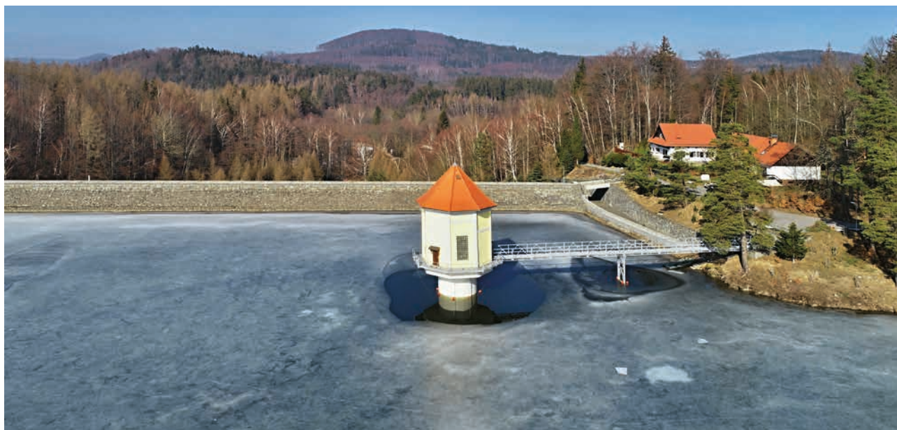
VD Chřibská, únor 2020 (zdroj: Povodí Ohře)
