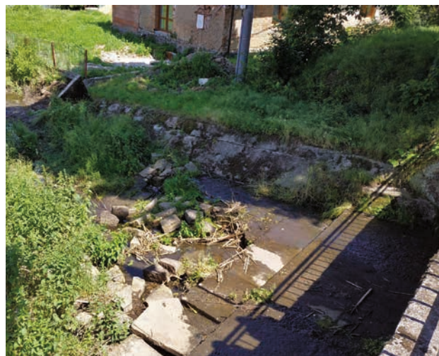
Příchovický potok, Horšice, oprava opevnění – PŘED (zdroj: Povodí Vltavy)
