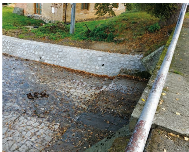
Příchovický potok, Horšice, oprava opevnění – PO (zdroj: Povodí Vltavy)
