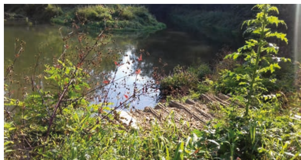
Podpora samovolné renaturace řeky Moravy u Štěpánova – srubové opevnění pravobřežního meandru (zdroj: Povodí Moravy)
