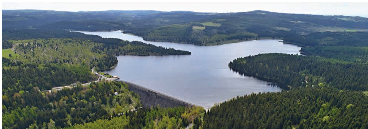
Vodní dílo Fláje (zdroj: Povodí Ohře)
