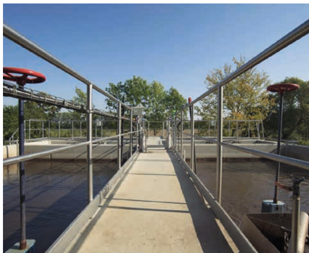
Rekonstrukce a intenzifikace ČOV Prosiměřice (zdroj: MŽP)
