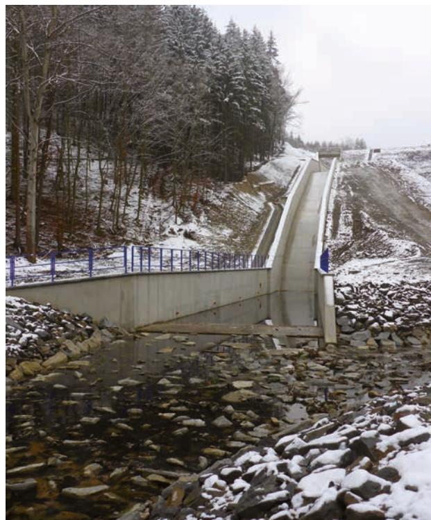
Vodní dílo Opatovice – dokončený skluz (zdroj: Povodí Moravy)
