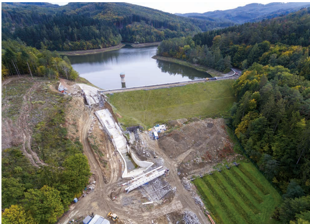
Rekonstrukce vodního díla Koryčany (zdroj: Povodí Moravy)
