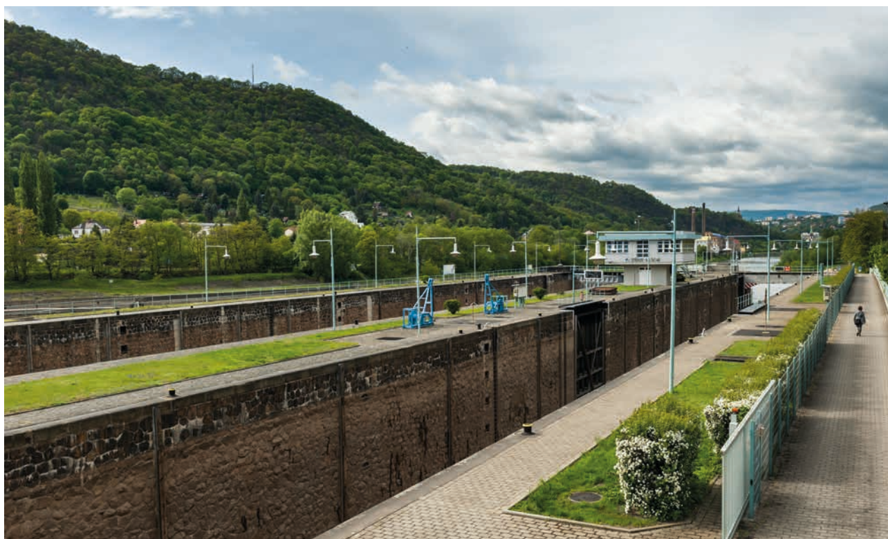
Plavební komory Střekov (zdroj: Povodí Labe)
