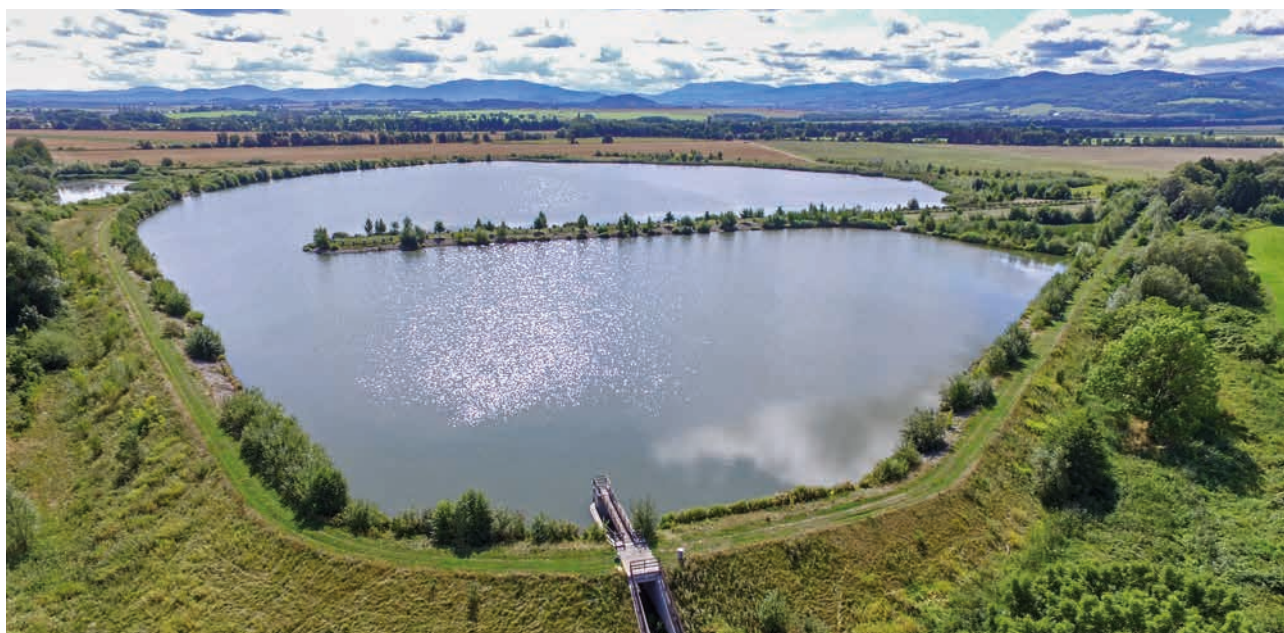
Jeseník, Komplexní pozemková úprava Javorník-ves, Multifunkční nádrž biocentra Střední díly (zdroj: SPÚ)
