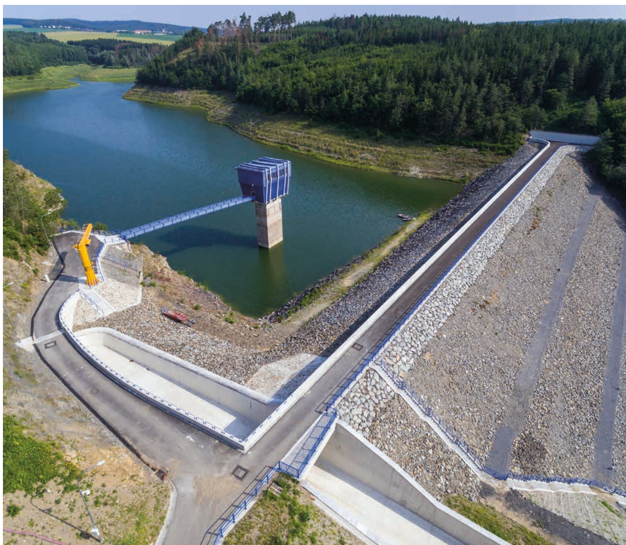
Vodní dílo Opatovice po rekonstrukci (zdroj: Povodí Moravy)
