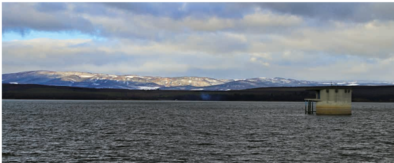
Nechranice (zdroj: Povodí Ohře)
