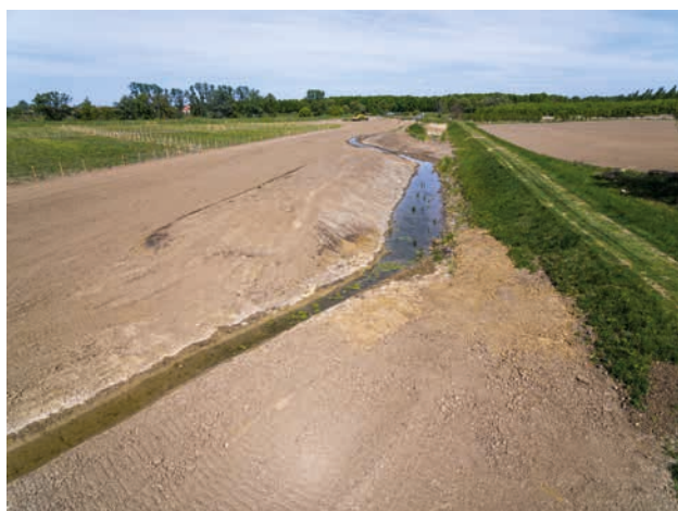
Revitalizace Baštyňského potoka u Novosedel s novým lužním lesem, průběh prací – květen 2020 (zdroj: Povodí Moravy)
