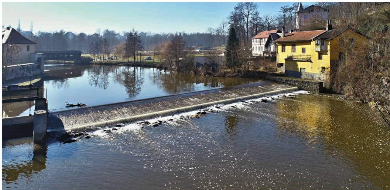
Jez Mlýnská (zdroj: Povodí Ohře)
