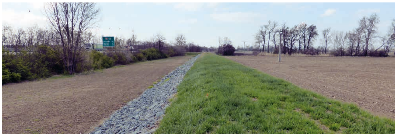
Protipovodňová ochrana města Pohořelice, vybudováno 6 450 m ochranných hrází a zídek (zdroj: Povodí Moravy)
