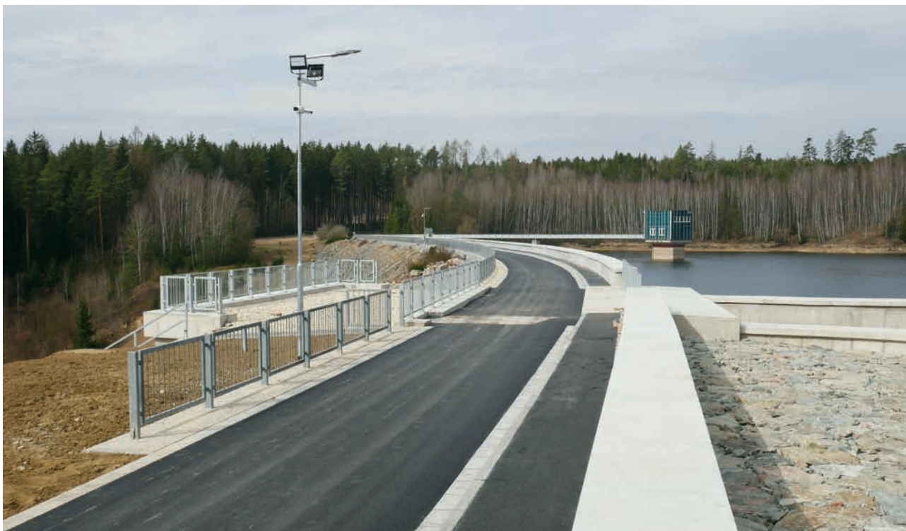
Vodní dílo Boskovice – koruna hráze po rekonstrukci (zdroj: Povodí Moravy)
