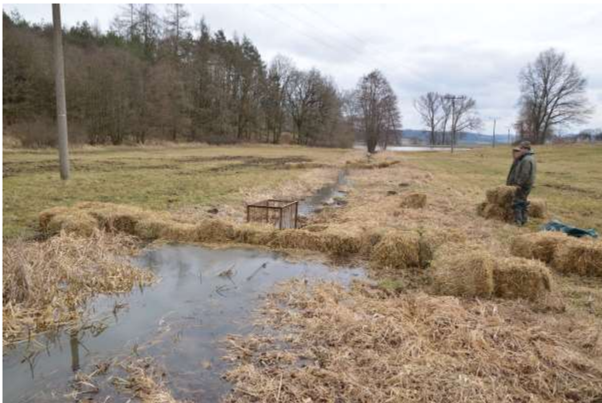
Obrázek 4. Instalace bariér pod rybníkem Brdský
