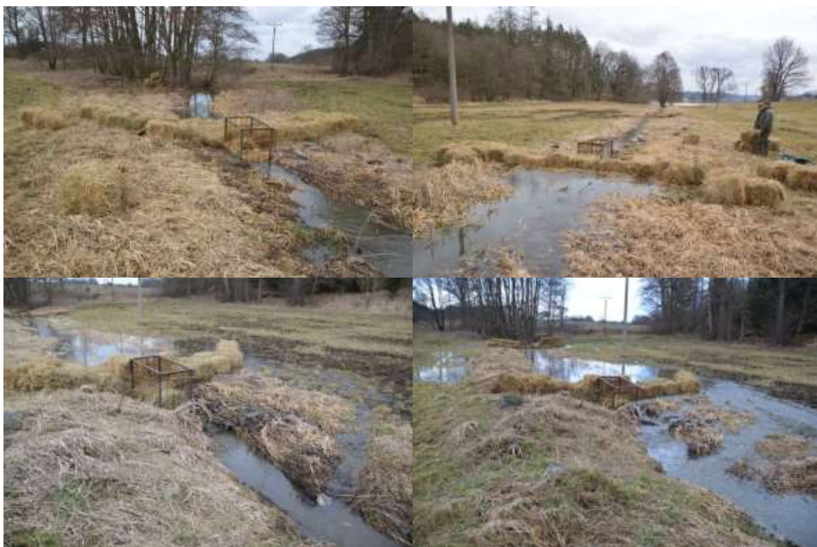
A – celkový pohled na rybník, B – stoka pod rybníkem, C – louka pod rybníkem, D – první bariera pohled shora, E – první bariera pohled zdola, F – první bariera pohled shora, G – druhá bariera při malém průtoku vody, H – druhá bariera při velkém průtoku vody,
