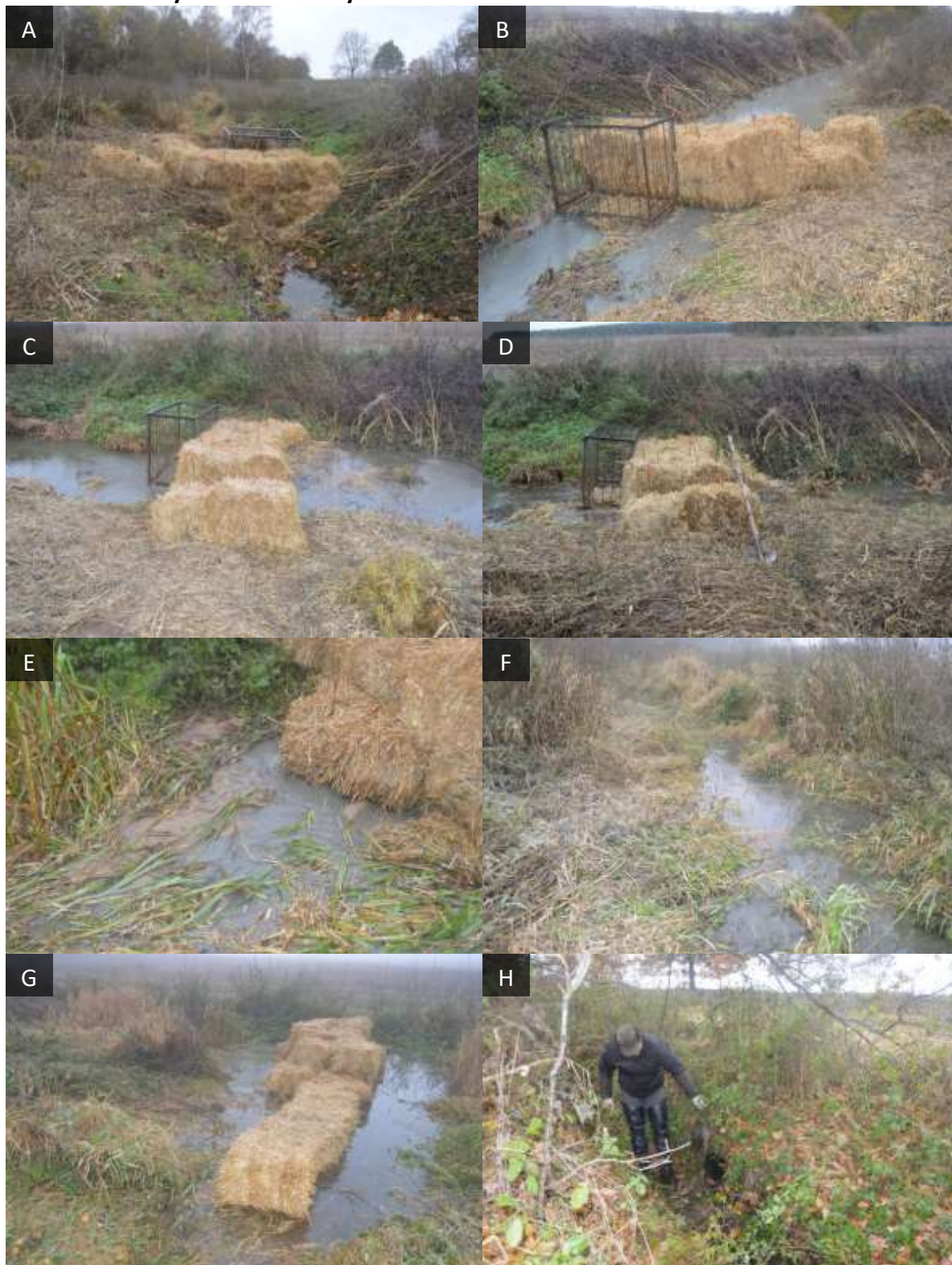
A – první bariera pohled shora, B – první bariera pohled ze spodu, C – první bariera větší průtok, D – první bariera menší průtok, E – podtékání bariery, F – hustá vegetace výtoky nad druhou barierou, G – druhá bariera celkový pohled, H – výtok zatrubněné části odpadní stoky z rybníka,
