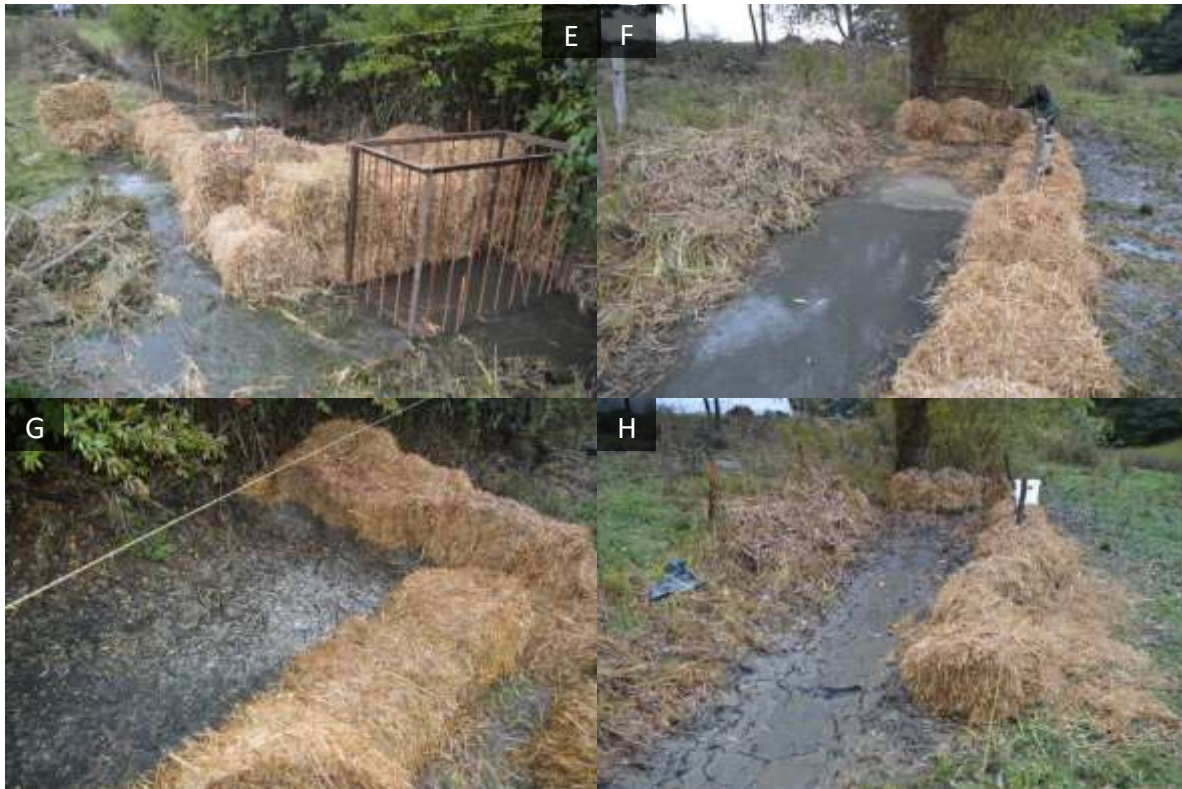
A – celkový pohled na rybník, B – stoka pod rybníkem, C – prostor pro vybudování první bariery, D – prostor pro vybudování druhé bariery, E – první bariera pohled zdola, F – druhá bariera pohled shora, G – zachycené plevelní ryby nad první barierou, H – sediment ve druhé barieře po výlovu,
