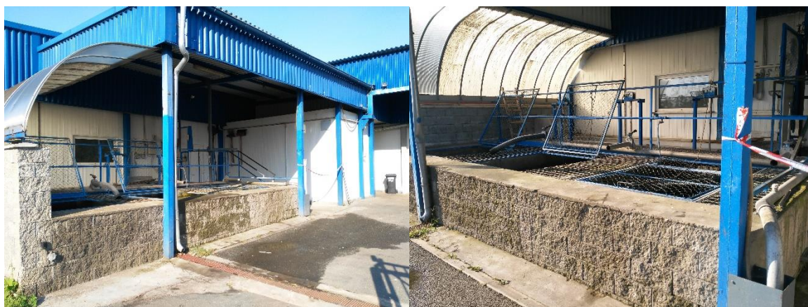
Obr. 2. Celkový pohled na manipulační nádrže pro krátkodobé uchování ryb před jejich zpracováním.
