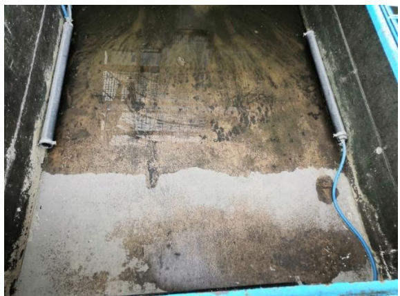
Obr. 4. Pohled na vypoštěnou manipulační nádrž a aerační trubice nového systému.
