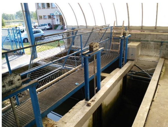
Obr. 3. Vlevo: pohled na výpustní zařízení manipulačních nádrží a slovovací kanál. Vpravo: pohled na vypoštěnou manipulační nádrž a aerační trubici starého systému.
