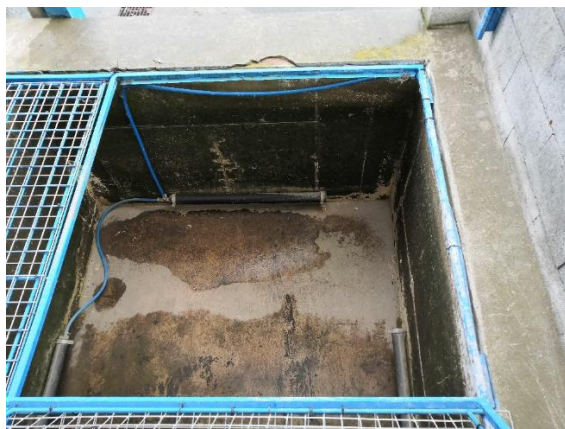
Obr. 4. Pohled na vypoštěnou manipulační nádrž a aerační trubice nového systému.
