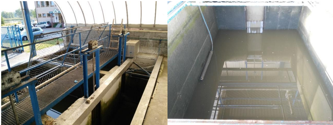
Obr. 5. Vlevo: pohled na výpustní zařízení manipulačních nádrží a slovovací kanál. Vpravo: pohled na vypuštěnou manipulační nádrž a aerační trubici starého systému.
