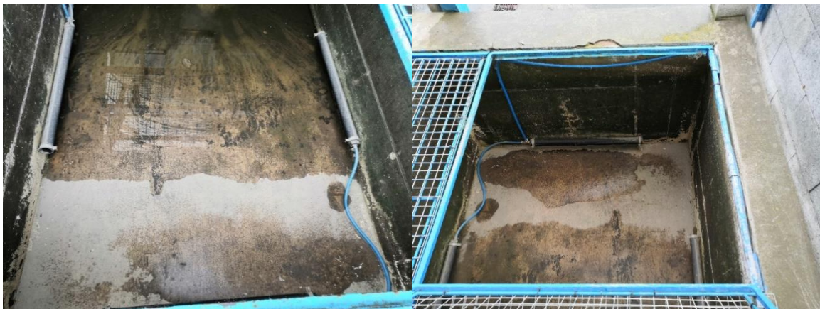
Obr. 6. Pohled na vypuštěnou manipulační nádrž a aerační trubice nového systému.
