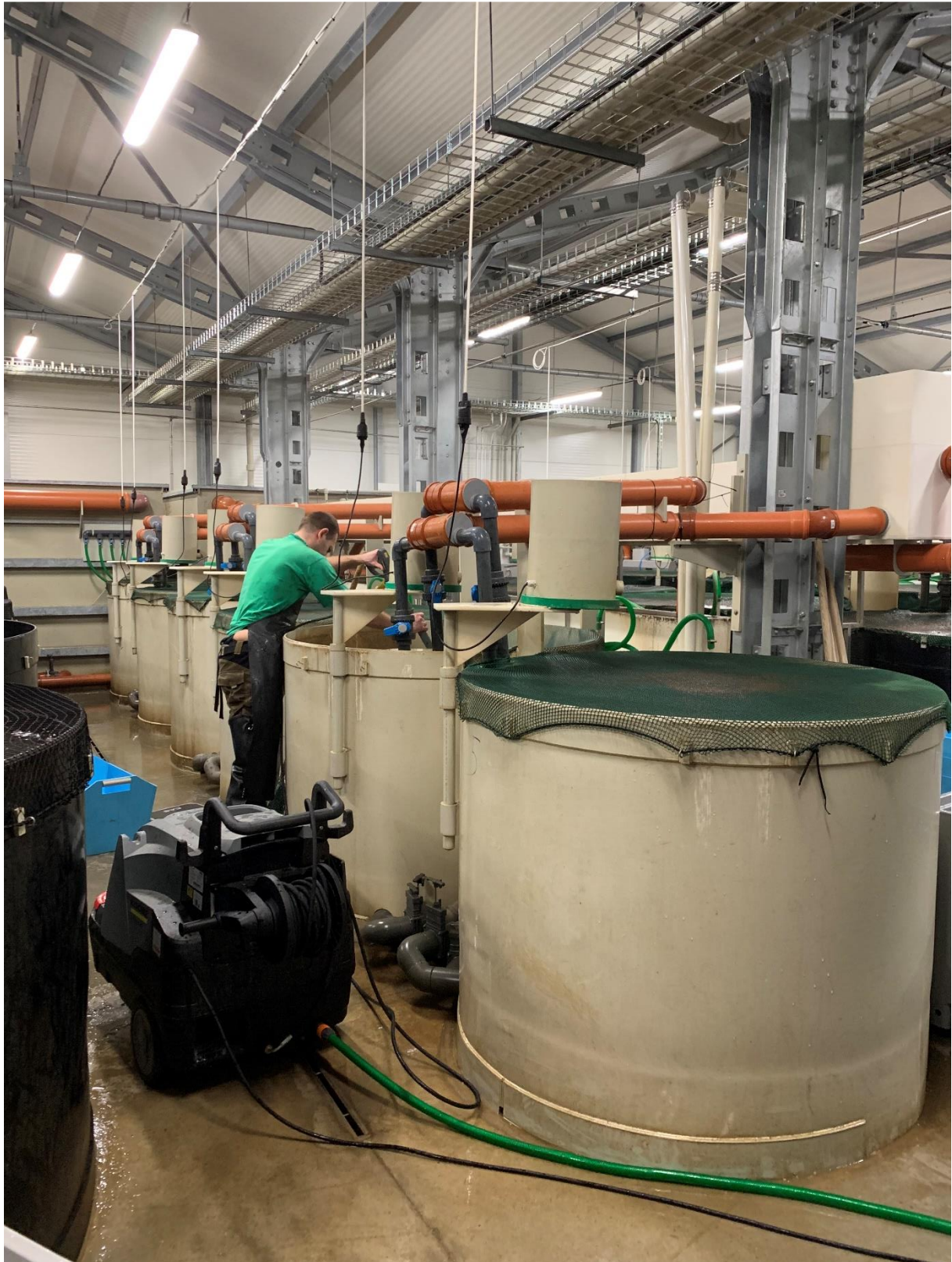
Obr. 2: Čištění a příprava nádrží na intenzivní chov sumečka afrického.
