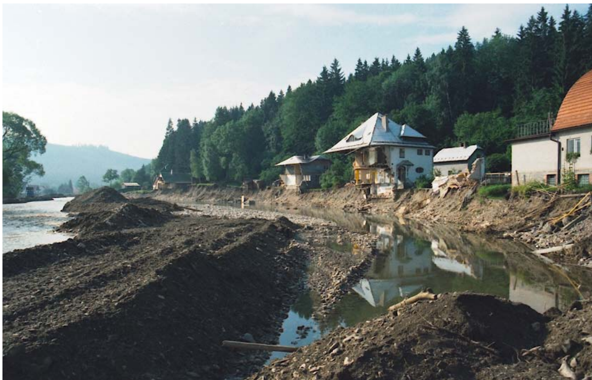
Foto 14: Centrum obce Karlovice po povodni 1997 Ničivý průběh povodni v podhorské údolní nivě vede k destrukci obytných budov.
