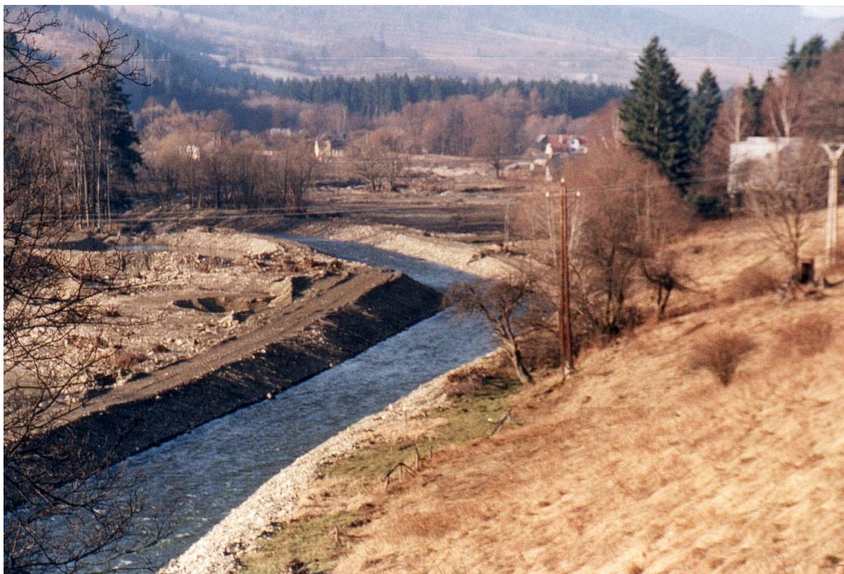
Foto 13: Situace po povodni 1997 – operativní opatření Obnovení průtočnosti koryta po povodni.
