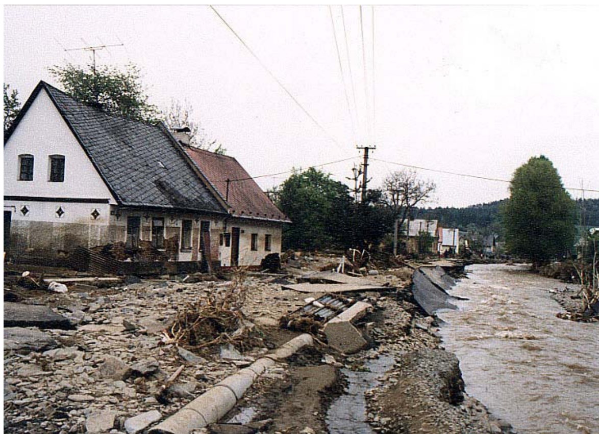
Foto 16: Čížina, obec Lichnov po povodni v květnu 1996 V úzkých údolích bývá povodněmi rozvrácena celá struktura osídlení – zástavba, souběžné komunikace, inženýrské sítě.
