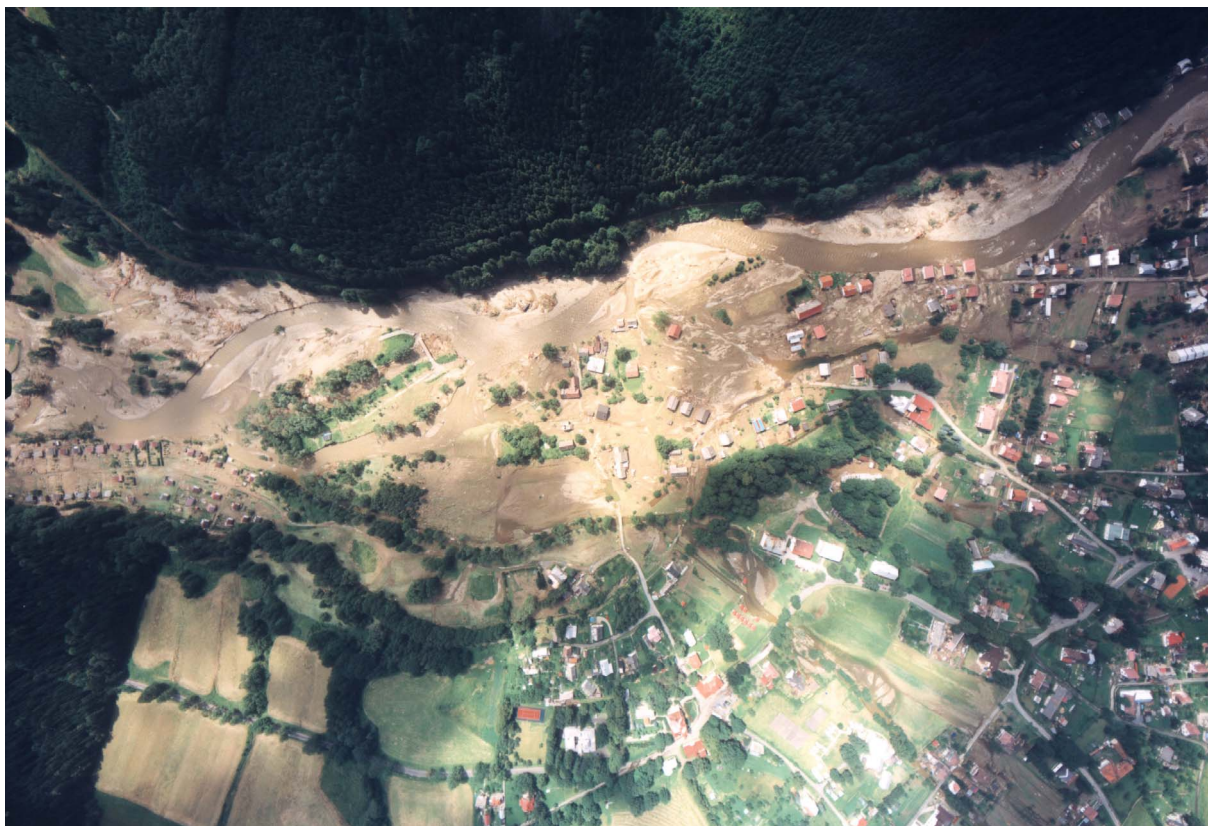
Foto 7: Řeka Opava – Karlovice, následky povodně 1997 (snímek ze srpna 1997) Charakter nivy řeky Opavy ohrožované povodněmi - poměrně úzké a civilizačně exponované podhorské údolí.
