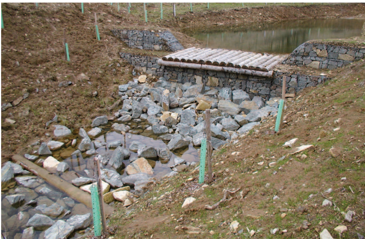
Obrázek 4-33: Pohled proti vodě na konstrukci přehrážky z gabionových košů, kde přelivná hrana přepadové sekce je chráněna dřevěnou konstrukcí z půlené kulatiny. Zároveň je dřevěná konstrukce přetažena přes celou gabionovou přelivnou část. V porovnání s dřevěnou konstrukcí z prken (obr. 4-31) je použití kulatiny vhodnější. Zároveň díky této konstrukci, kdy je chráněná „pouze“ přelivná hrana, je možné snadno dřevěný ochranný prvek vyměnit za nový. Spadiště je zpevněno ve dně těžkým kamenným záhozem, který je na spodní části po vodě ukončen a stabilizován dřevěným stabilizačním prahem z kulatiny. Břehy jsou zcela nezpevněné, ponechané pouze sukcesi. Takovou úpravu spadiště umožňuje profil terénu pod objektem. Z důvodu velkého namáhání paty břehu se v místě přechodu břehu do dna doporučuje minimálně zpevnění paty břehu kamennou rovnatinou, popř. kamenným záhozem.
