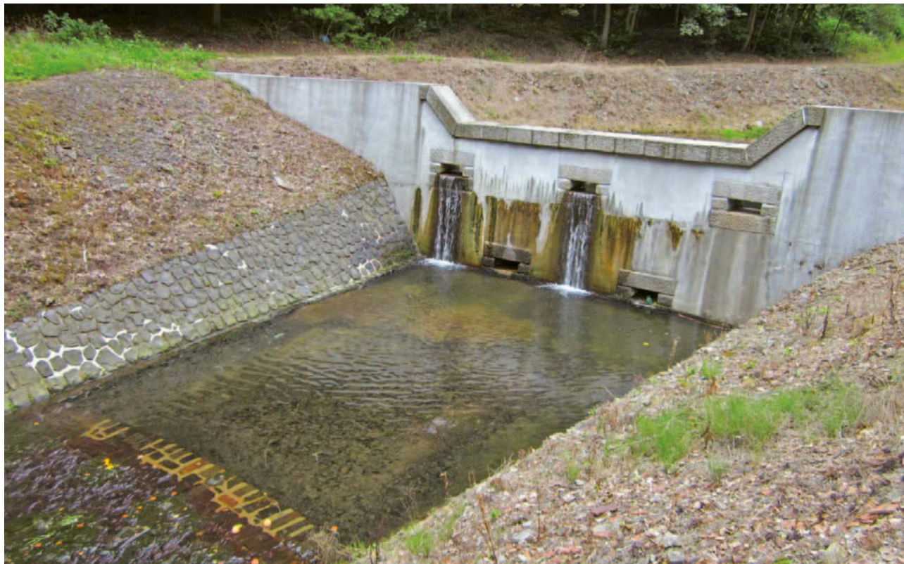
Obrázek 4-23: Pohled proti vodě na betonovou retenční přehrážku vybudovanou do systémového bednění s tím, že v tělese přehrážky jsou průřezné otvory ve dvou úrovních tvořené pískovcovými bloky. Přelivná sekce je na přelivu zpevněna pískovcovými bloky, které jsou mírně přesazeny před přeliv. Spadiště se nijak zásadně nerozšiřuje, z toho důvodu je opevnění v březích provedeno kamennou dlažbou ze sloupkového čediče na cementové lože s vyspárování do výškové úrovně druhých oken tak, aby voda přepadající přes přelivnou sekci dopadala již na zpevněný břeh. Objekt je na spodní části po vodě ukončen stabilizačním pasem. Na konstrukci je patrný průsak špatně ošetřenou pracovní spárou vzniklou při postupném betonování tělesa přehrážky.
