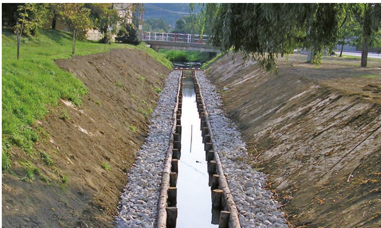
Obrázek 4-41: Ukázka provedeného opevnění pty pomocí plůtku z tyčoviny, nad stabilním průtokem nejčastěji na úrovni Q_{90d} je patrný přechod do opevnění provedeného pomocí zatravnění. Za plůtkem provedeno šterkové lože jako nutná filtrační vrstva.
