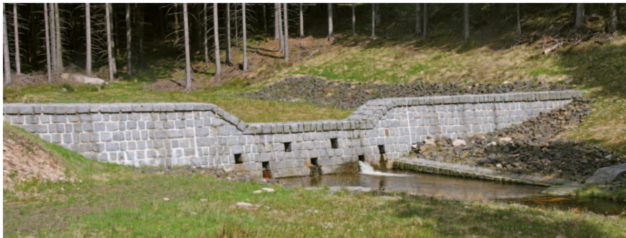
Obrázek 4-24: Pohled proti vodě na těleso retenční betonové přehrážky s obkladem z hrubého řádkového zdiva. Na fotografii je patrné postupné zdivění objektu přehrážky ve třech sekcích s dilatační spárou (samostatně budovaná zavazovací křídla a následně vylévání přelivné sekce s průřeznými otvory). Líc a přelivná hrana včetně koruny je obložena kamenným zdivem z žulových hranolů. V místě navázání kamene jsou velmi často patrné poruchy a porušení dilatačních spár (viz pohled na rub přehrážky – následující stránka).
