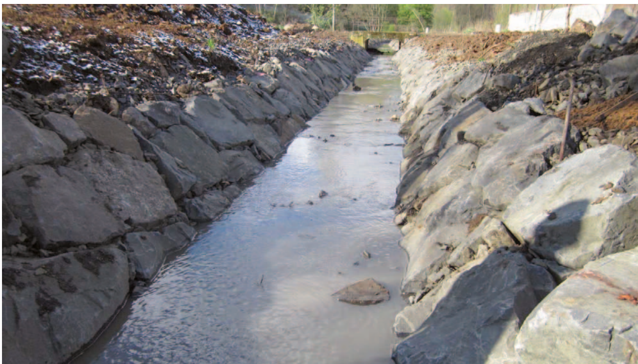
Obrázek 4-52: Pohled na kamennou rovnatinu, resp. na kamenný obklad prováděný v pravidelném lichoběžníkovém korytě. Konstrukci je nutné prosypávat kamenem, aby mezi rubem kamene a výkopem vznikla filtrační zóna a vrstva, která zaručí nevymývání půdních částic.
