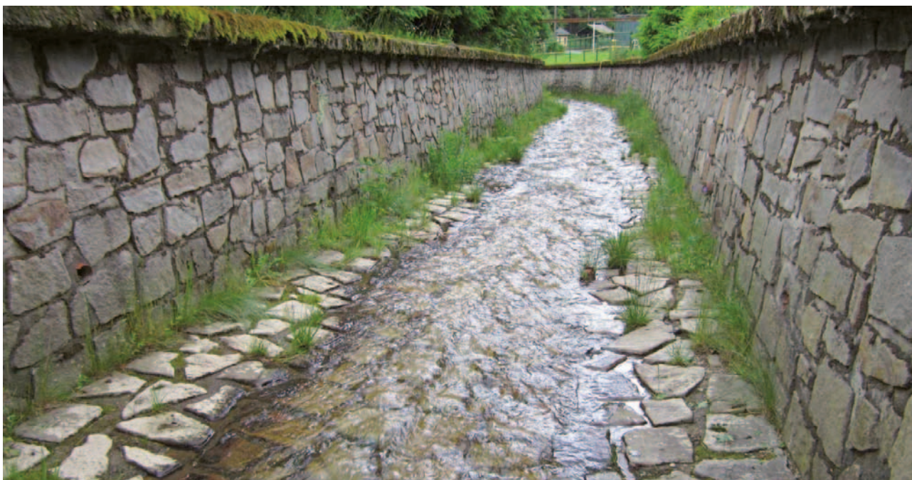
Obrázek 4-53: Úprava profilu koryta typická pro bystřinu vedenou intravilánem. Obdélníkový profil je v březích zpevněn opěrnými zdmi z režného kamenného zdiva, koruna je pak uzavřena betonovou římsou. Ve dně je koryto zpevněné kamennou dlažbou na cementovou maltu s vyspárováním. Z důvodu zachování hloubky při minimálních průtocích je koryto provedeno do středové střelky. Tato směrová a profilová úprava je doporučována většinou v intravilánu v místě, kde je nutné bezpečně provést korytem vysoké povodňové průtoky. Detailně je patrné provedení spárování dlažby ve dně i u opěrných zdí, betonová římsa je o 10 cm přesazena před líc konstrukce zdi (z důvodu ochrany zdi před stékající dešťovou vodou). Spárování kamenné dlažby i zdiva se doporučuje provádět na plocho, spáru zhruba o 1 cm zatlačit pomocí spárovaček pod líc kamenného zdiva.
