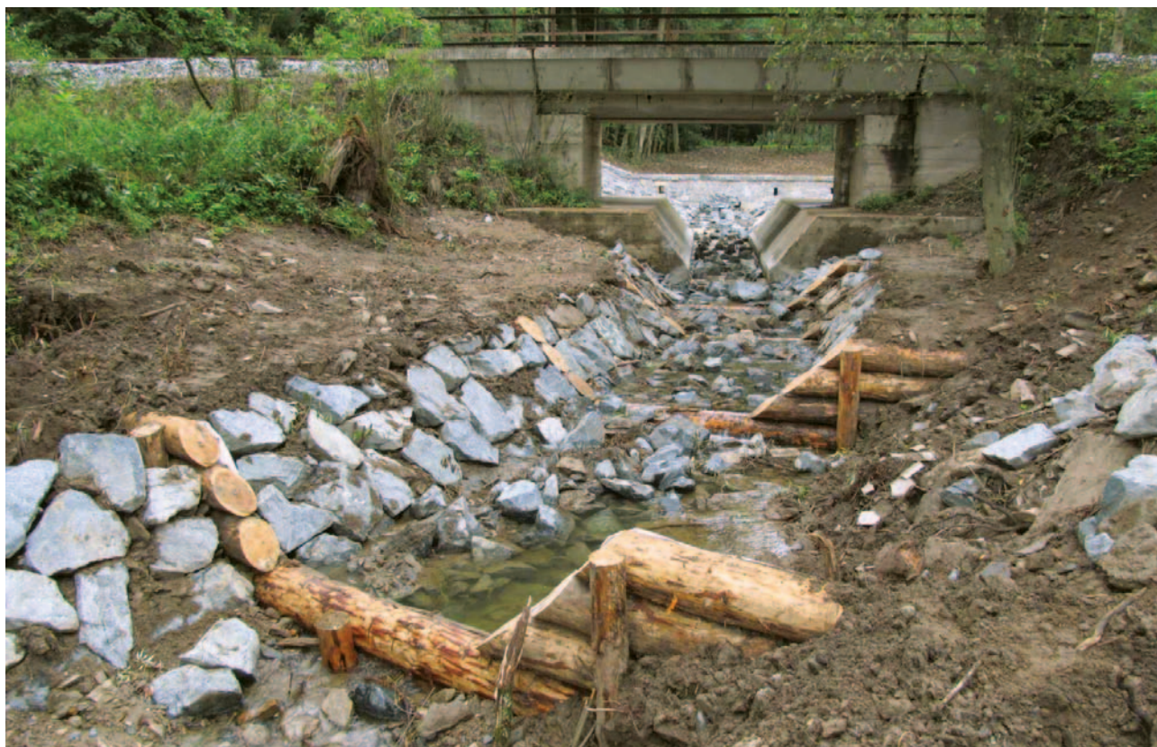
Obrázek 4-5: Pohled proti vodě na soustavu dřevěných stabilizačních pasů, které stabilizují lichoběžníkové koryto zpevněné kamennou rovnatinou. Rovnanina je provedena i ve dně z důvodu tlumení energie vody a ochrany železničního propustku proti zpětné erozi. Dřevěný stabilizační pas je konstrukčně proveden jako jednoduchá srubová stěna. Úseky mezi jednotlivými srubovými objekty jsou vyplněny kamennou rovnatinou v březích i ve dně. Podobná opevnění se doporučují v místech velkého podélného sklonu, kde je zároveň nutné stabilizovat koryto např. z důvodu kontaktu s dopravní infrastrukturou.
