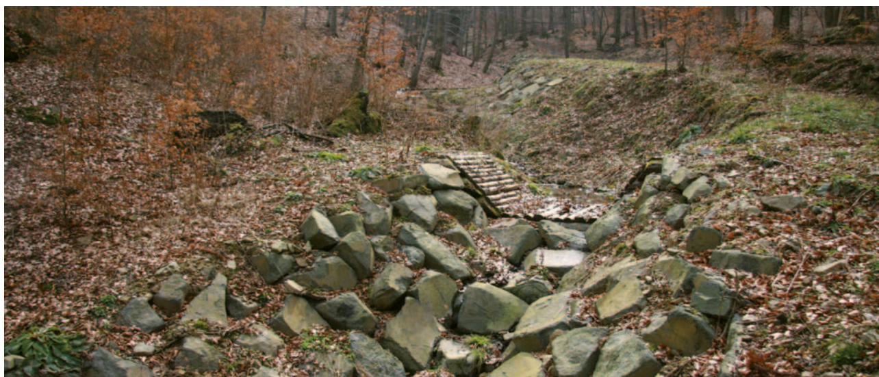
Obrázek 4-16: Pohled proti vodě na stabilizaci dna a břehu v nátrži vzniklé ve velmi výrazné údolnici. Na srubový pas navazuje skluz zesponu opřený o kamenný rovnaný pas. V horní části je stráž stabilizovaná pomocí srubové konstrukce z kulatiny vyplněné uvnitř kamennou výplní, přelivná sekce je zpevněna pomocí konstrukce z tyčoviny. Dřevěná konstrukce z tyčoviny má zabraňovat přímému natékání vody do středové části srubu vyplněného kamenem.
