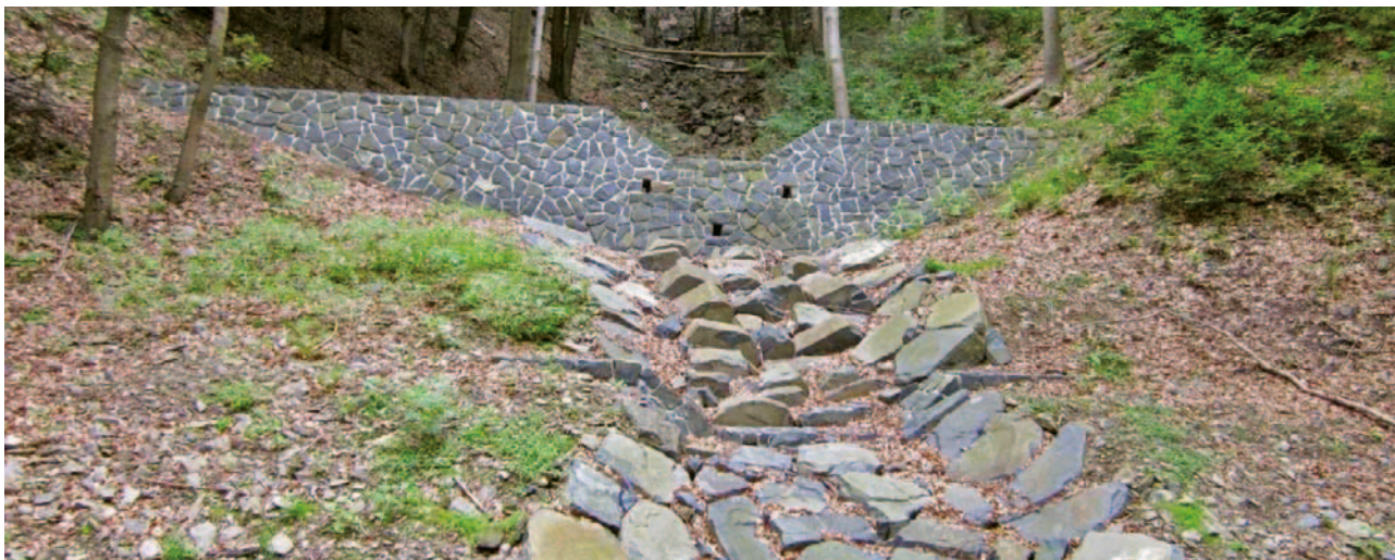
Obrázek 4-19: Pohled proti vodě na tížnou přehrážku provedenou z režného zdiva, patrná je stabilizace strže v horském svahu. Jedná se o suchou, kamenitou strž bez stabilních průtoků. Přehrážka má velmi dlouhá zavazovací křídla, spadiště je zpevněno jako hrubý balvanitý skluz s vysokou drsností pro tlumení energie dopadající vody. Na fotografii je zároveň patrný stabilizační pas, který ukončuje ze spodní strany balvanitý skluz, který dále navazuje na odtokové koryto pod pasem zpevněné ve běhu hrubou kamennou dlažbou s vyklínováním. Jedná se o stabilizaci strže nad chráněným úsekem, kde je ve strži postavena retenční přehrážka, na ní navazuje zpevněné spadiště a relativně krátký úsek upraveného koryta. V současné době se k dlouhým podélným stabilizacím a k úpravám koryt v nové trase přistupuje velmi zřídka, a to pouze v místech poškozených velkou vodou, kde u břehu hrozí po dalším průchodu velkých povodňových průtoků opětovné poškození, či v místě, kde bystřina protéká podél dopravní infrastruktury nebo intravilánem. Profilová úprava koryta navazuje většinou např. na retenční objekt postavený nad obcí.
