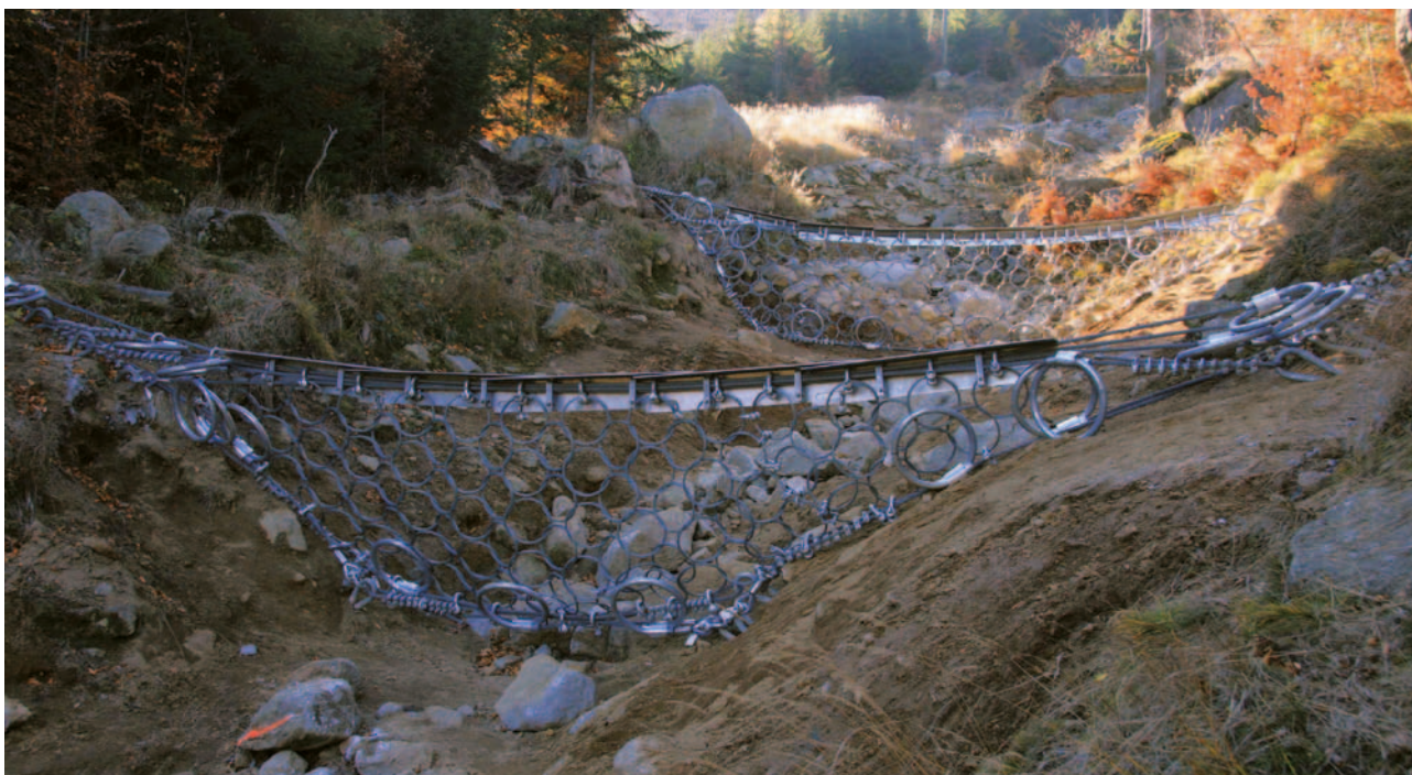
Obrázek 4-67: GEOBRUGG systém použitý pro hrazení strže na Smědavské hoře. Systém je tvořen soustavou dvou flexibilních dynamických bariér umístěných ve svahu kamenné strže. Patrná je kruhová síť uchycená na nosná lana, v přední horní části bariéry jsou patrné brzdné kruhy. Dynamická bariéra se používá hlavně z důvodu zastavení chodu velkých splavenin, padání uvolněných kamenů, popř. se dá použít na zachytávání splaví.
