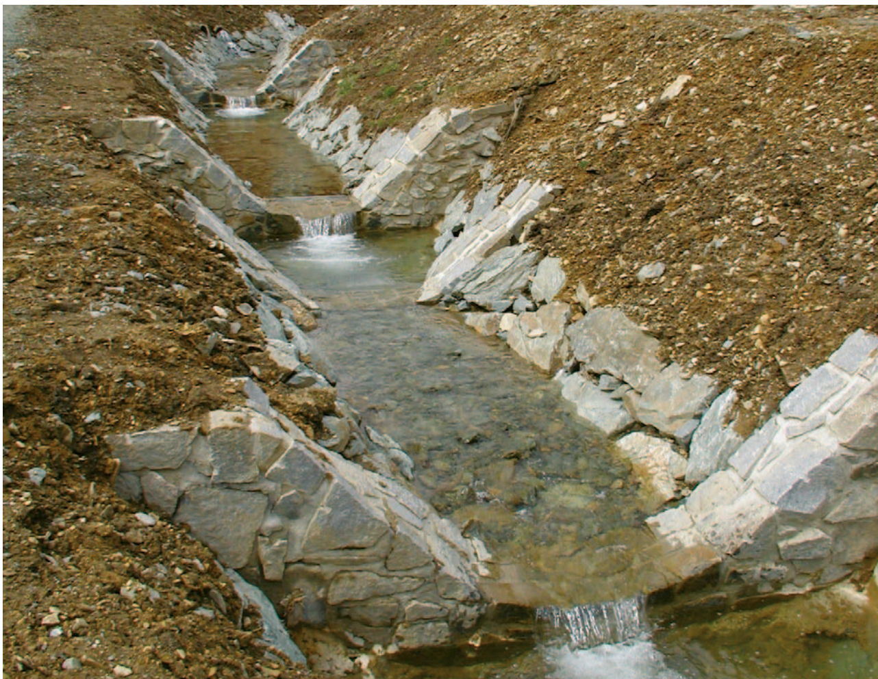
Obrázek 4-10: Pohled proti vodě na soustavu zděných prahů s vývařisti. Mezi jednotlivými stabilizačními prahy a pasy je koryto zpevněno kamennou rovnaninou v březích, doplněnou o kombinaci záhozu a pohozu dna. Jedná se o tvrdou úpravu pomocí zděných prahů, pravděpodobně byla požadována stabilizace koryta v místě, kde při povodni došlo k zahloubení koryta. Jednotlivé objekty a jejich spadiště, resp. vývařisti je nutné hydrotechnicky posoudit a zároveň výpočtem ověřit hloubku a délku jednotlivých vývařistě, resp. stabilizovaných výmolů. Zároveň je nutné posoudit výšku navrhovaného opevnění a následného přechodu ve svah. Na fotografii je zjevné i rozšíření profilu na povodní straně zděných pasů. Kamenné nadzákladové zdivo svou kvalitou a provedeným spárováním neodpovídá požadavkům daným normou pro kamenné zdivo.
