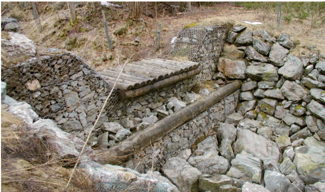
Obrázek 4-32: Detail na zpevnění přelivu a nižších gabionových sekcí pomocí kmene a ochranného kamenného záhozu. Koše jsou na koruně a v březích zpevněny kamennou rovnatinou, dno je provedeno jako balvanitý skluz.
