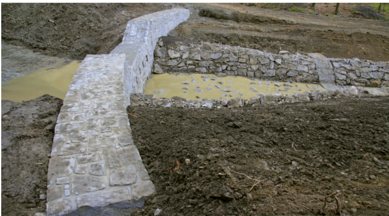
Obrázek 4-25: Pohled na retenční přehrážku z režného kamenného zdiva s obdélníkovými průřeznými otvory. Klenba (resp. půdorysné zakřivení tělesa přehrážky) staticky nevyužívá efektu klenby, jedná se pouze o tvarovou úpravu přelivu a snahu o usměrnění přepadového paprsku do spadiště. Na konci spadiště proveden stabilizační zděný pás a prostor mezi tělesem přehrážky a pasem je opevněn hrubou kamennou rovnatinou s vyklynáváním. Dno je provedeno jako hrubá kamenná dlažba, aby docházelo k tlumení energie protékající vody.
