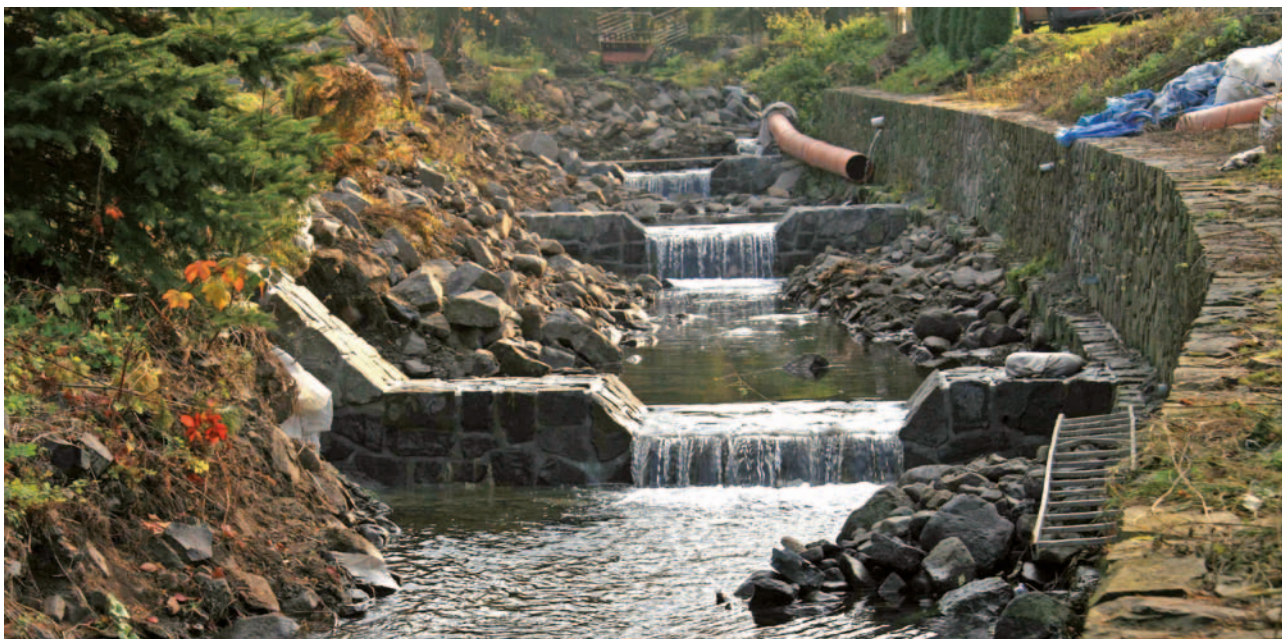
Obrázek 4-7: Pohled proti vodě na výstavbu soustavy stabilizačních prahů s kynetou pro převod běžných průtoků; mezi prahey proveden zához ve dně, břehy opevněny opěrnou zdí a kamennou rovinaninou.
