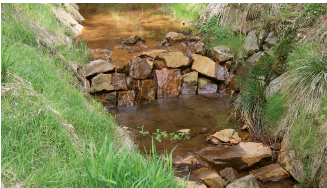
Obrázek 4-8: Pohled na úpravu podélného sklonu pomocí kamenného prahu z kamenné rovinaniny na suchu, která plynně přechází ve stabilizovaný výmol. Jedná se o přírodní blízký prvek bez použití cementu. Objekt je vhodný do pramenných lokalit horských a podhorských potoků, kde je požadována úprava koryta přírodním způsobem.
