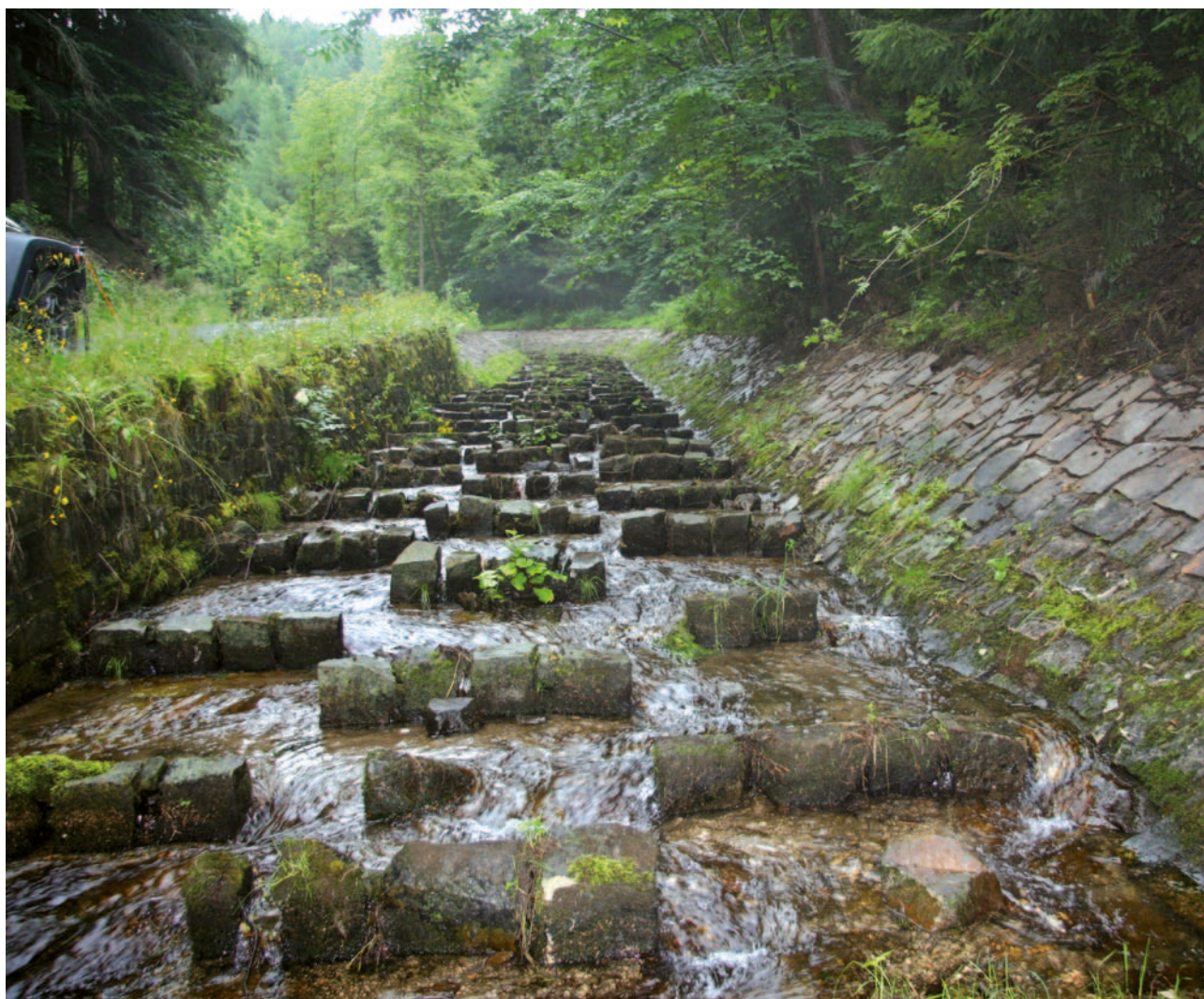
Obrázek 4-48: Koryto horské bystřiny s úpravou pro zvýšení drsnosti pomocí umělých rozvaděčů vytvářejících šachovou figuru vystupujících žulových kostek, kamenných kvádrů nebo kopáků (kotvení do dna je nutné na minimálně polovinu výšky kamene). Původní lichoběžníkový profil koryta zpevněný v březích i ve dně kamennou dlažbou na cementovou maltu s vyspárováním přechází v místě přiblížení se k silnici v opěrnou zeď stavěnou z hrubého rádkového zdiva. Celkově se jedná o úpravu podélného i směrového vedení koryta. V současné době se při hrazení bystřin tato úprava z důvodu její tvrdosti a čistě technického charakteru nepoužívá.
