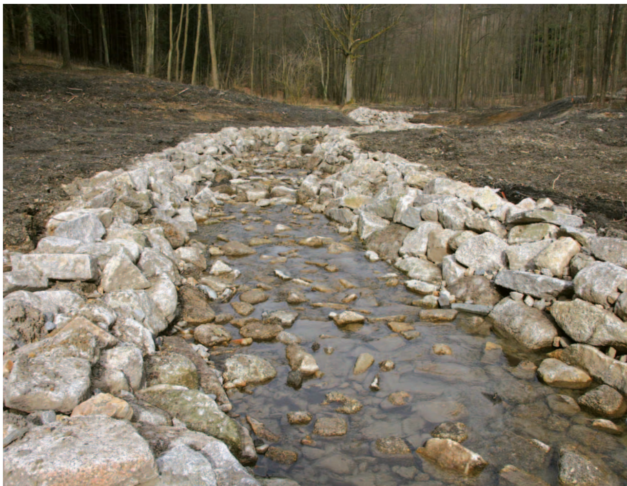
Obrázek 4-51: Pohled na přeložku koryta bystřiny zpět do údolnice. Profil koryta má po úpravě zachovánu velkou drsnost (používané kamenné figury bez urovnění líce tlumí pohybovou energii vody). Rovnanina je provedena štětováním kamene do břehu s tím, že spodní kameny jsou zhruba z poloviny uloženy nad niveletu dna a linii běžných průtoků, nedochází tak k vytvoření průběžné spáry mezi dnem a břehem. Při vytváření rovnaniny se zpevněným dnem je nutné eliminovat průběžné dnové spáry (jako první se provede založení rovna-niny břehu, následně se pokračuje s vytvořením zpevnění dna a teprve poté se dodělává nadzákladová rovnanina).
