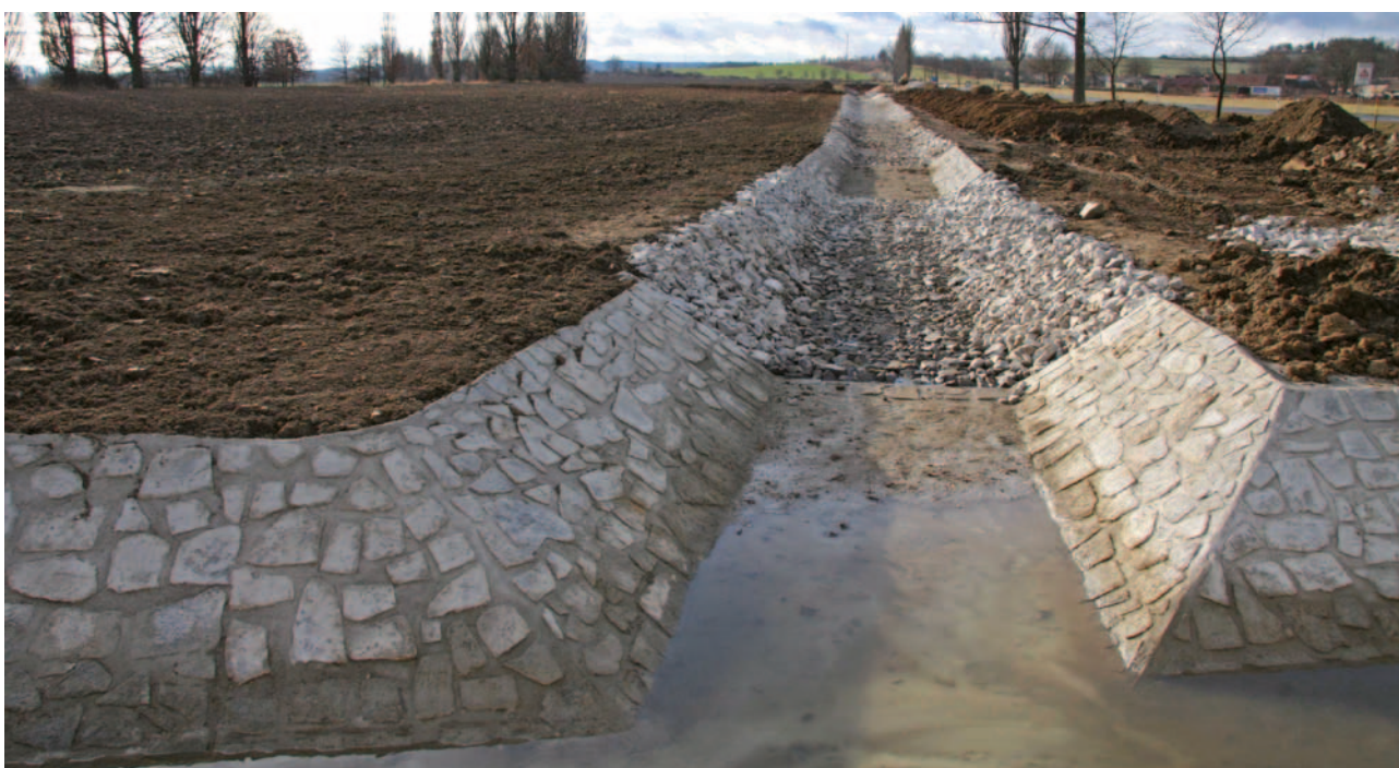
Obrázek 4-46: Opevnění dna a břehů pomocí kamenné dlažby do betonu, místy úprava pomocí kamenného pohozu.
