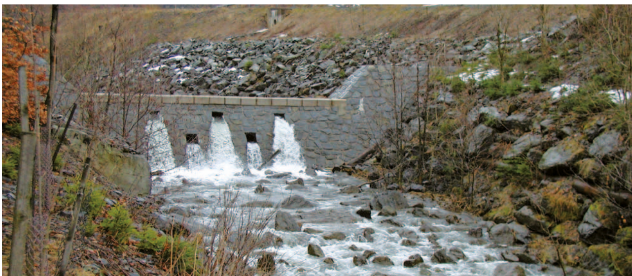
Obrázek 4-20: Pohled proti vodě na tížnou betonovou přehrážku s obkladem z režného kamenného zdiva, přelivná hrana provedena z kamenných kvádrů předsazených před korunu přelivu zhruba o 10 cm. V tělese přehrážky jsou patrné dvě výškové úrovně obdélníkových průřezných otvorů obložených kamenem. Problematické u obdélníkových průřezných otvorů je jejich technické provedení. V případě, že se jedná o celozděné těleso, je nutné u průřezných otvorů vytvořit kamenné ostění a překlad z kamene tak, aby nedocházelo k protékání vody konstrukcí přehrážky. Břehy a dno jsou ve spadišti opevněné kamennou rovnatinou, resp. hrubým kamenným záhozem charakteru velmi hrubého balvanitého skluzu.
