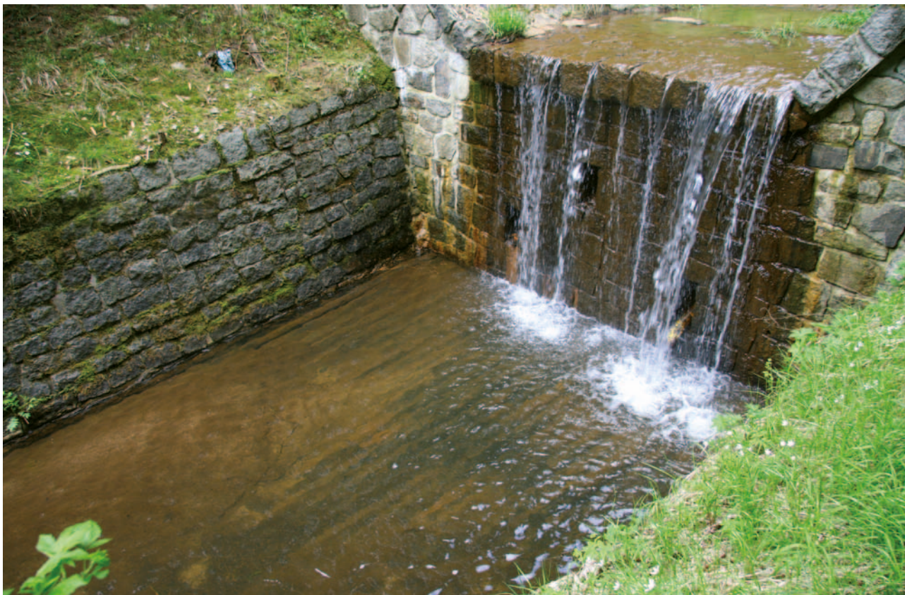
Obrázek 4-14: Pohled na konstrukci stupně se spádovou výškou kolem 2 m a zpevněním spadiště pomocí tyčoviny. Jedná se o historický objekt s předsazenou přelivnou hranou, zpevněnou pomocí kamenných desek, s břehy opevněnými kamenným zdivem. V konstrukci stupně jsou patrné odvodňovací otvory, spadiště je zpevněné tyčovinou (v současné době se provádí pouze u historických oprav většinou z důvodu možného porušení tyčí v případě průchodu velkých splavenin a jejich dopadu do spadiště). Uvedené opevnění dna je vhodné pouze v případě, že je zajištěna stabilní hloubka vody (např. díky mírnému protisklonu spadiště) nebo v případě, že korytem neprochází splaveniny větší než 15 cm.
