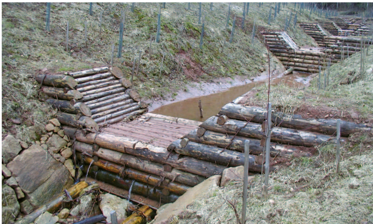
Obrázek 4-38: Pohled proti vodě na soustavu konsolidačních srubových přehrážek. Srubová konstrukce je provedena na sraz ze smrkové kulatiny. Podélné výřezy na sebe přímo navazují, příčná tyčovina, která stabilizuje a provazuje konstrukci, je tesařsky zavázána do jednotlivých kmenů. Zároveň je patrná ochranná konstrukce přelivu provedená z dřevěné tyčoviny uložené podélně i příčně. Dno je zpevněno kamennou rovnatinou, která je v patě zajištěna podélným kmenem. Trvanlivost těchto konstrukcí bez zajištěných stabilních a nekolísavých průtoků vody přes přeliv se pohybuje okolo 10–15 let, pak je nutné srub obnovit nebo nahradit objektem z kamenného zdiva.
