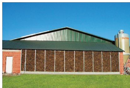
Obrázek 4 – Chemická pračka vzduchu s výstupním biofiltrem od společnosti Big Dutchman International GmbH.
