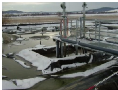
Obrázek 1 – Příklad zakrytí nepropustným materiálem (spol. Big Dutchman International GmbH.)
