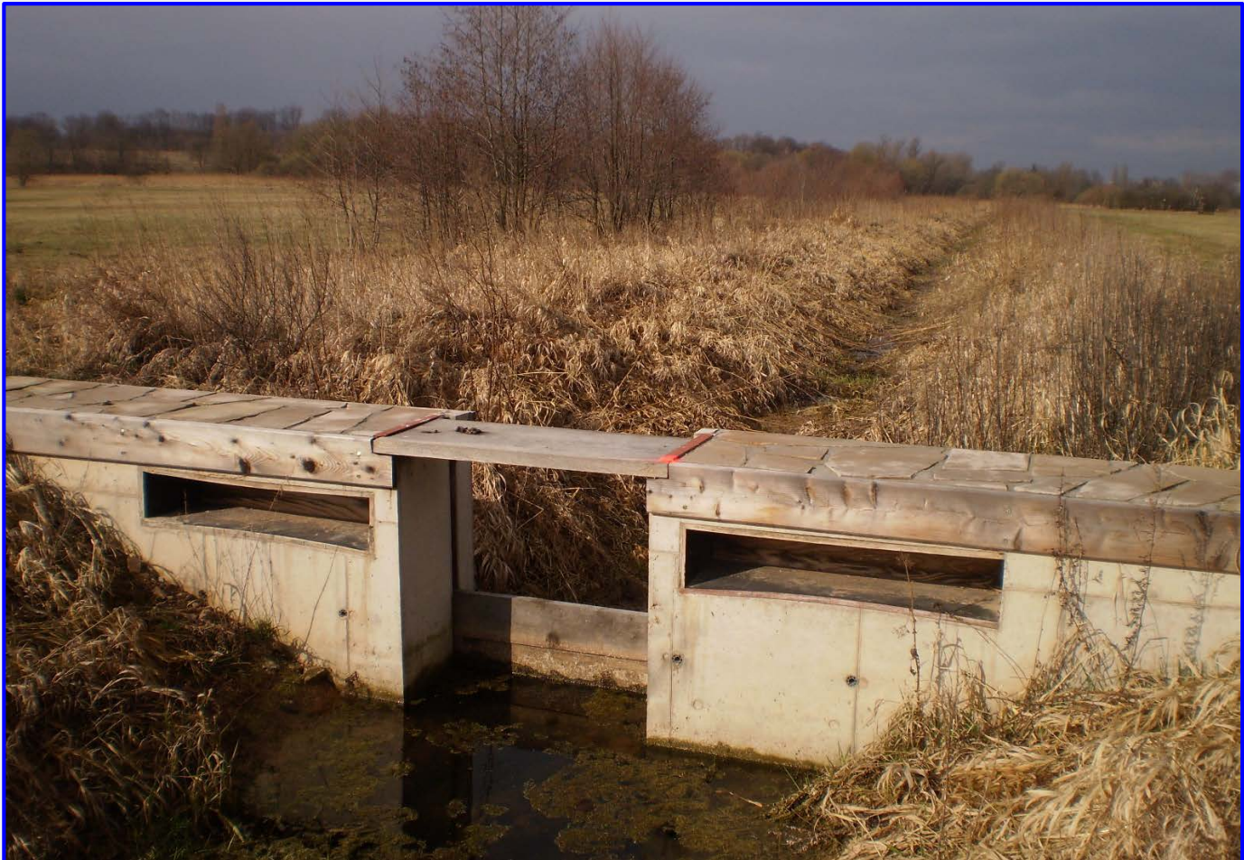
- rekonstruované hradítko na stavbě HZZ
