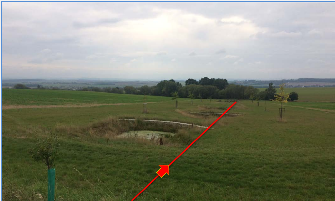
Ukázka výstavby tůní na zakrytém (trubním) kanále v rámci KoPÚ v k.ú. Hněvnice (pobočka Plzeň, se svolením Ing. Mazína)
