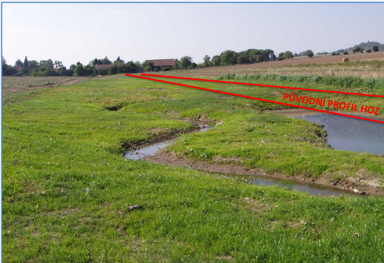
Revitalizace HOZ jako součást lokálního biokoridoru
