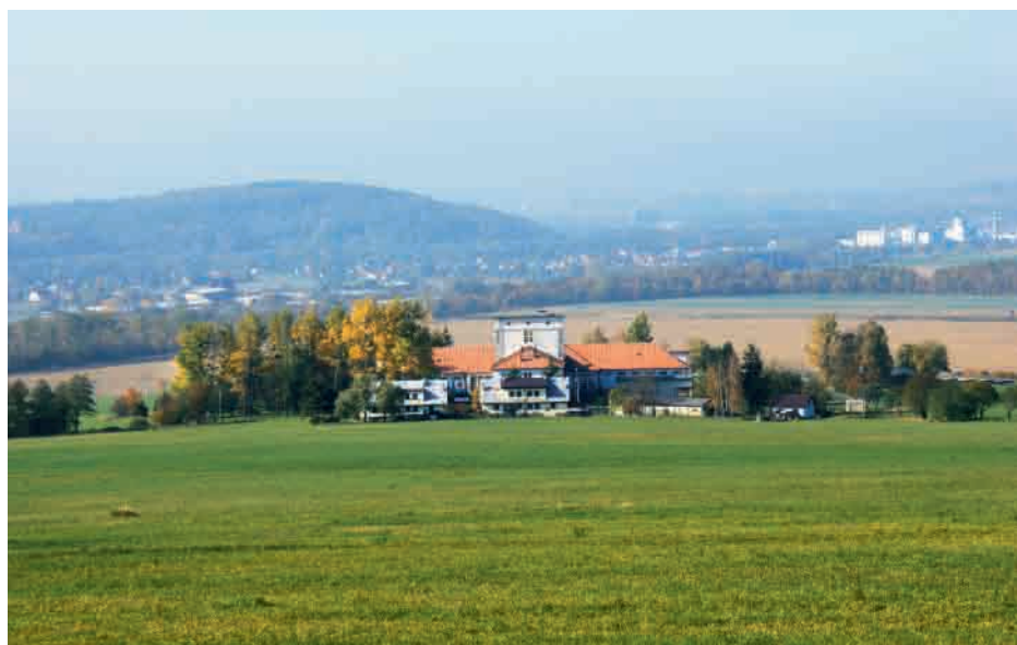
Úpravna vody Vyšní Lhoty
