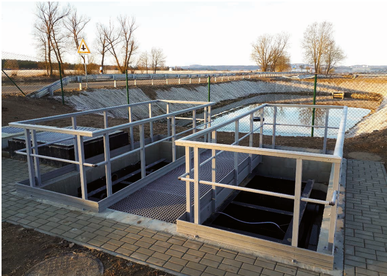
Jetětice – ČOV – financováno s podporou MZe 5,069 mil. Kč
