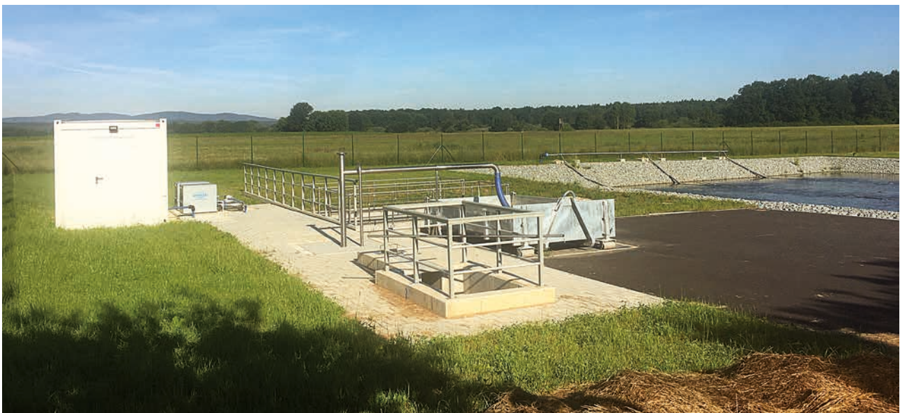
Branišov – kanalizace a ČOV – financováno s podporou MZe 14,781 mil. Kč
