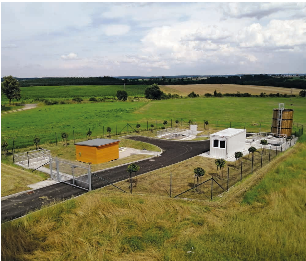
Radčice – kanalizace a ČOV – financováno s podporou MZe 12,189 mil. Kč
