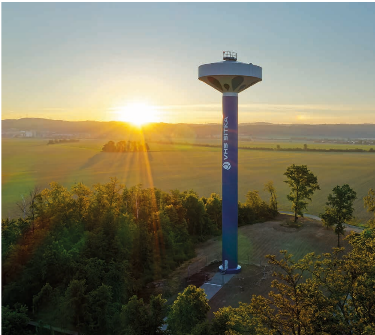
Stavba věžového vodojemu Moravská Huzová – spolufinancováno z dotačních prostředků MZe ve výši 9,133 mil. Kč
