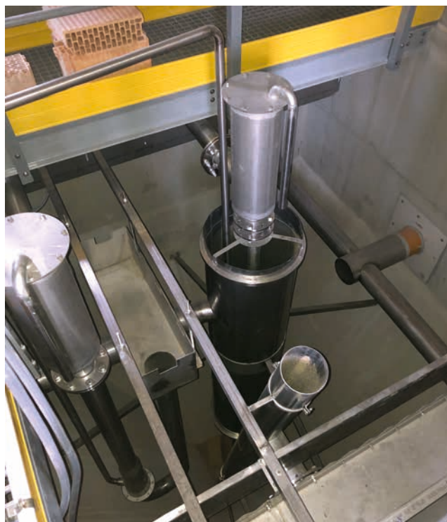
Kanalizace a ČOV v osadách Jankov a Holašovice – spolufinancováno z dotačních prostředků MZe ve výši 26,011 mil. Kč
