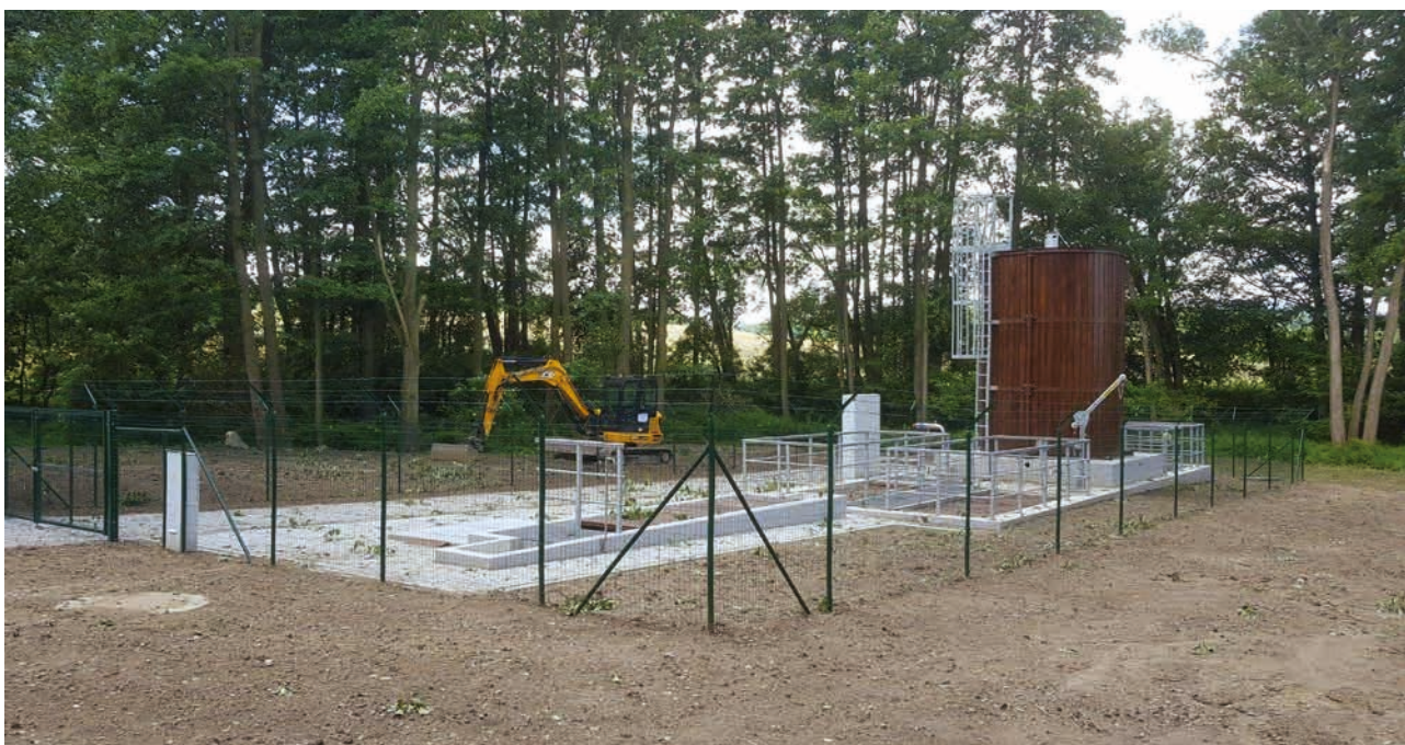
ČOV a kanalizace Čakov - spolufinancováno z dotačních prostředků MZe ve výši 16,088 mil. Kč
