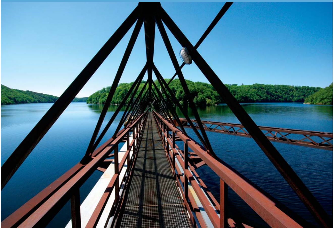
ČS surové vody Vranov
