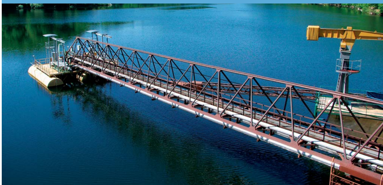
ČS surové vody Vranov
