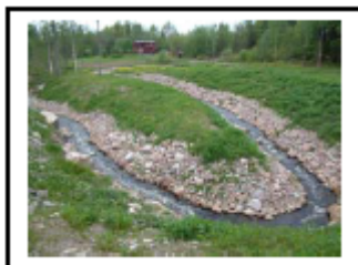
Nový rybí přechod u hydroelektrárny Finsjö
