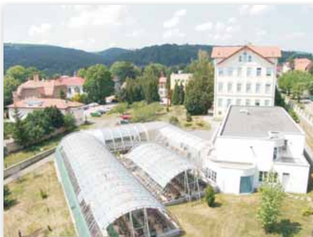
Obr. Areál ÚKZÚZ v Brně v současné době
