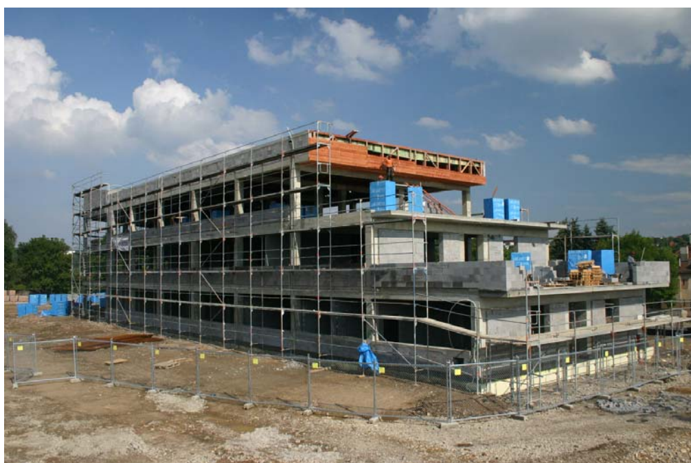
Výstavba administrativně vzdělávacího centra SRS v Praze-Ruzyni (Foto: Ing. B. Zbuzek)
