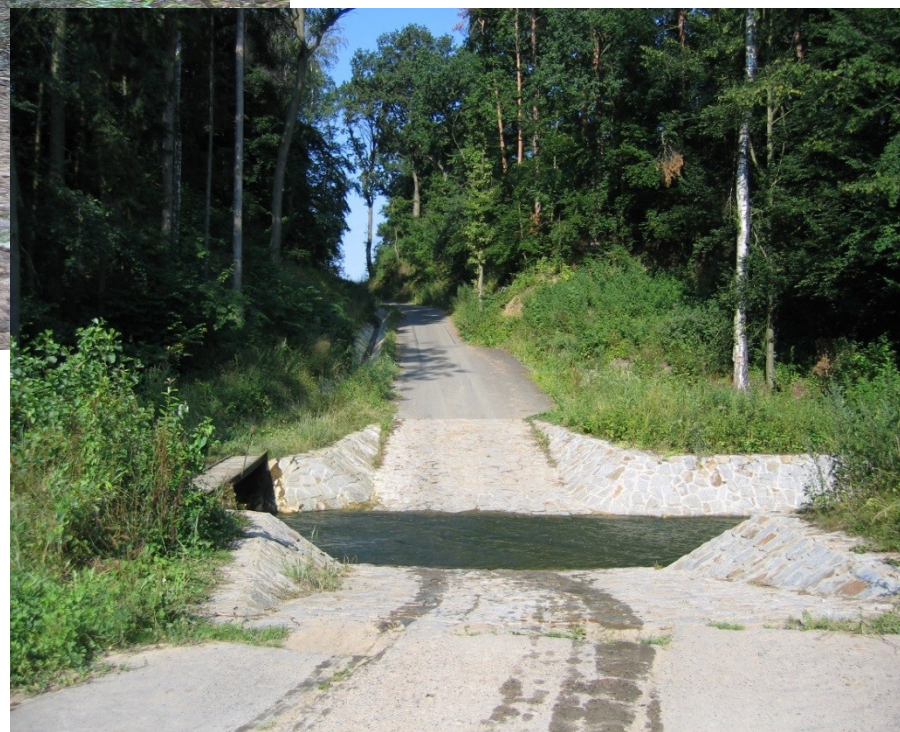
stav po realizaci k.ú. Skryje (okr. Havlíčkův Brod)
