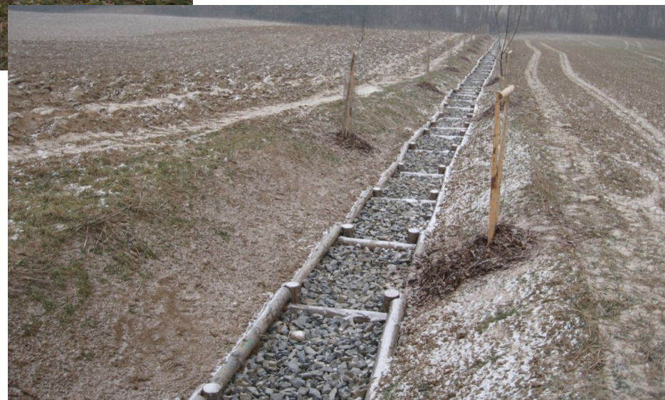
stav po realizaci k.ú. Lhotka u Zlína
