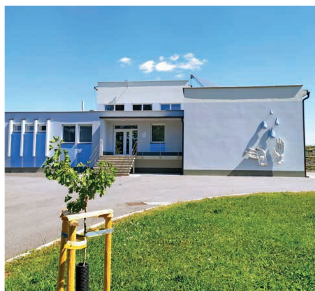
The Water Treatment Plant, Lázně Bělohrad (Author: Hubalová Petra)
