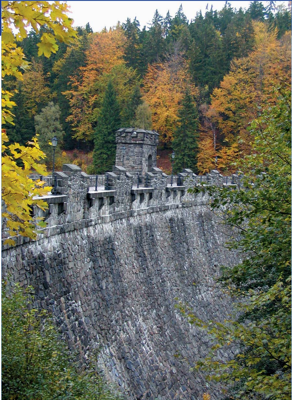
Kamenická water reservoir - Ohře river basin
