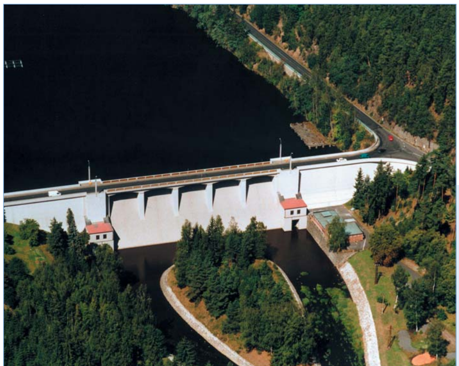
Březová water reservoir - Ohře river basin
