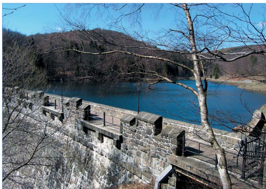
Kamenická water reservoir - Ohře river basin
