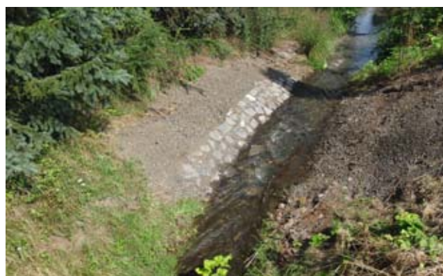
The Stream Srpina, Malé Březno – repair the streambed (source: Ohře River Basins, s. e.)
