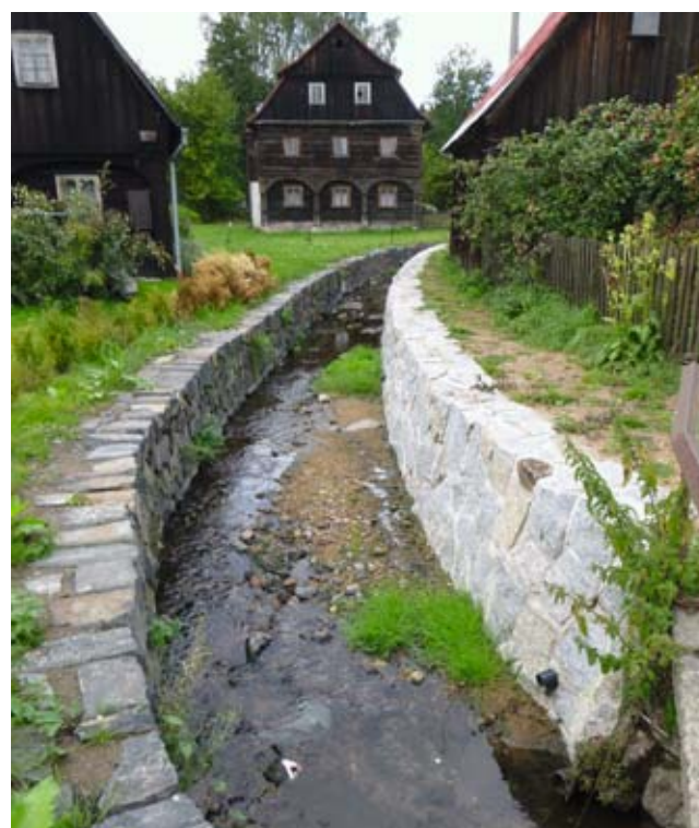
The Brtnický stream – revitalization flow (source: Ohře River Board, s. e.)
