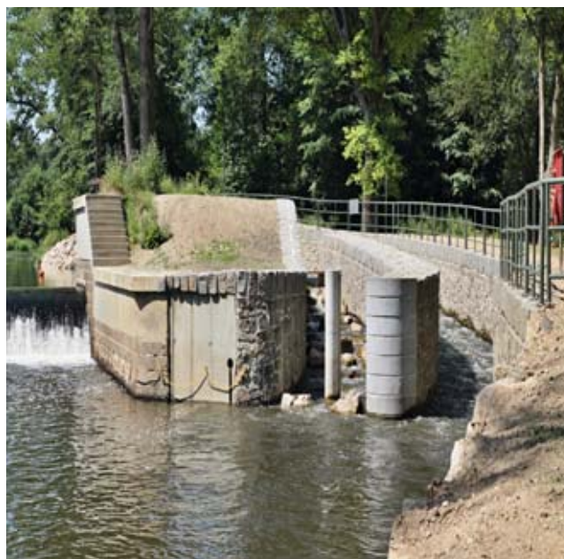
Fish crossing Černý Mlýn (source: Ohře River Board, s. e.)
