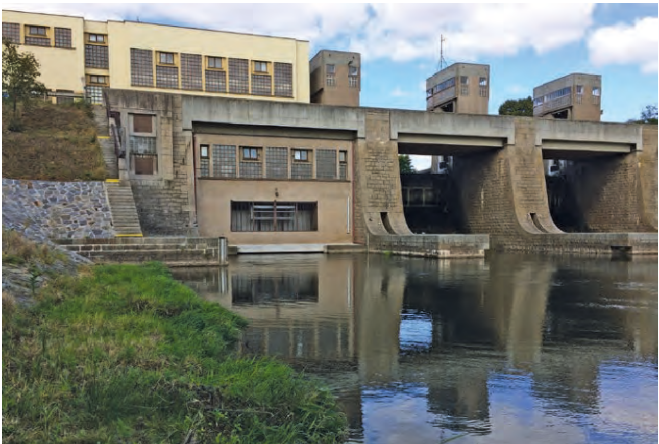
The Elbe River, the Předměřice nad Labem Weir (source: Elbe River Board, s. e.)
