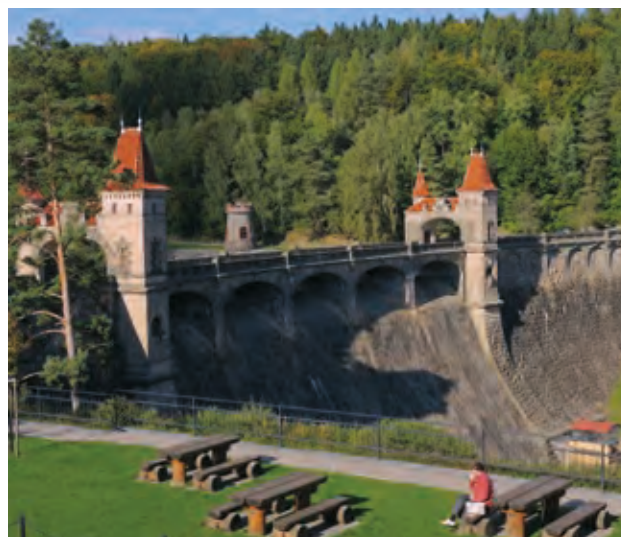
The Les Království Dam (source: Elbe River Board, s. e.)
