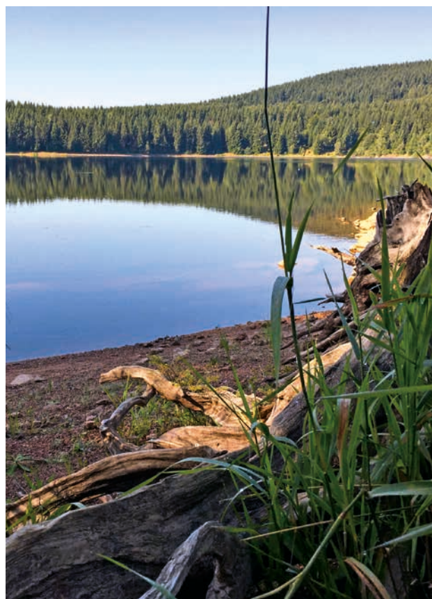
The Fláje Dam (source: Ohře River Board, s. e.)
