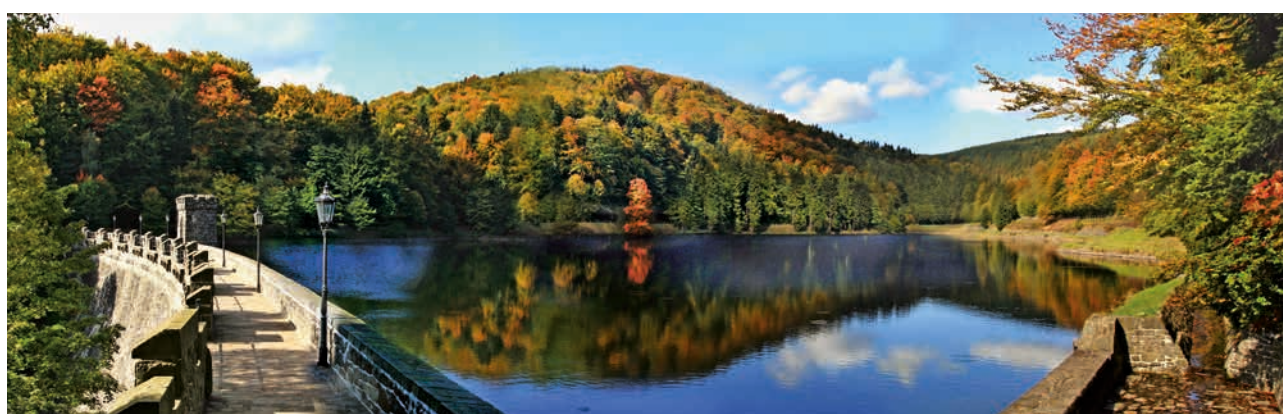
The Kamenická Dam (source: Ohře River board, s. e.)
