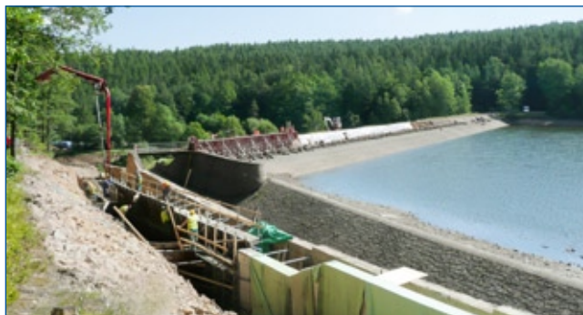
Zászkalská Reservoir – reconstruction
