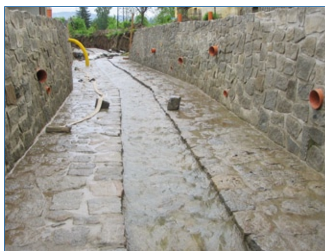
The Žižnětický stream channel capacity expansion in Nýrsko
