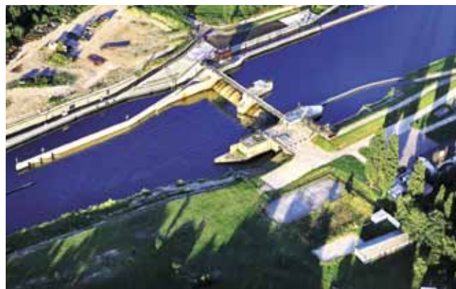
Hydraulic structure České Vrbné
