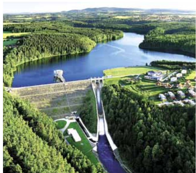
Hydraulic structure Řimov
