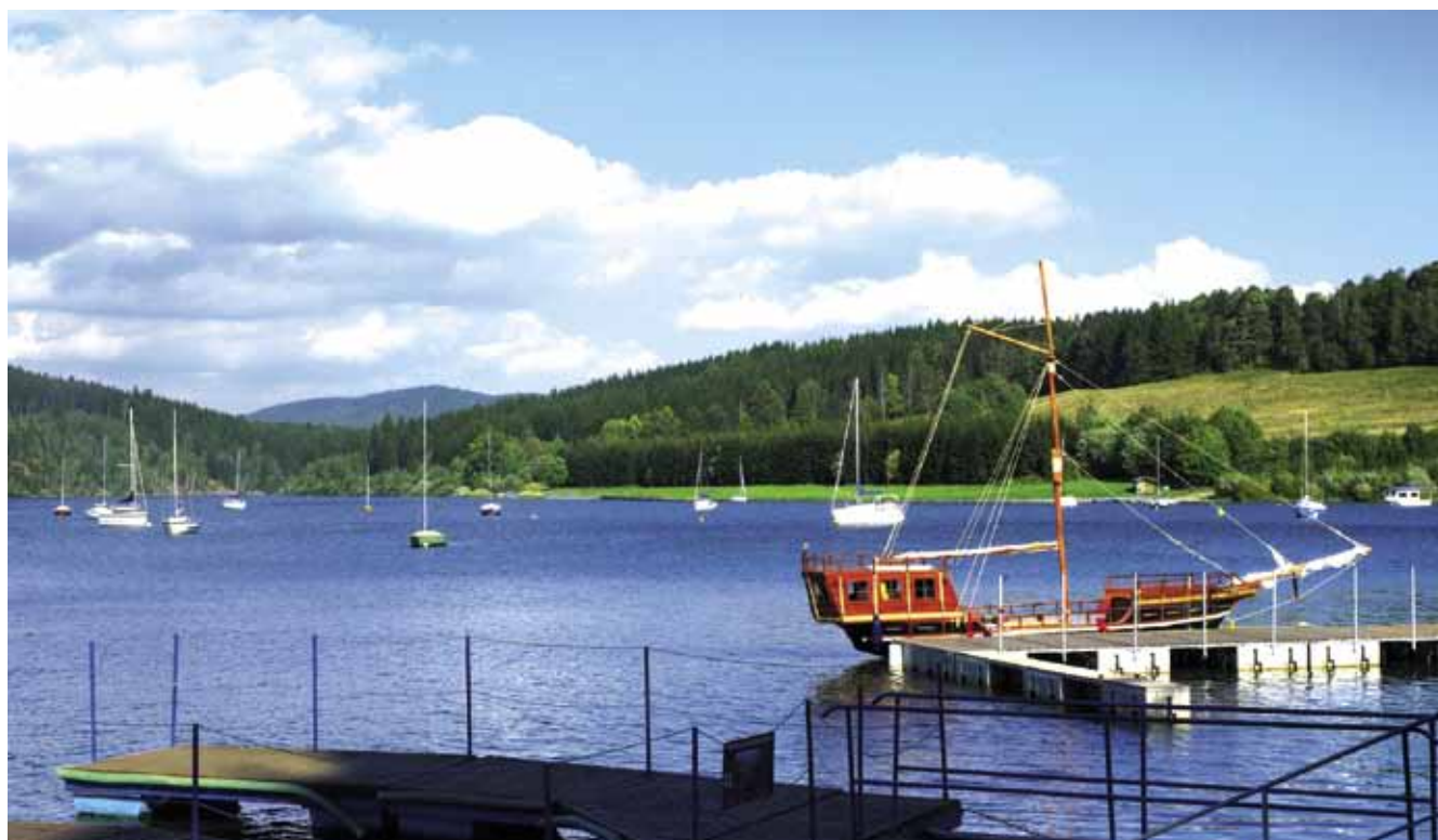
Hydraulic structure Slezská Harta
