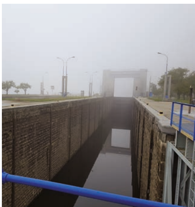
The Vrané na Vltavě Dam - Large Lock Chamber, the View of the Upper Gate (author: Březina Karel)
