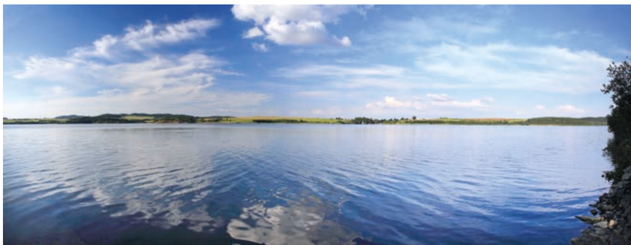
The Slezská Harta Dam (source: Oder River Board, s. e.)
