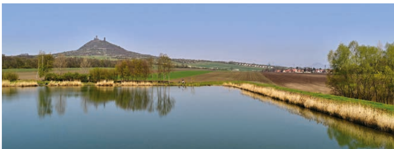
The Klapý Dam (source: Ohře River Board, s. e.)
