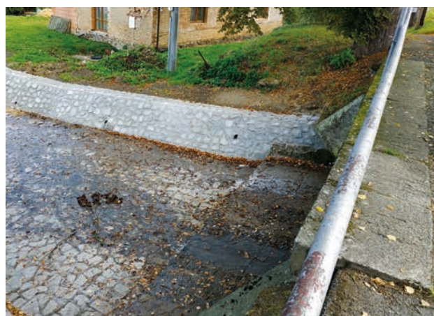
Příchovický Stream, Horšice, reinforcement after repair (Source: Vltava River Board)
